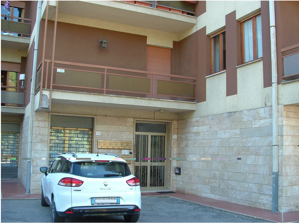
Accesso condominiale su area esterna di pertinenza comune
