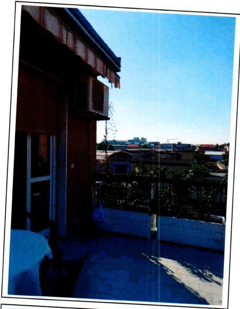
Fotografia n° 13 – Vista del terrazzo
