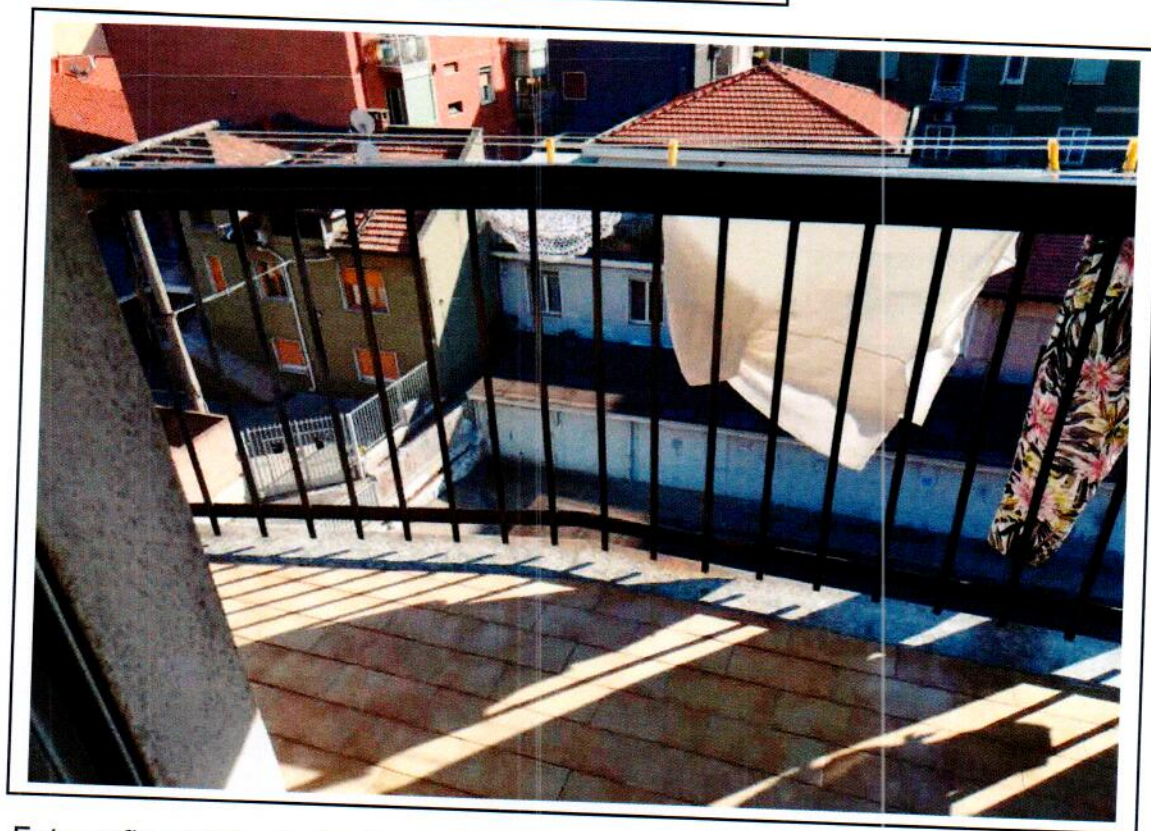
Fotografia n° 10 – Vista del balcone con accesso dalla zona pranzo
