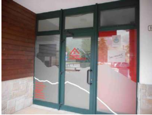
Unità P2 al piano terra.
