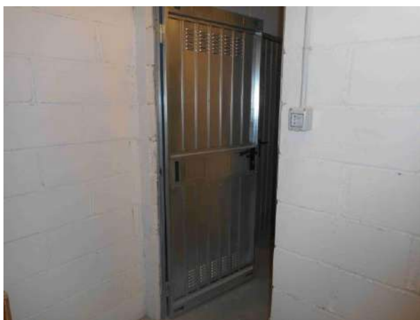
Ripostiglio P10 presso il fabbricato IL SASSO AIB.
