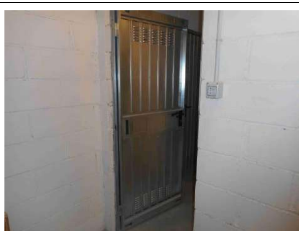
Ripostiglio P10 presso il fabbricato IL SASSO A1B.
