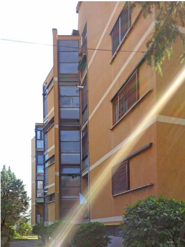
Foto 4. Facciata su cortile
