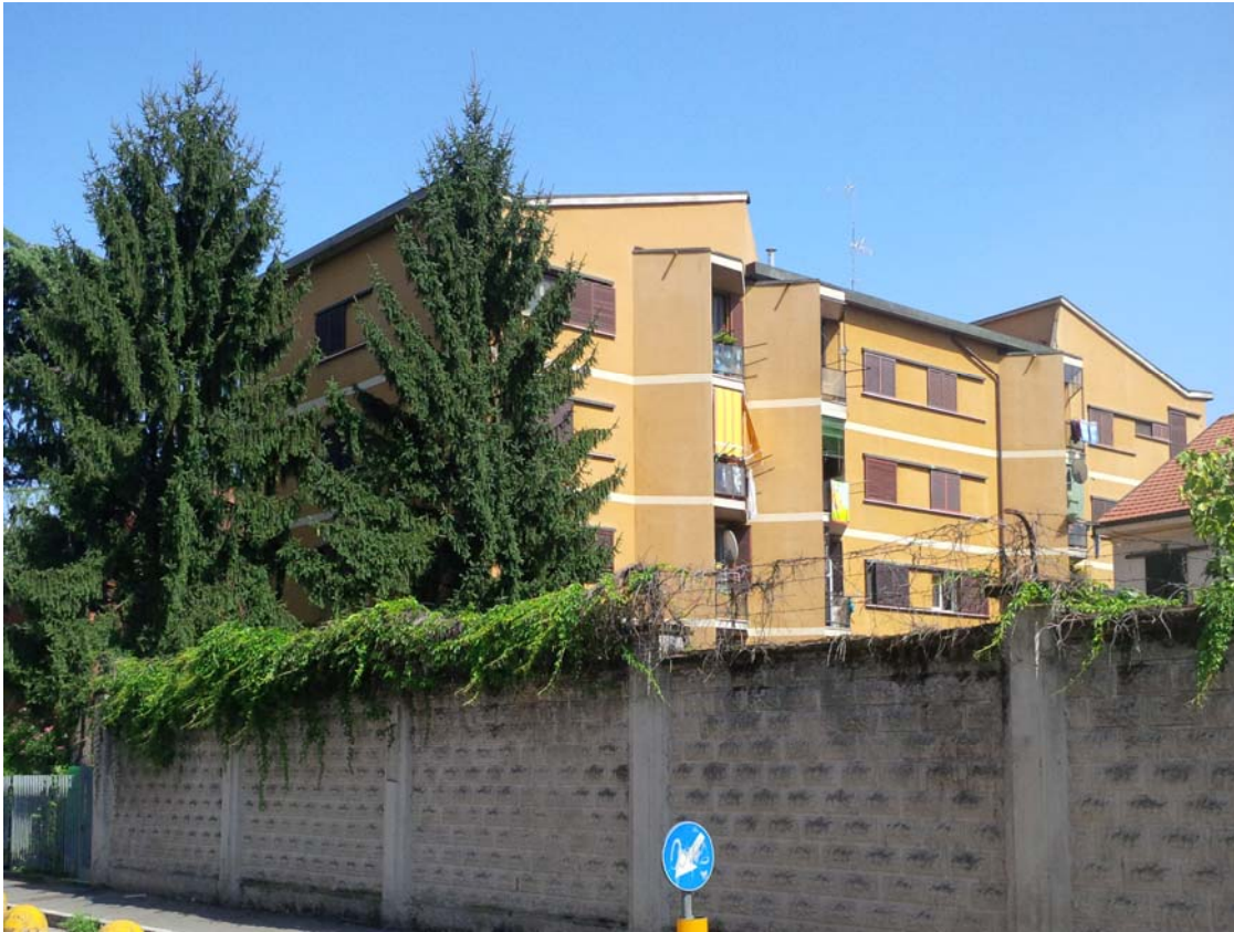
Foto 1. Vista del condominio da Via Copernico
