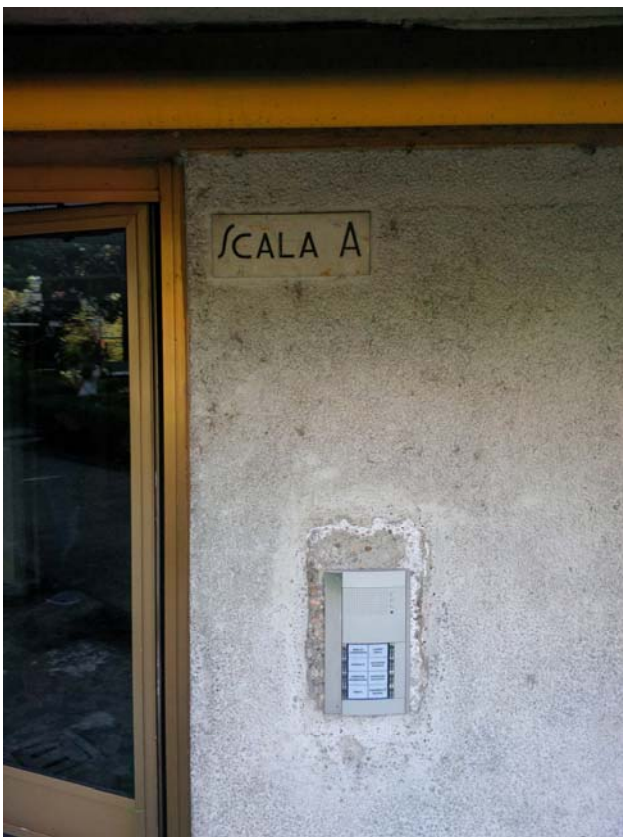
Foto 6. Accesso alla scala A
