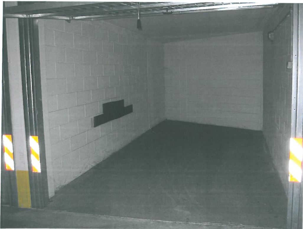
Vista interna autorimessa (sub. 43 P. 2° interrato)
