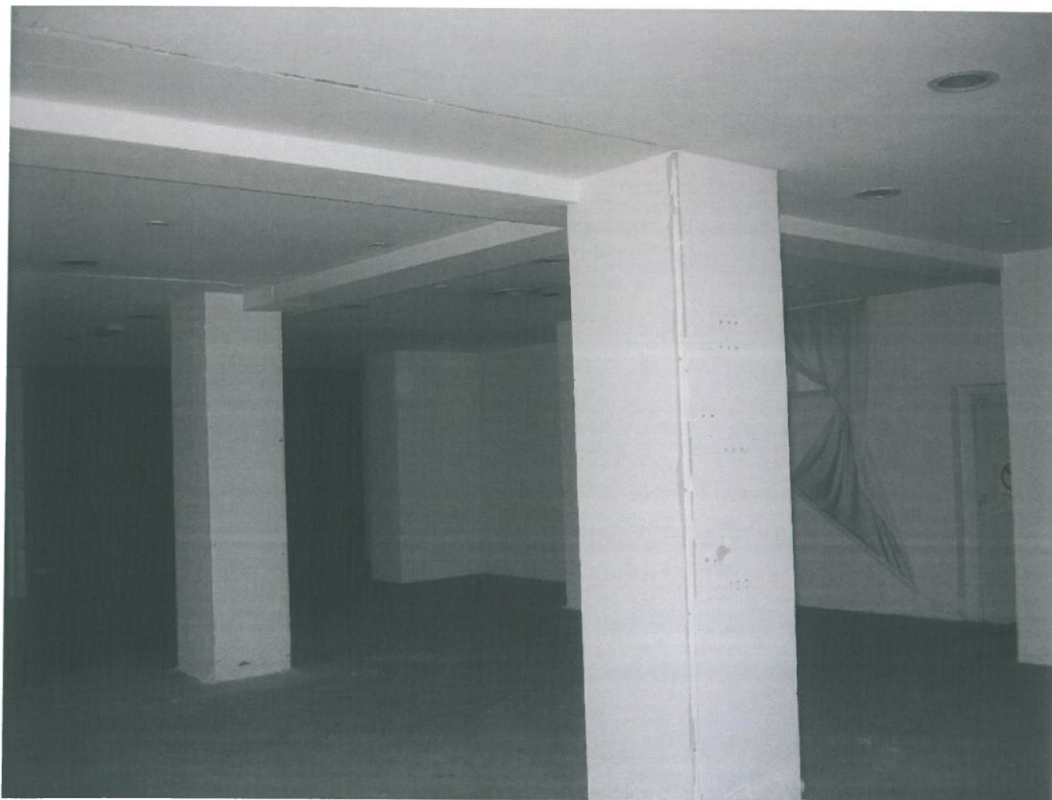
Vista interna piano interrato
