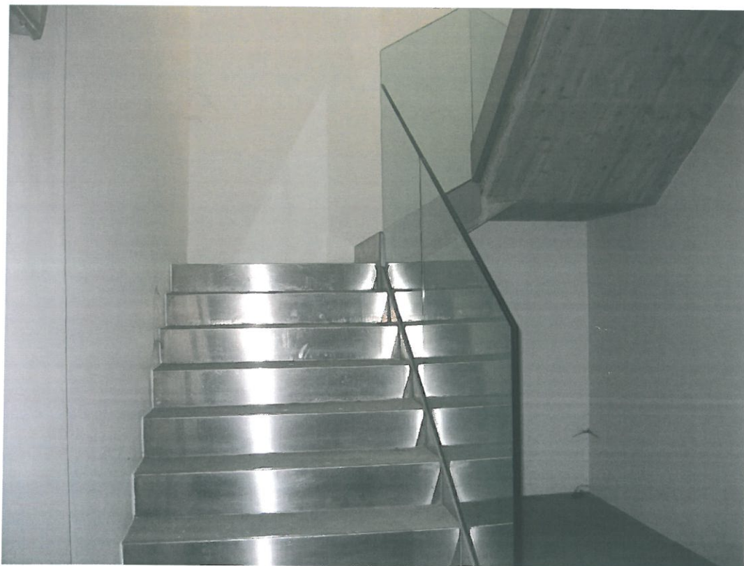
Vista scala interna tra il Piano S1 e il Piano terra
