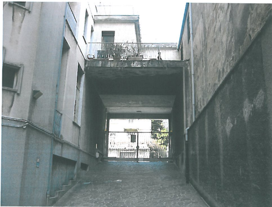
Vista rampa di accesso da Via Merini
