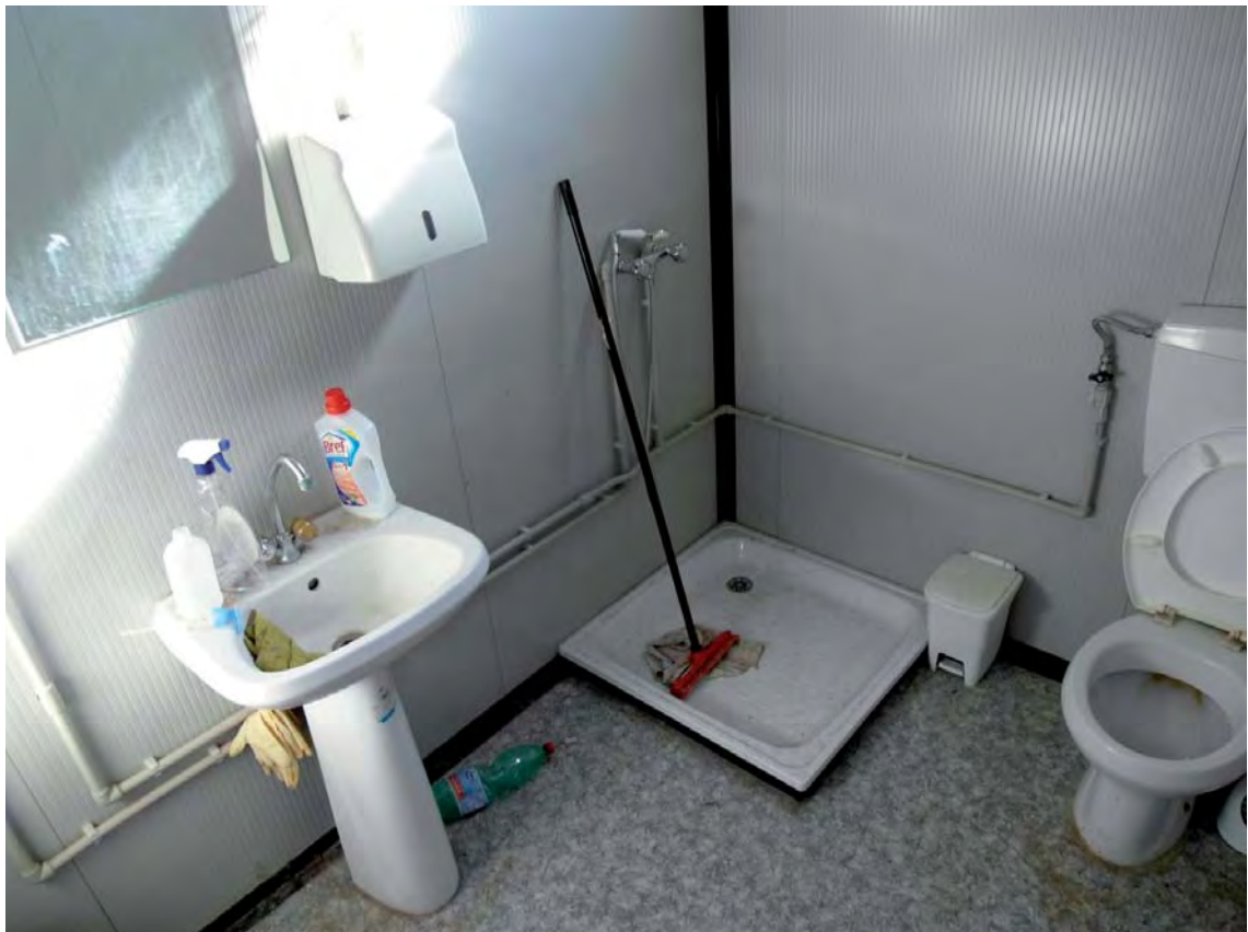
Foto n. 14: Bagno (box prefabbricato esterno).
