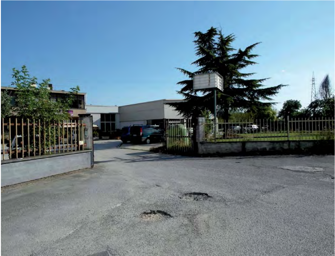
Foto n. 1: Accesso al fabbricato dal lato via Narni.
