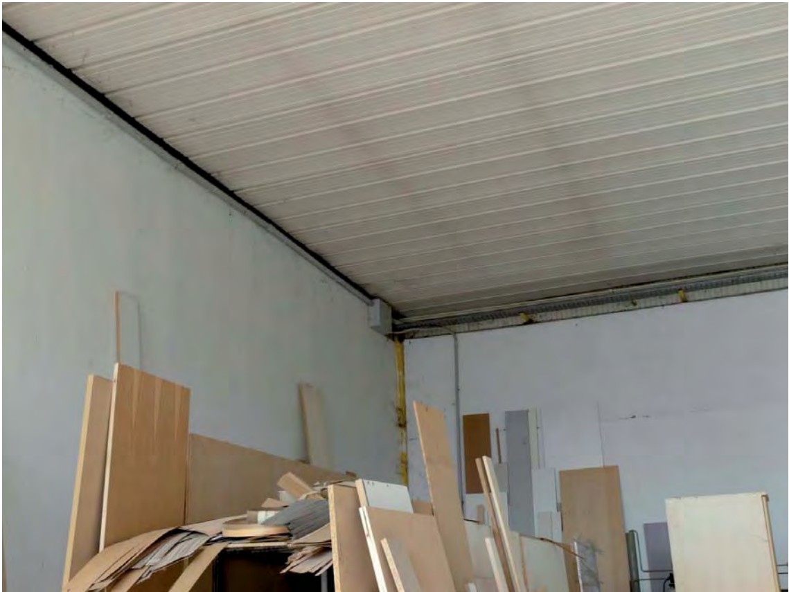
Foto n. 6: Particolare del soffitto.
