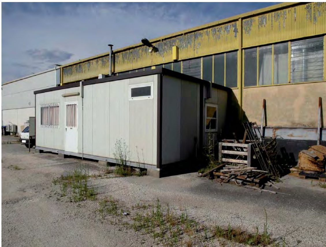
Foto n. 4: Box prefabbricato esterno uso ufficio e servizi.
