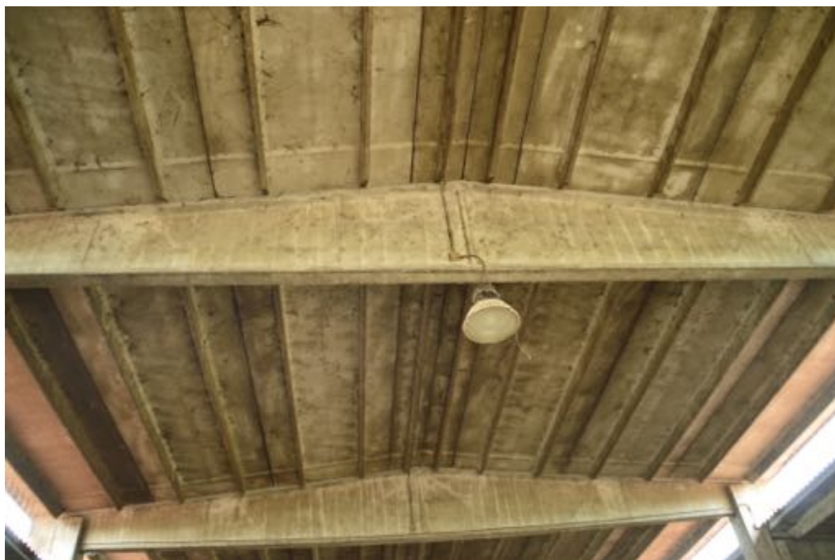
Foto 13– capriate della copertura
