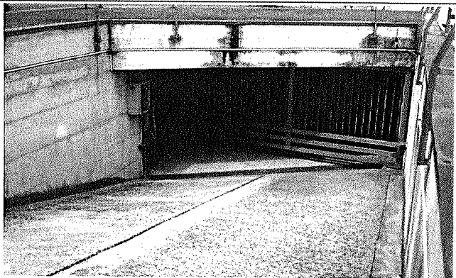
Rampa di accesso box interrati (sub. 1-2-3-4-5-6)
