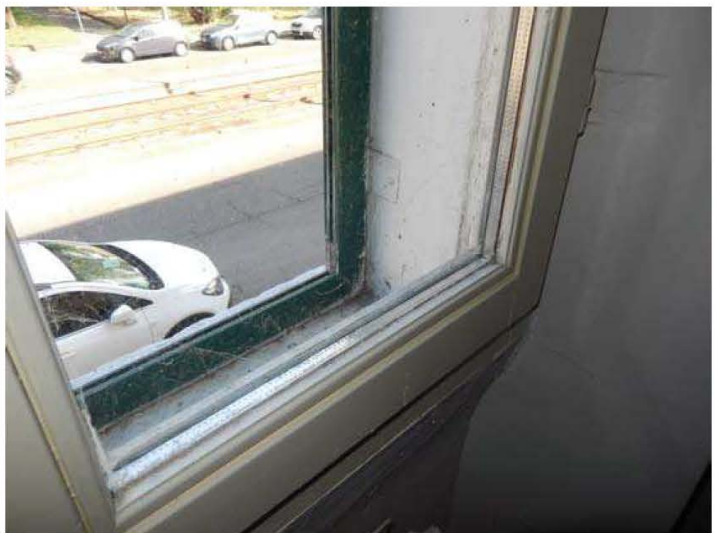
FOTO 19 e 20: Interno/esterno dell'unità pignorata – Dettaglio dei serramenti, dotati di vetrocamera.
