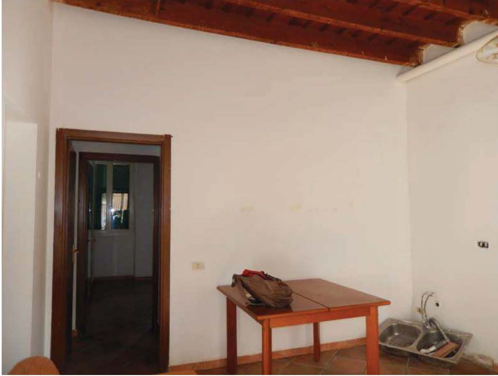
FOTO 9: Interno dell'unità pignorata – Ulteriore scorcio del locale cucina/soggiorno, con vista verso la zona notte.
