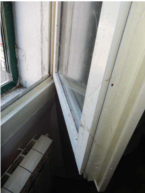
FOTO 19 e 20: Interno/esterno dell'unità pignorata – Dettaglio dei serramenti, dotati di vetrocamera.
