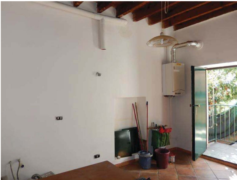
FOTO 10: Interno dell'unità pignorata – Ulteriore scorcio del locale cucina/soggiorno, con vista verso la porta d'ingresso e la parete su cui sono posizionati gli arrivi delle utenze cucina (acqua, gas etc.).
