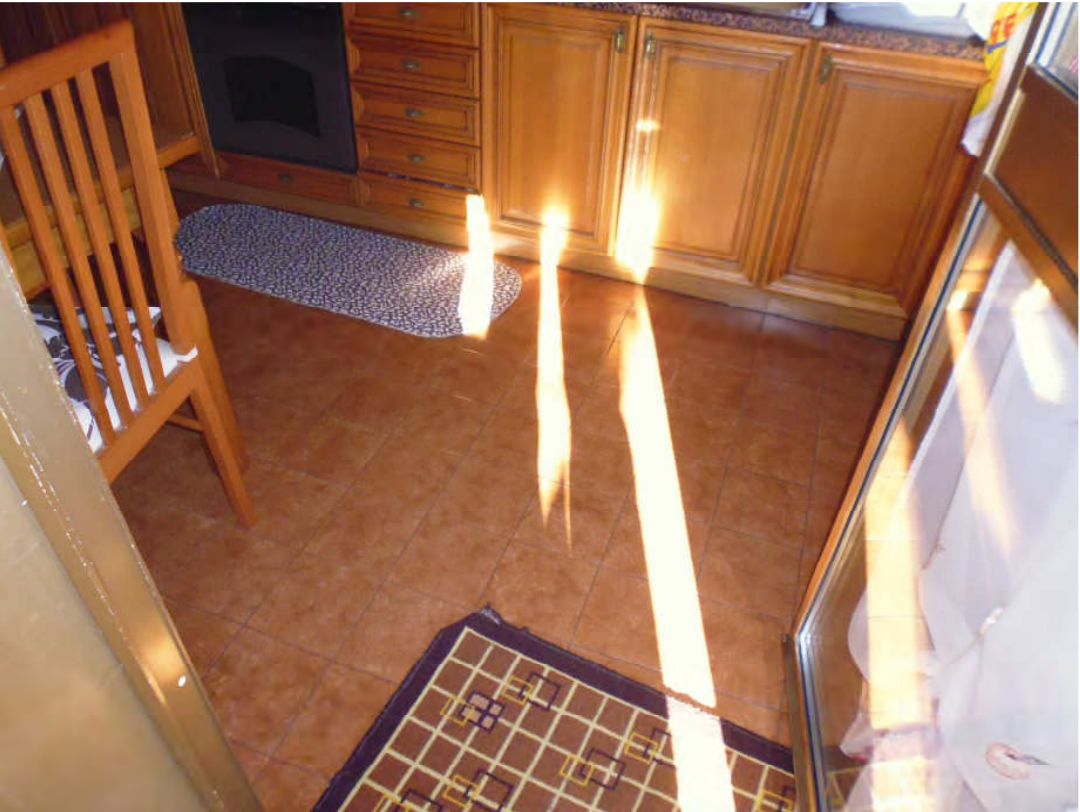
Particolare pavimento cucina
