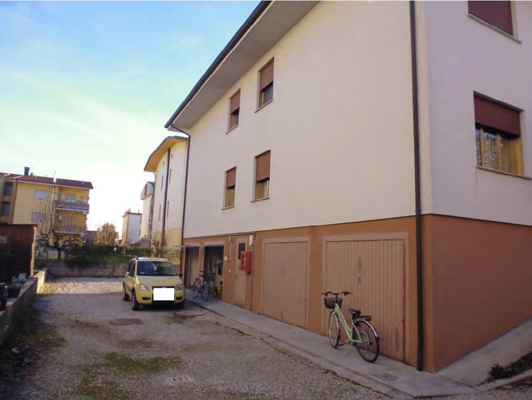
foto fabbricato lato nord
