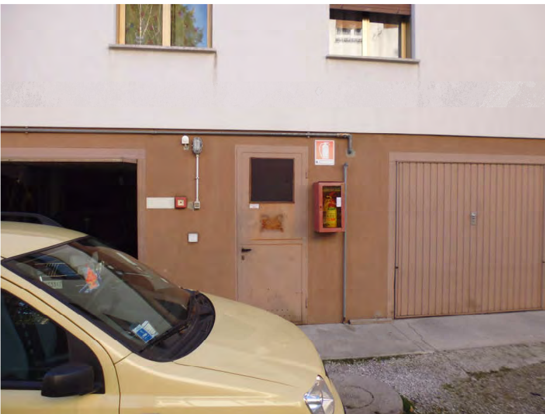
particolare ingresso c.t. condominiale
