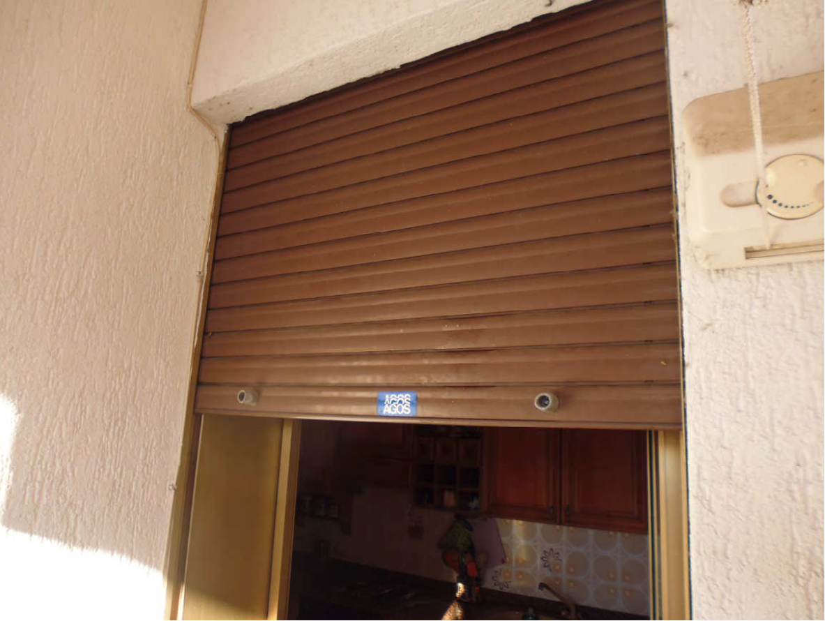
Particolare tapparelle esterne
