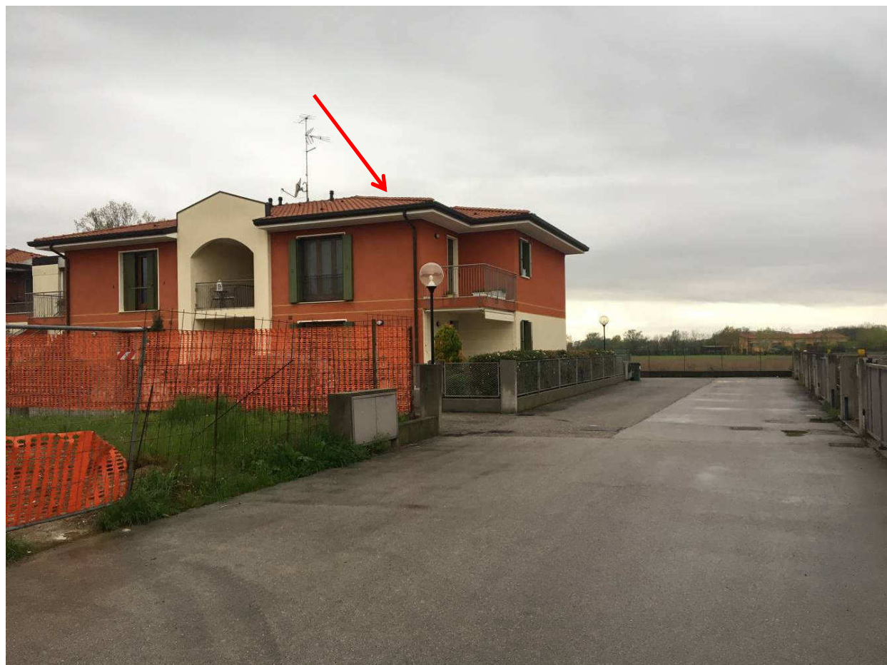
Foto n.2: Blocco B del complesso residenziale "Residenza 2000 - Macrolotto 3", dov'è ubicato l'appartamento oggetto di E.I., direttamente accessibile dalla strada di lottizzazione laterale alla via pubblica Favola.
