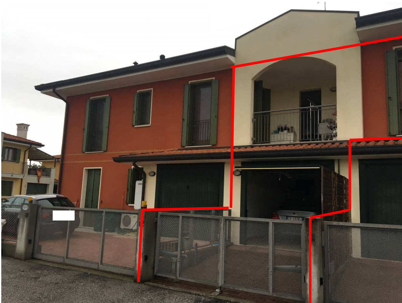
Foto n.5: Prospetto Ovest del Complesso Residenziale "Residenza 2000 - Macrolotto 3" con evidenziato l'Appartamento oggetto di E.I.
