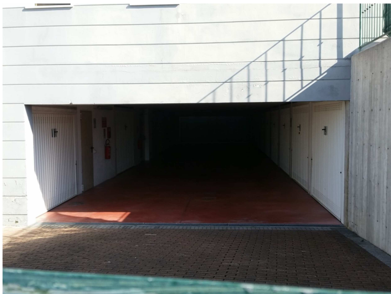
Ingresso carraio al condominio
