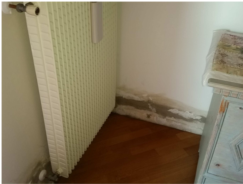
Il degrado interessa anche le pareti ortogonali a quelle a diretto contatto con la terrazza
