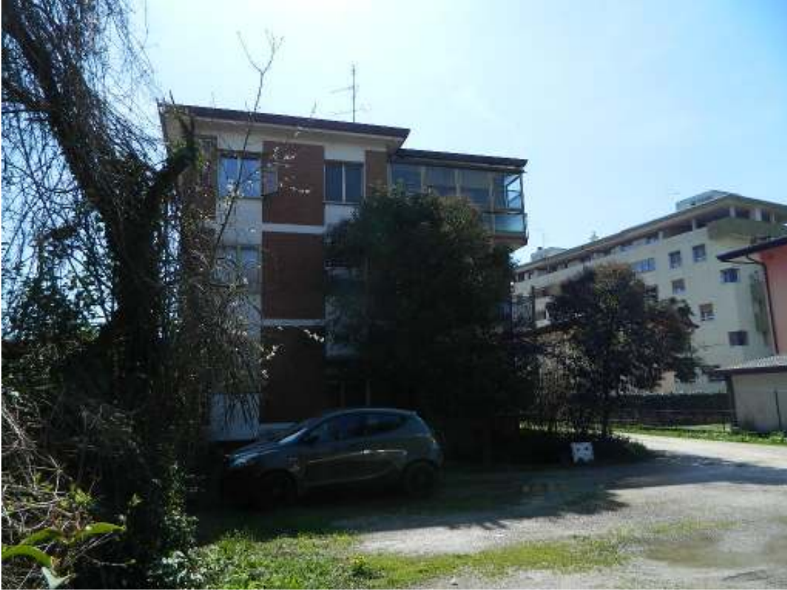
Foto n. 3 – Facciata nord ovest fabbricato condominiale.
