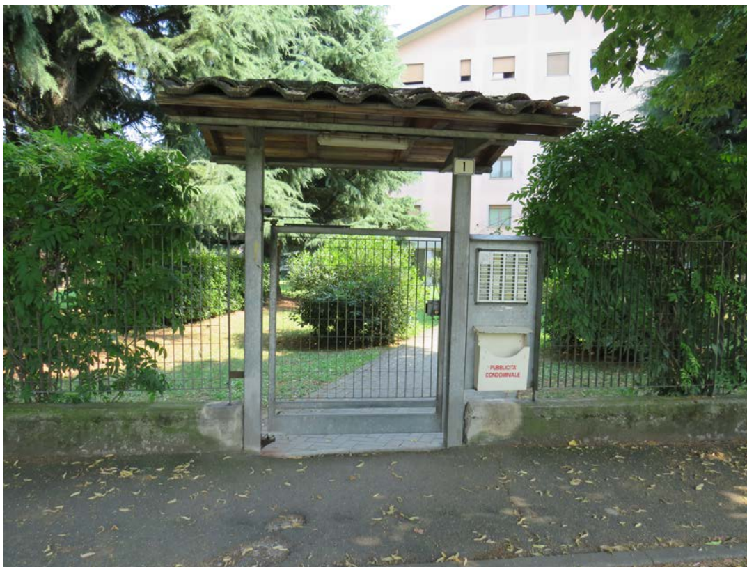
CANCELLO DI INGRESSO AL COMPLESSO IMMOBILIARE
