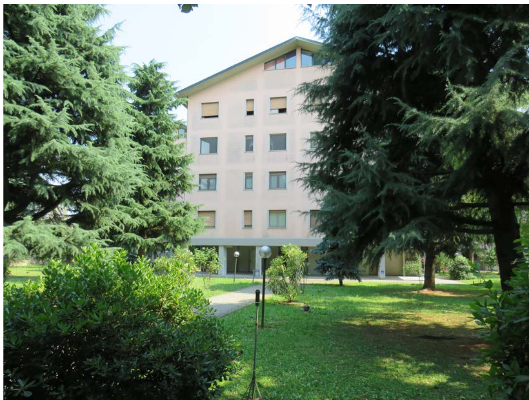
FACCIATA EDIFICIO B SU GIARDINO CONDOMINIALE
