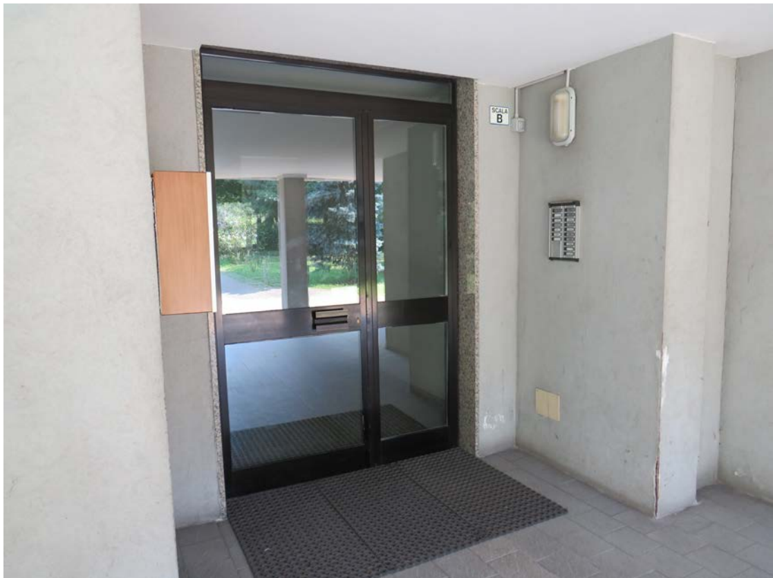
PORTONCINO DI INGRESSO ALL'EDIFICIO B
