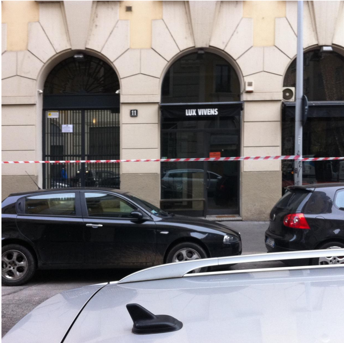
Facciata negozio via Celestino IV ,11
