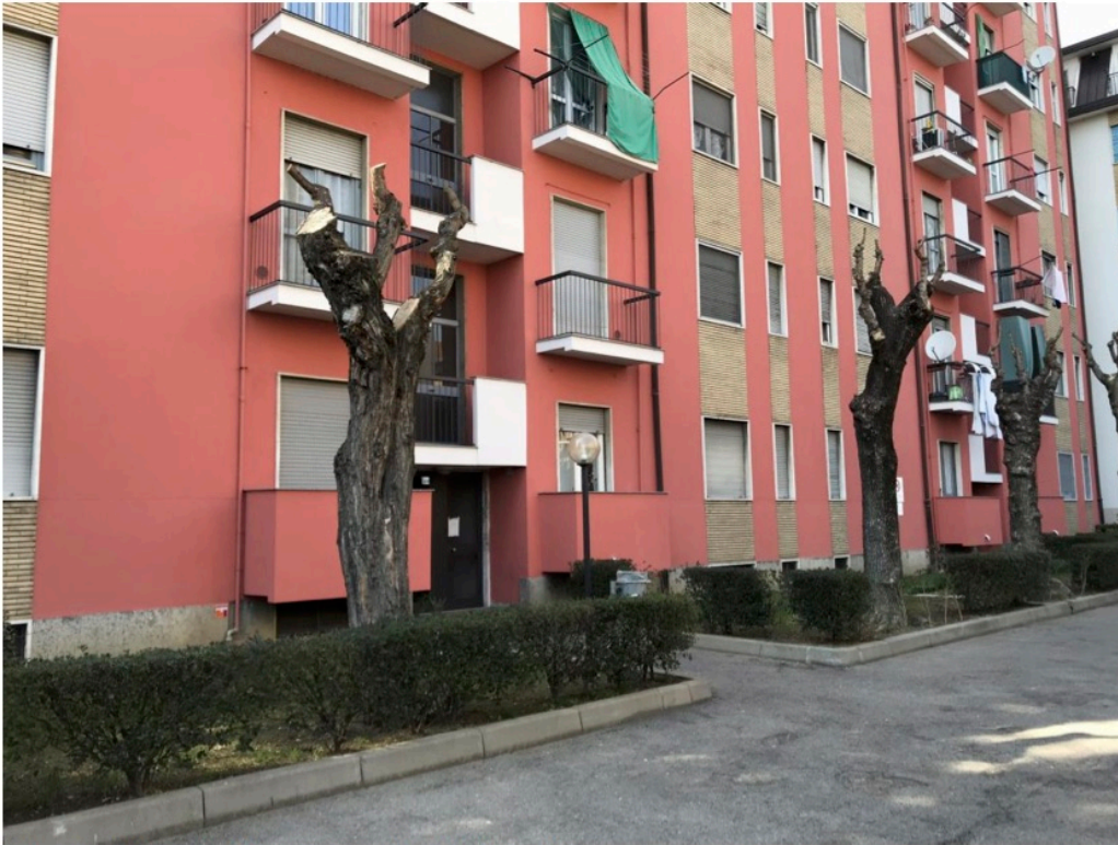
Foto 1: vista dell'ingresso al fabbricato
