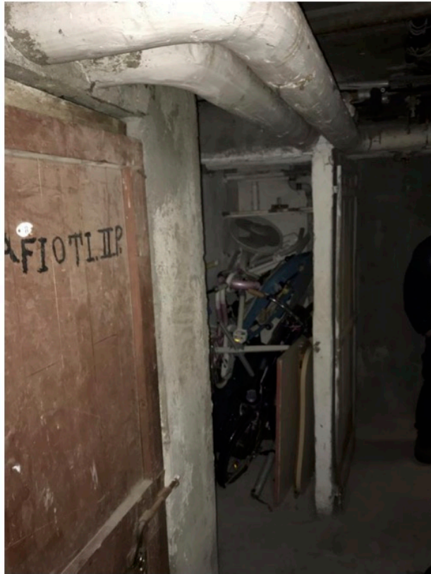
Foto 9: vista della cantina
