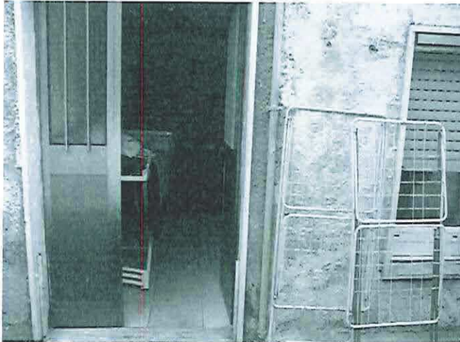
Foto n. 7 : fronte nord – ingresso al piano seminterrato (parte comune pianerottolo)
