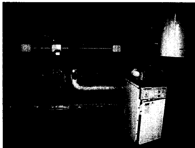
Foto n. 17 : caldaia stato attuale
