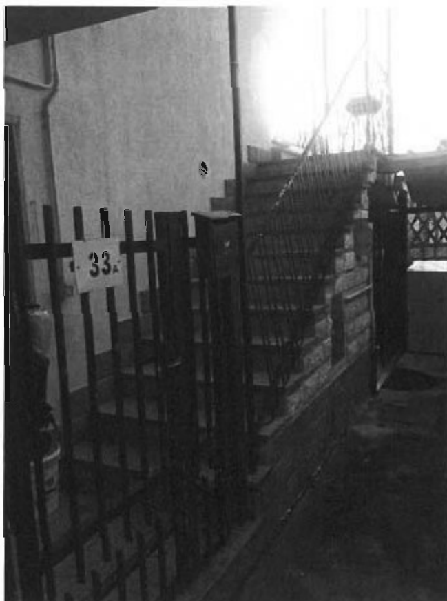
INGRESSO PIANO TERRENO
