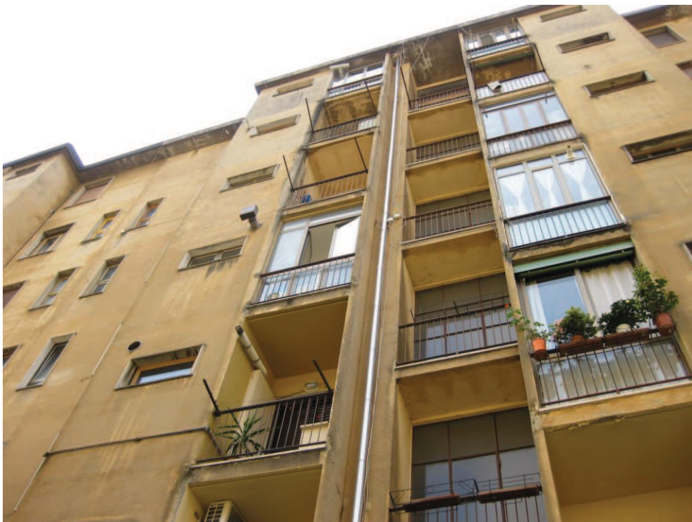
Vista dell'immobile dal cortile interno.
