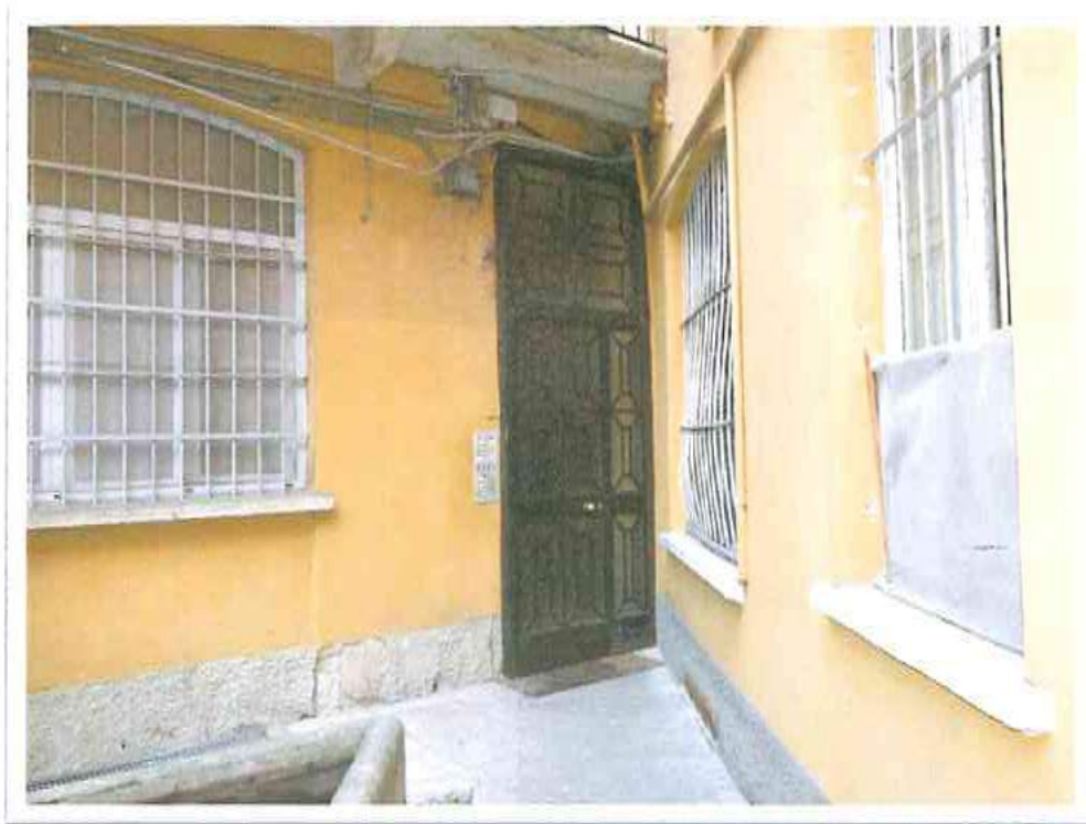
Ingresso al vano scala.
