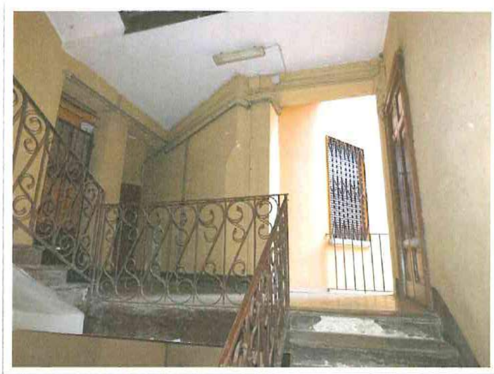
Vano scale e ballatoio del primo piano.
