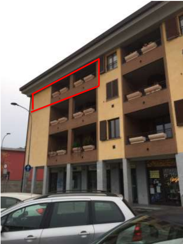
Vista da Via Fiorenza
