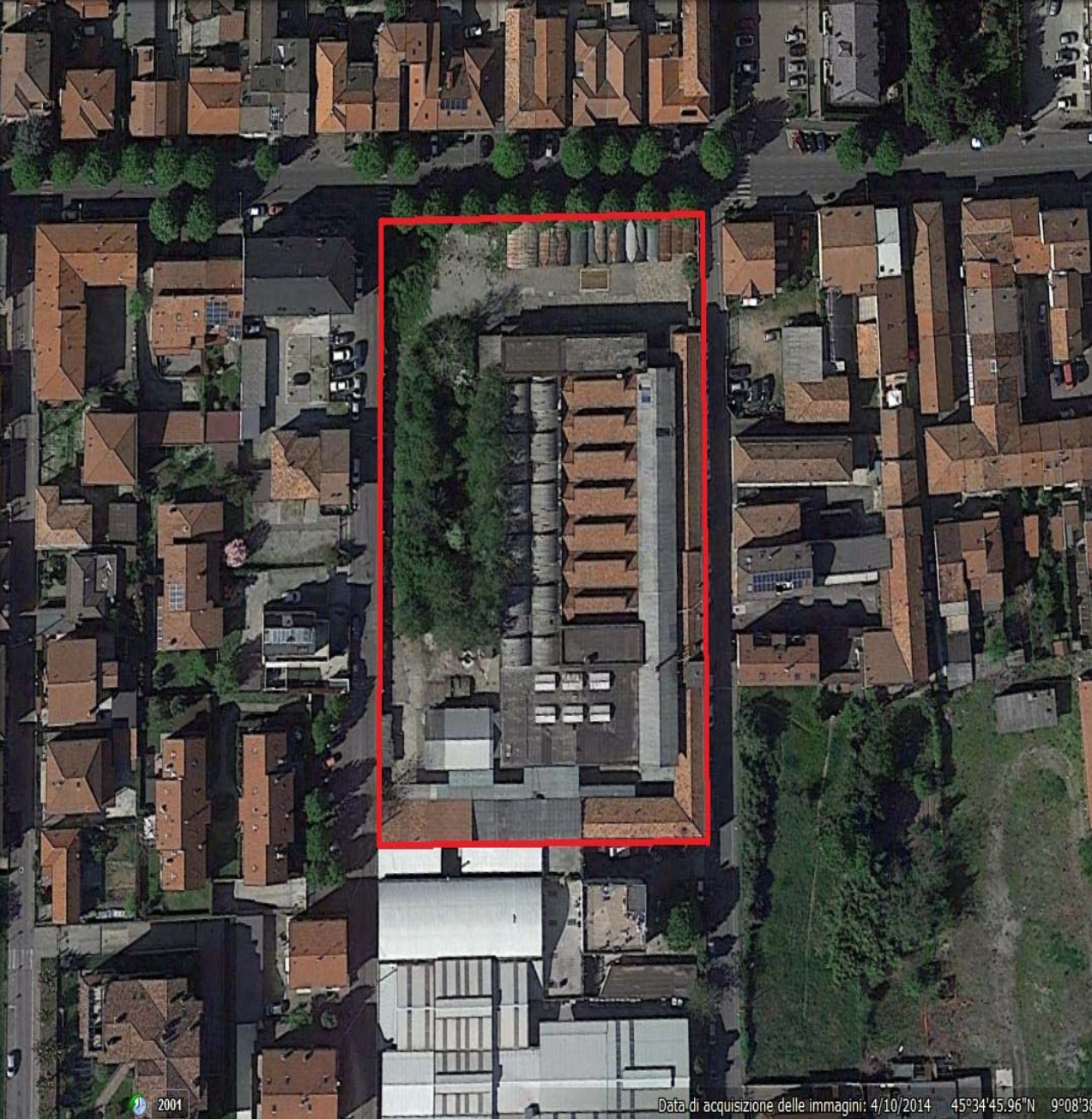
VISTA AEREA STATO ATTUALE
