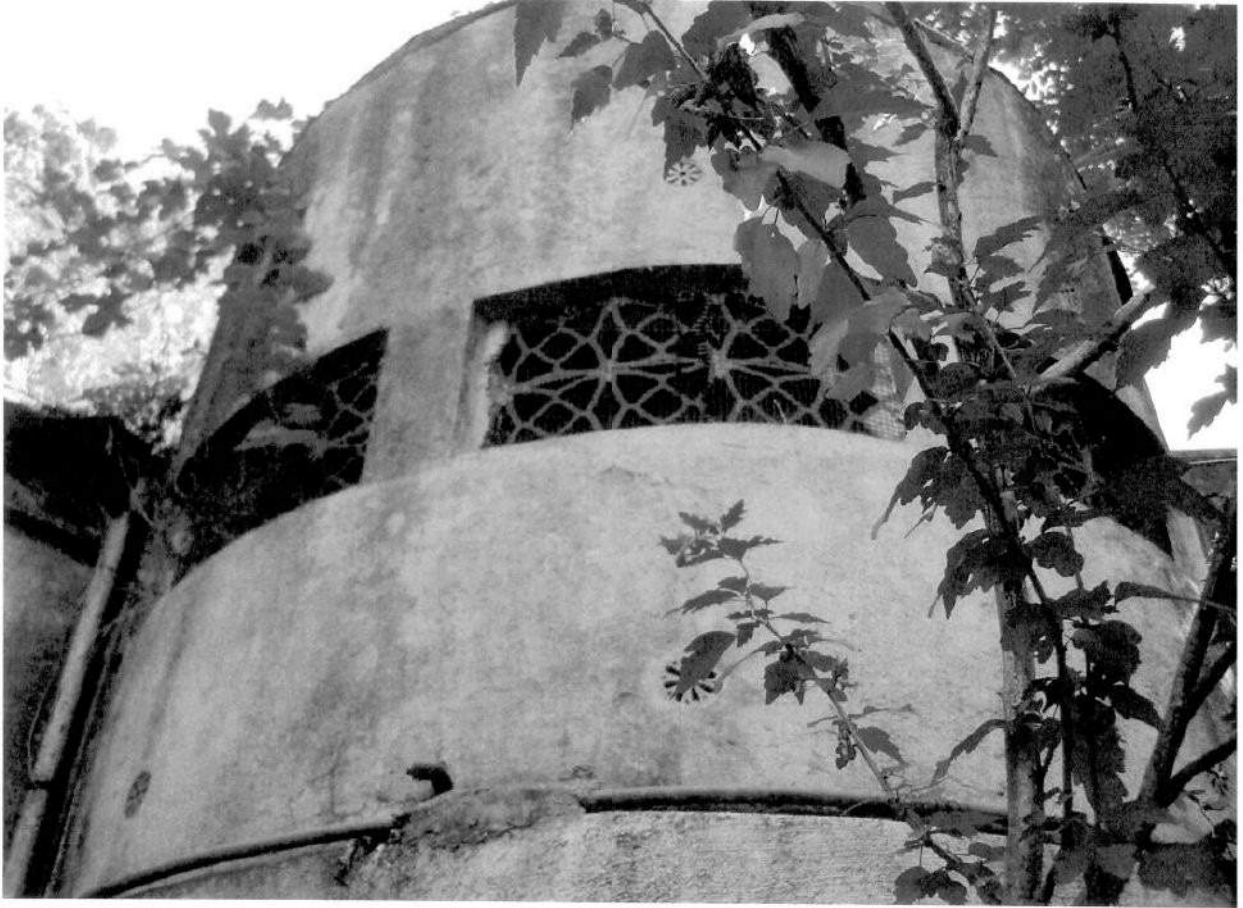
VISTA COCINA DA ESTERNO
