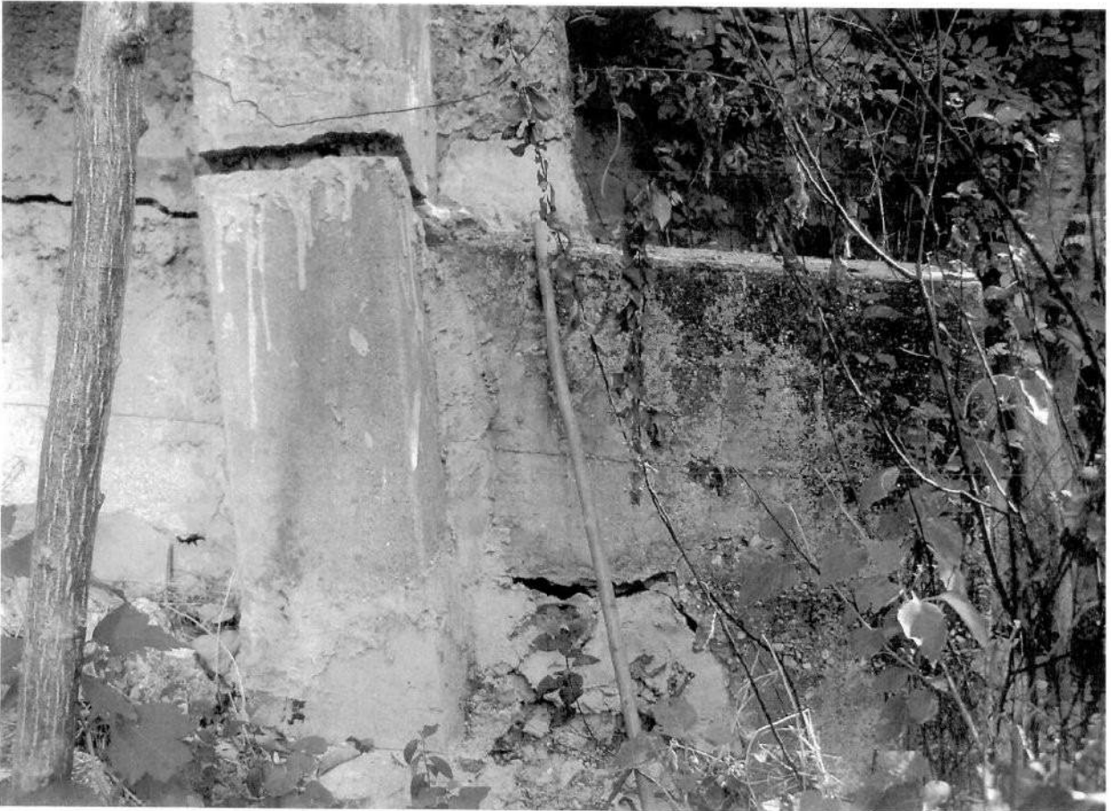
TORVAZ ZONA COCINA
