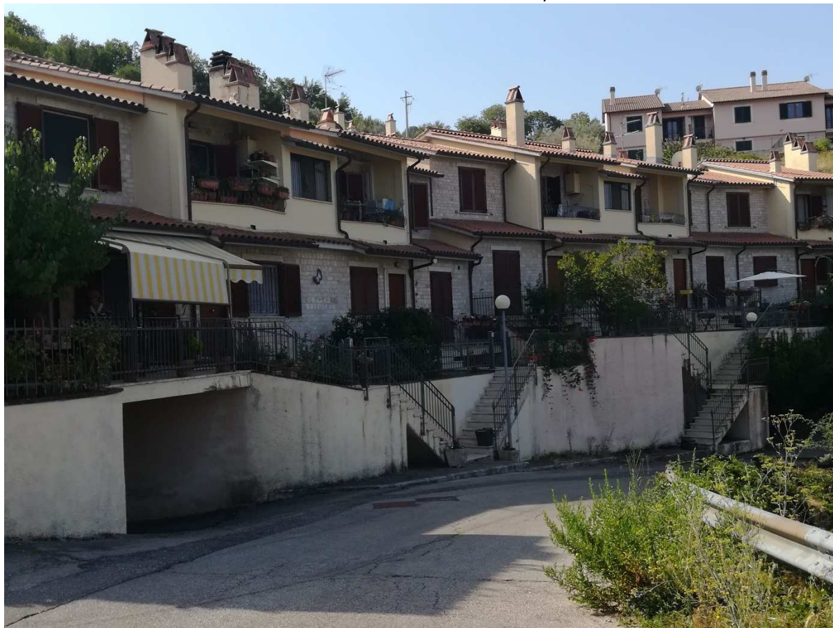
Vista esterna complesso edilizio
