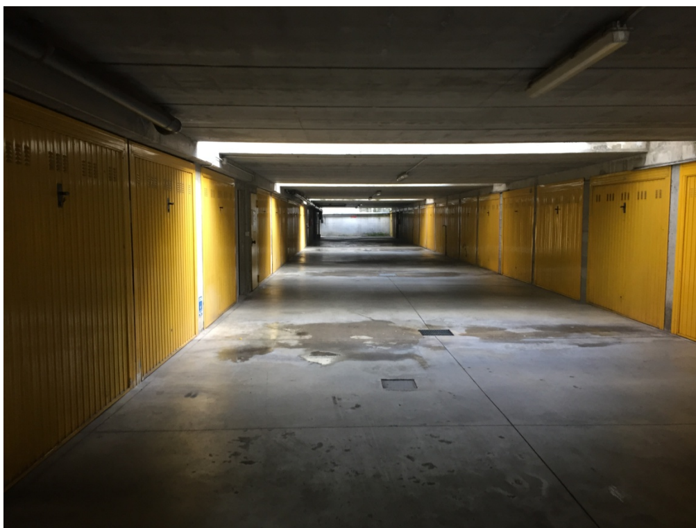
Foto n. 40: Corsello accesso box auto, piano interrato
