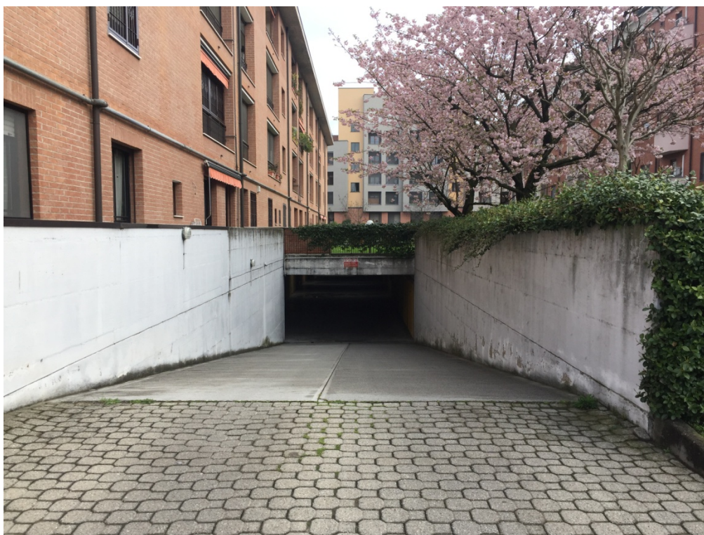
Foto n. 44: Rampa piano interrato dall'esterno
