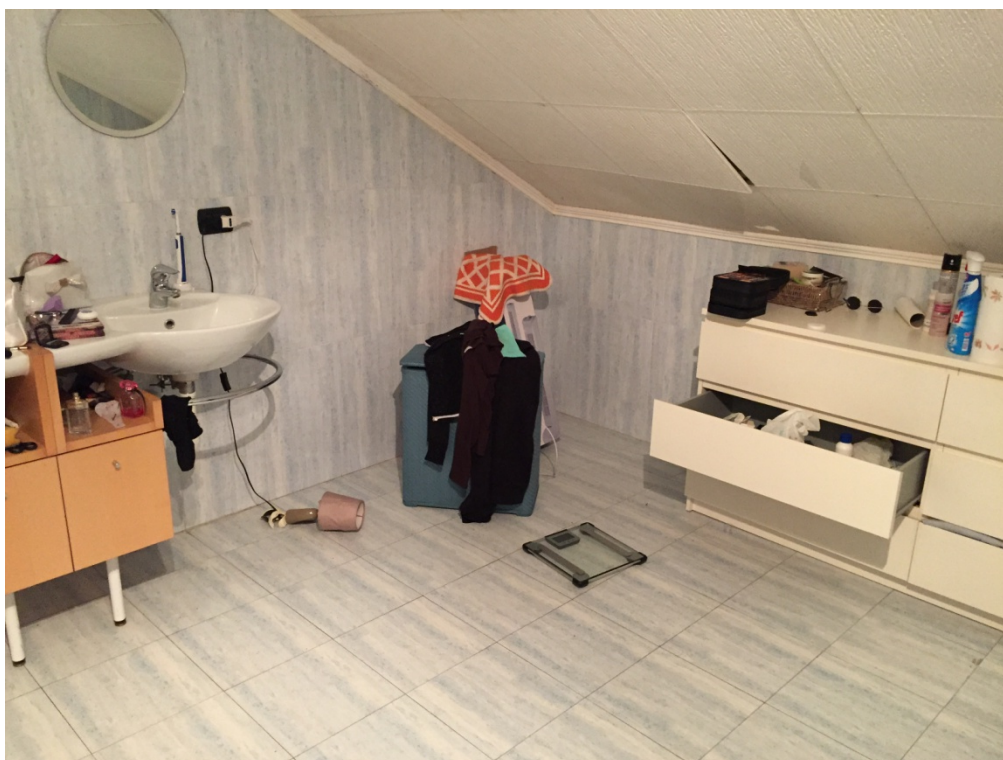
Foto n. 36: Bagno privato (lavello), parte bassa, piano 4°
