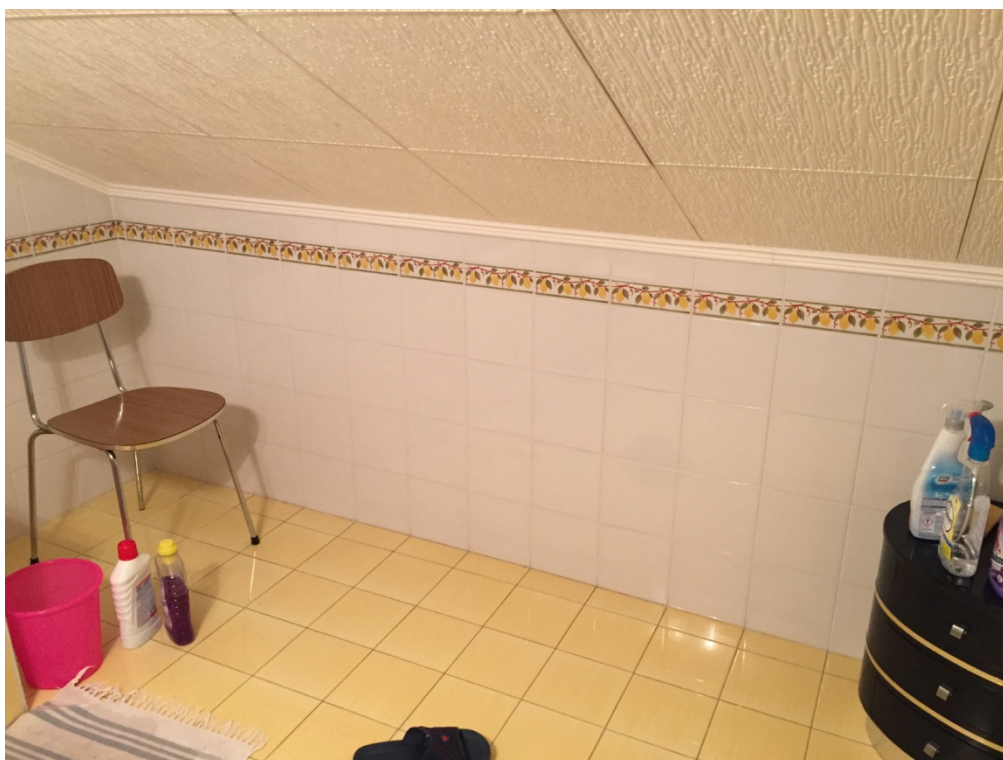
Foto n. 27: Bagno 2 (parte bassa) , piano 4°
