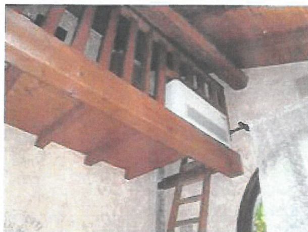
Foto 7: Piano 1° - Accesso al soppalco dalla camera
