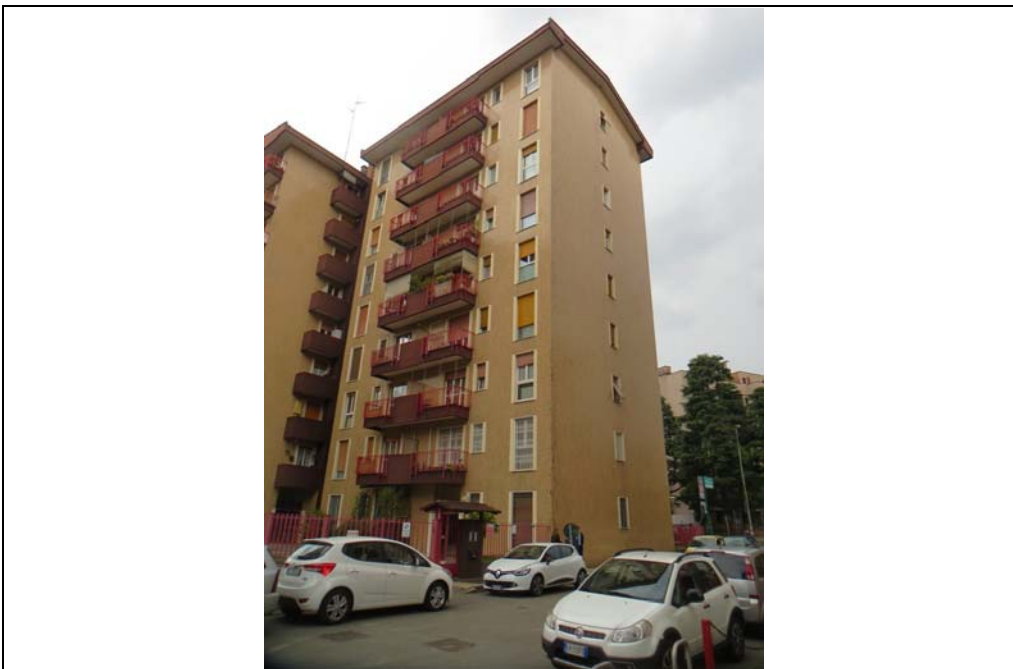
Vista del fabbricato lato interno
