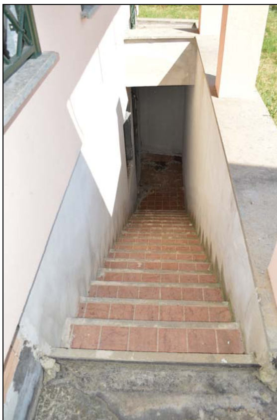
Foto n. 122 - Scala esterna accesso piano interrato
