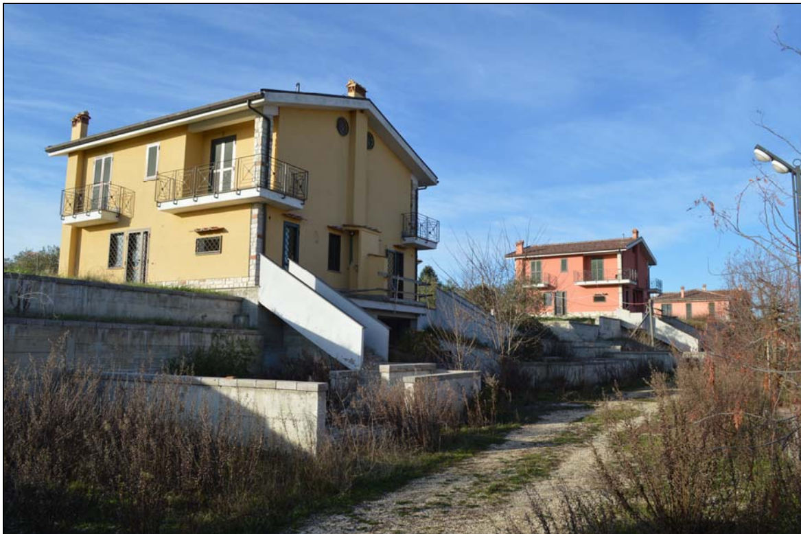
Foto n. 1 - Fronte lato strada di lottizzazione – lato sinistro
