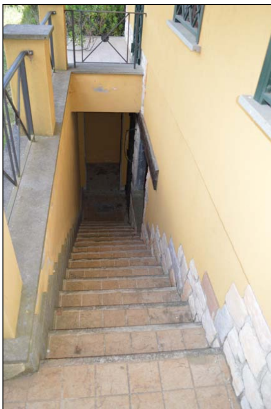
Foto n. 62 - Scala esterna accesso piano interrato
