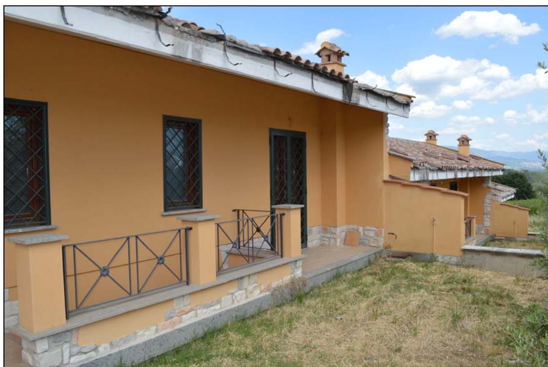
Foto n. 75 - 76 - Prospetto ingresso (vialetto interno particella 1014)
