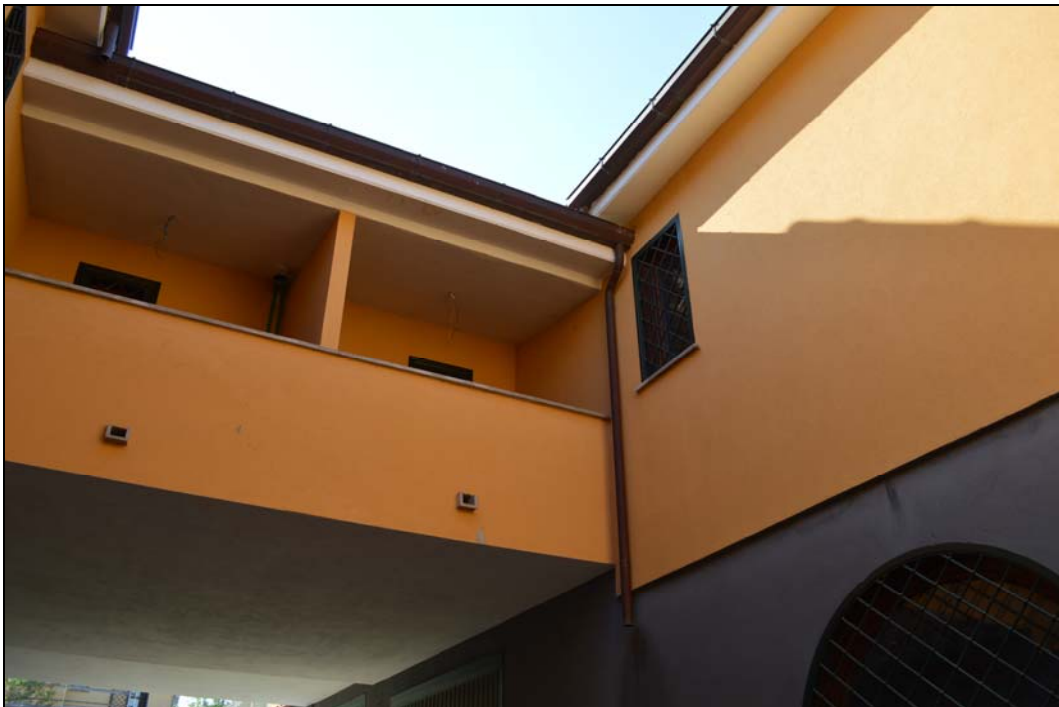
Foto n. 36 – Prospetto interno (strada interna garage)
