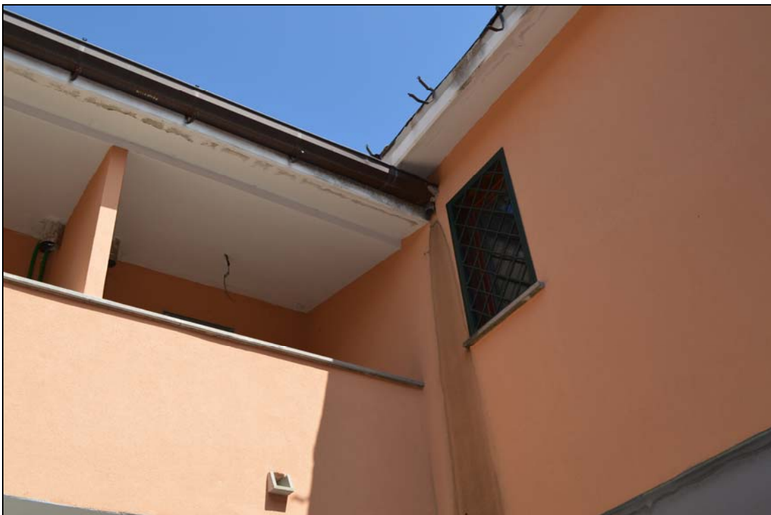
Foto n. 39 – Prospetto interno (strada interna garage)
