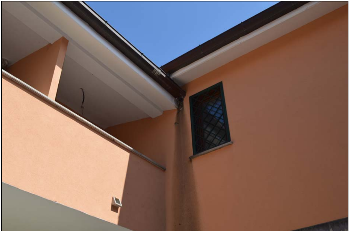
Foto n. 55 – Prospetto interno (strada interna garage)
