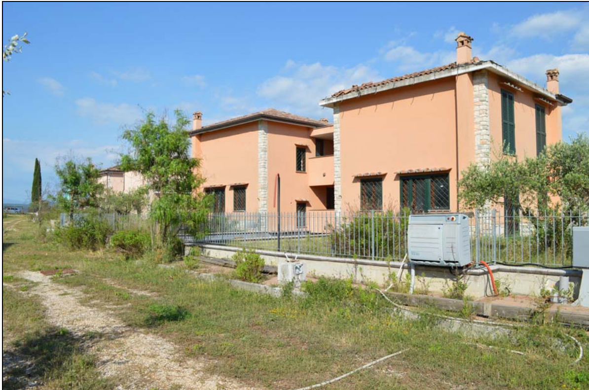
Foto n. 1 - 2 - Fronte di testa lato strada di lottizzazione
