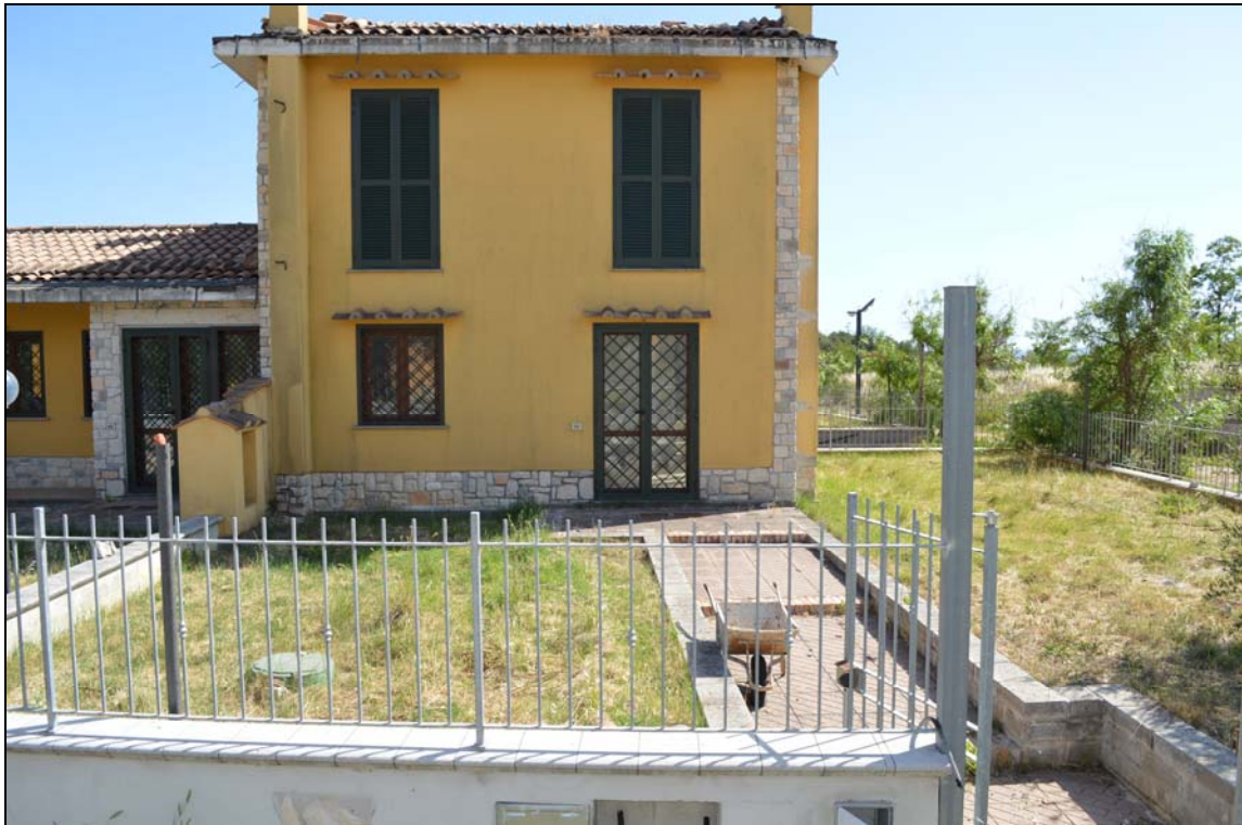
Foto n. 11 - Prospetto lato ingresso (vialetto interno particella 1014)
