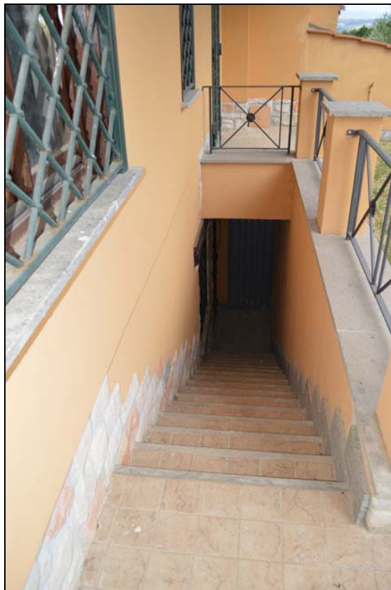
Foto n. 78 - Scala esterna accesso piano interrato
