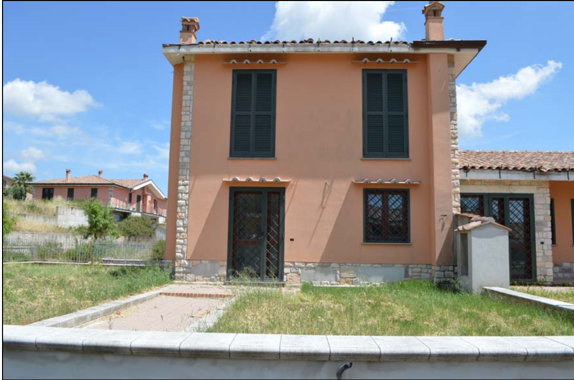
Foto n. 77 - Prospetto lato ingresso (vialetto interno particella 1128)
