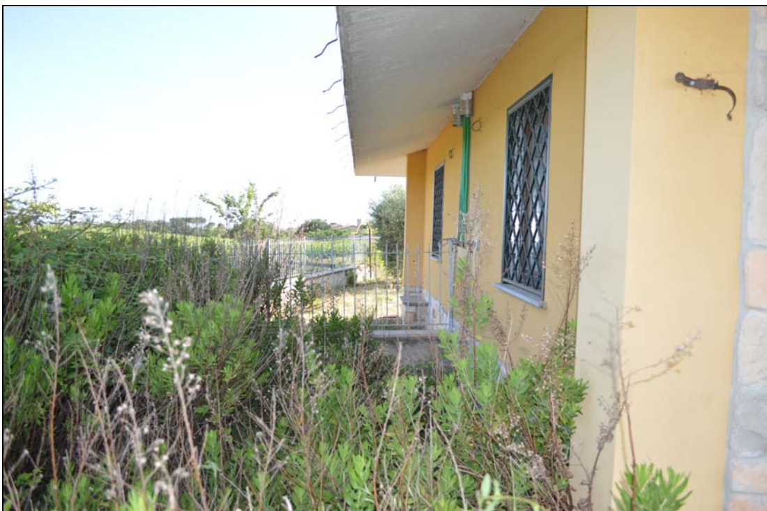
Foto n. 61 - Prospetto laterale (vialetto interno particella 1120)
