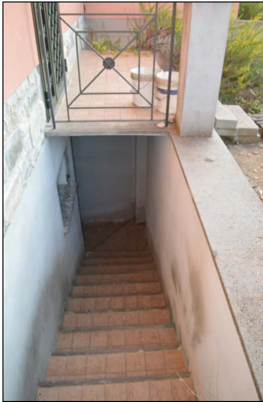
Foto n. 23 - Scala esterna accesso piano interrato
