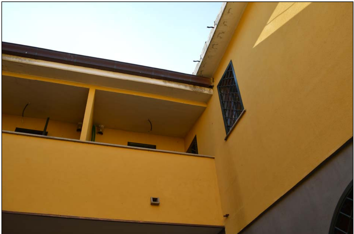
Foto n. 55 – Prospetto interno (strada interna garage)
