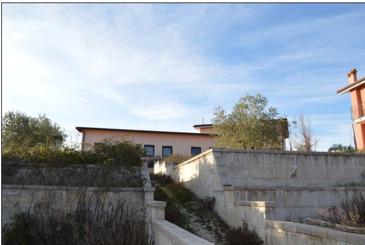
Foto n. 33 - Edificio destinato per attività commerciali (estraneo alla procedura esecutiva)
