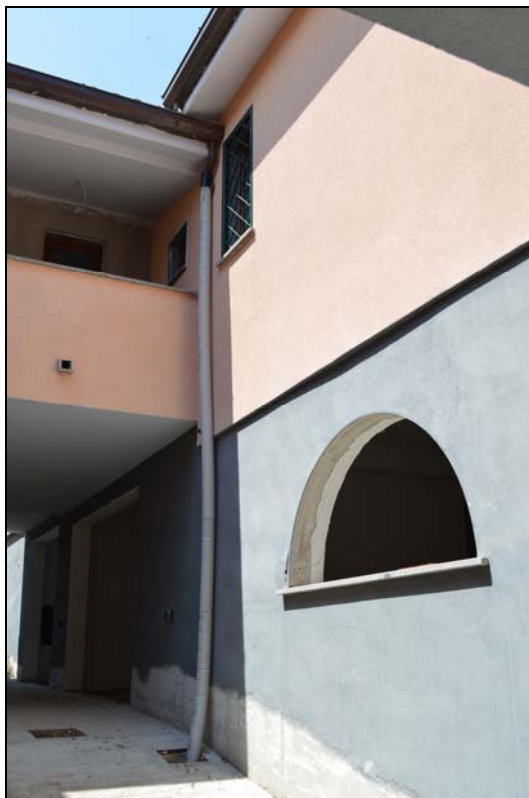
Foto n. 37 – Prospetto interno (strada interna garage)
