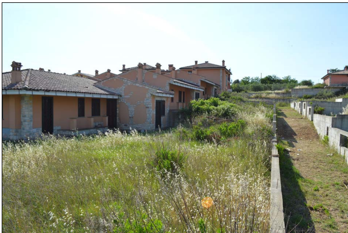
Foto n. 3 - 4 - Fronte lato destro (vialetto interno particella 1131)
