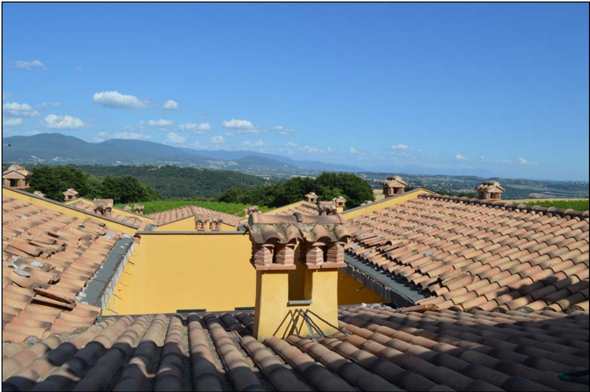
Foto n. 23 – Vista posteriore da loggia 2 (P.1)
