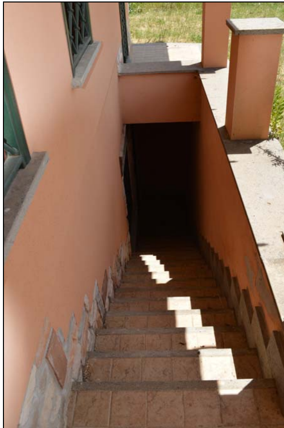
Foto n. 125 - Scala esterna accesso piano interrato
