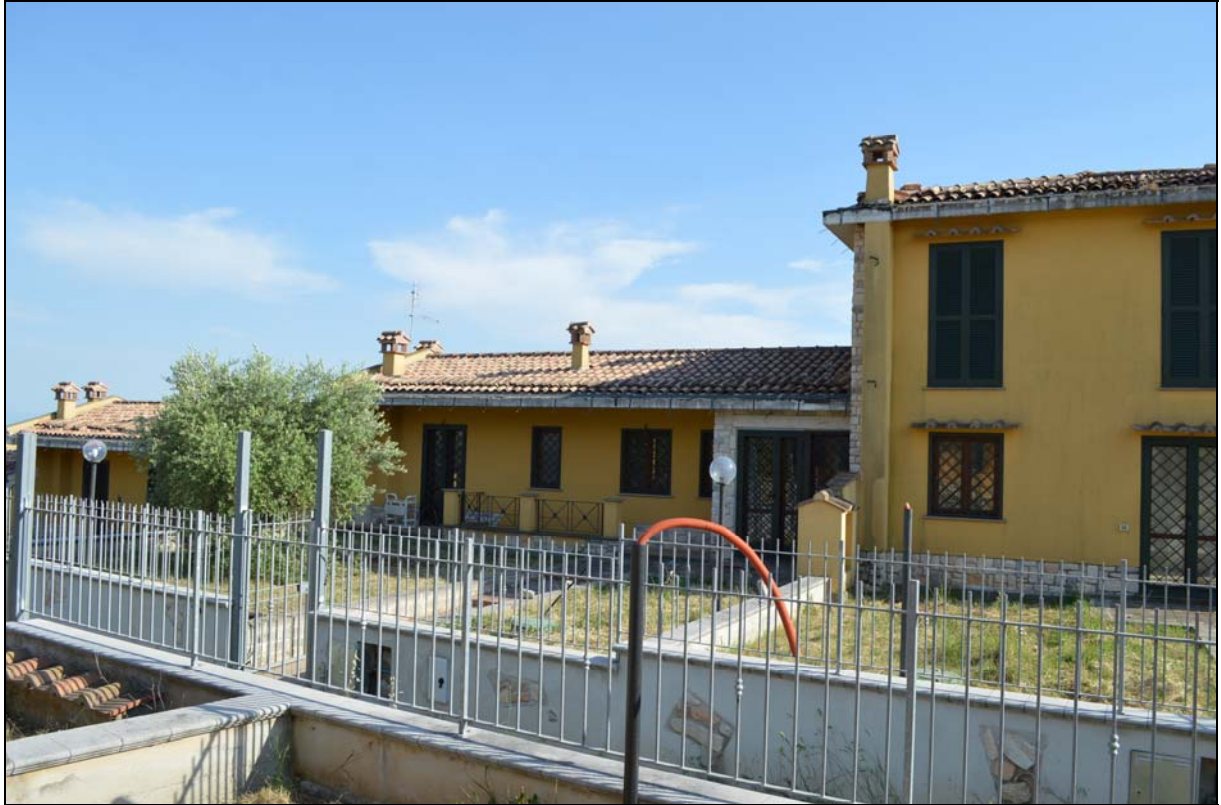
Foto n. 28 - Prospetto ingresso (vialetto interno particella 1014)
