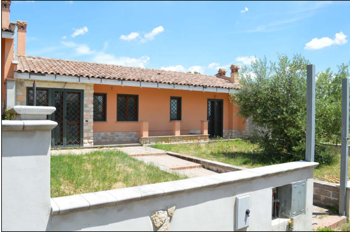
Foto n. 109 - Prospetto ingresso (vialetto interno particella 1128)
