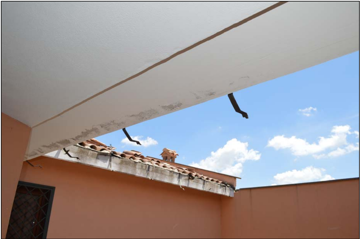
Foto n. 104 – Prospetto interno (strada interna garage)
