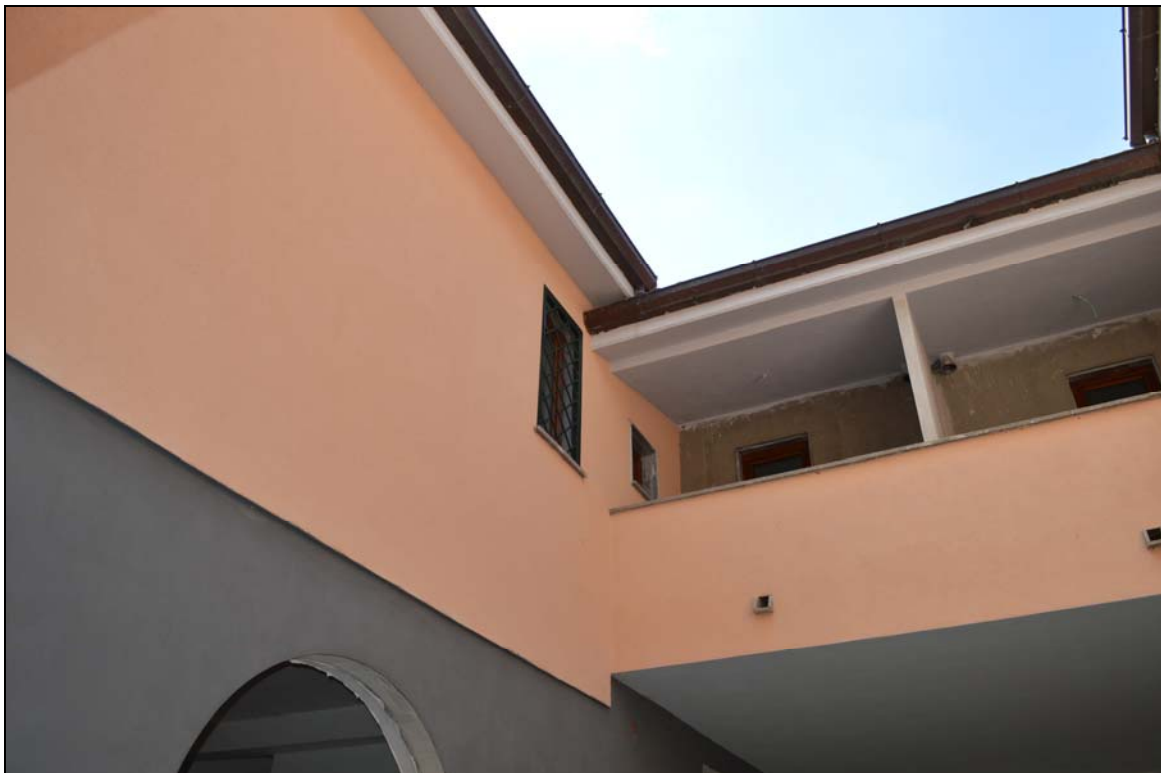
Foto n. 98 – Prospetto interno (strada interna garage)
