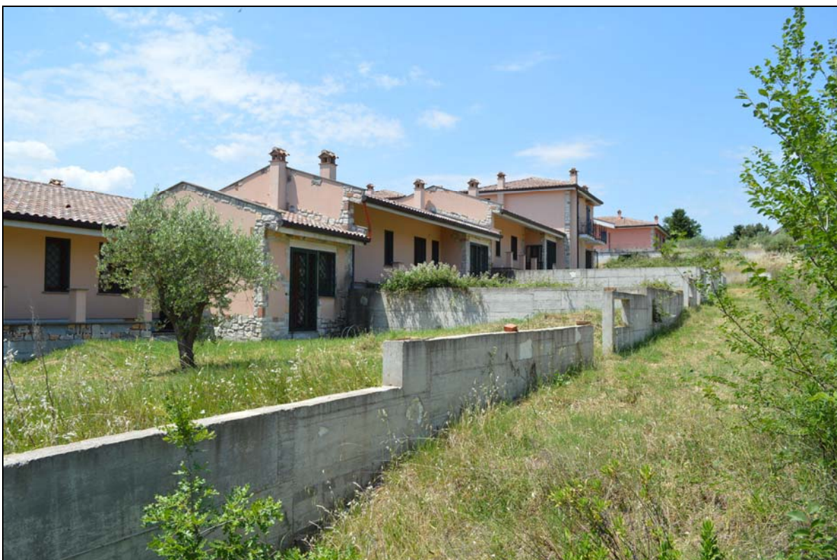
Foto n. 3 - 4 - Fronte lato destro (vialetto interno particella 1137)
