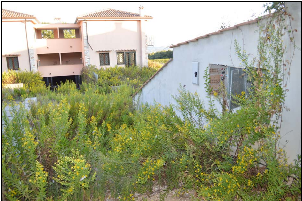
Foto n. 17 - 18 – Rampa garage (Sub. 2)
