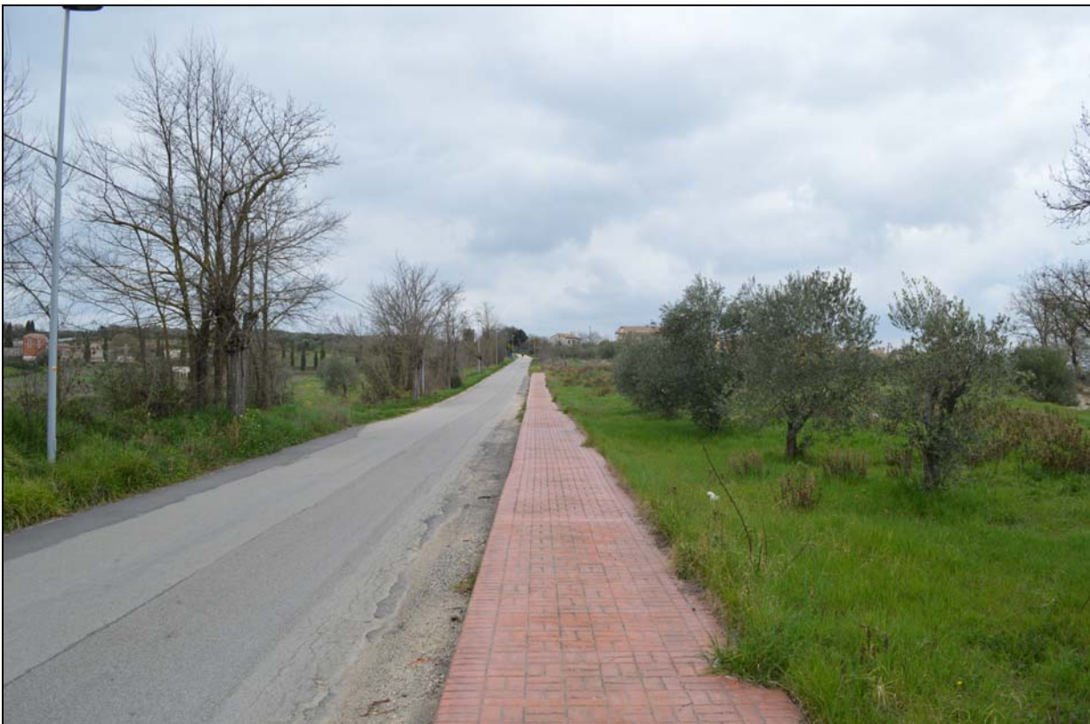
Foto n. 25 - 26 - Confine Ovest della lottizzazione (Strada comunale di Guadamello San Vito)
