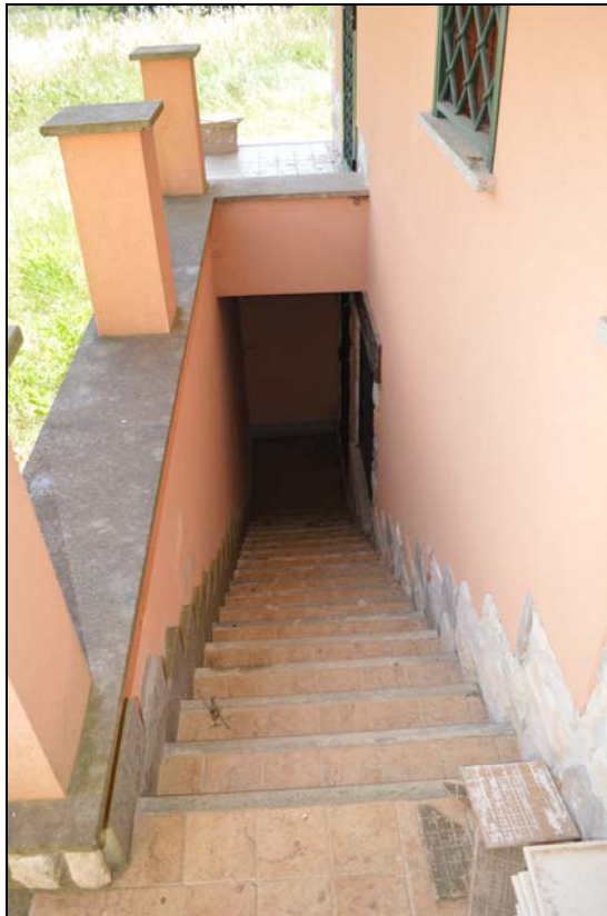
Foto n. 63 - Scala esterna accesso piano interrato
