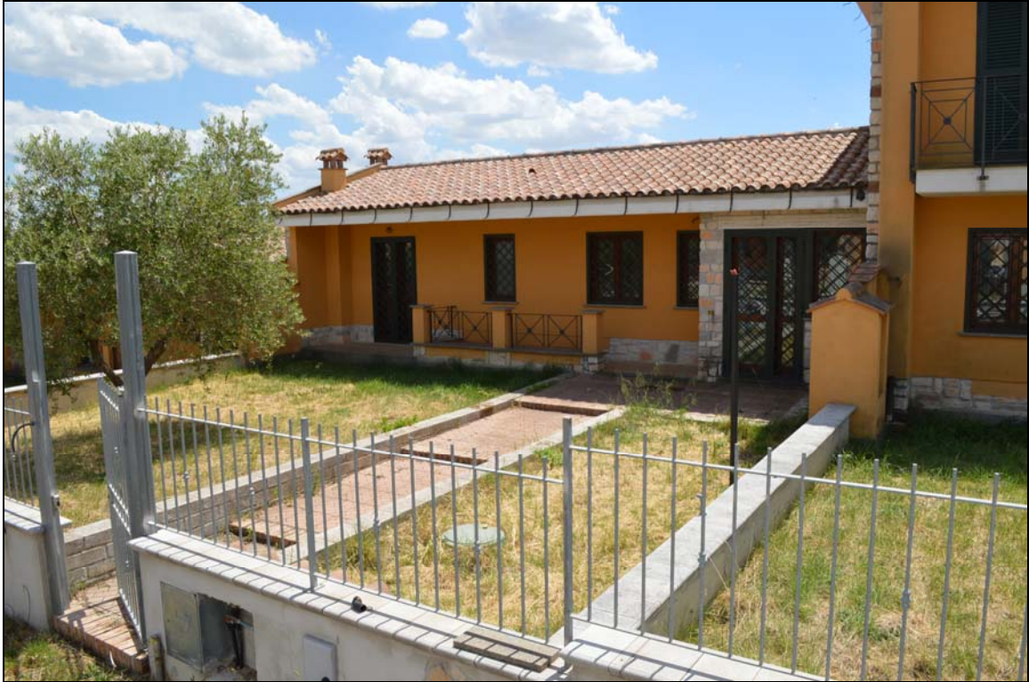
Foto n. 25 - Prospetto ingresso (vialetto interno particella 1128)
