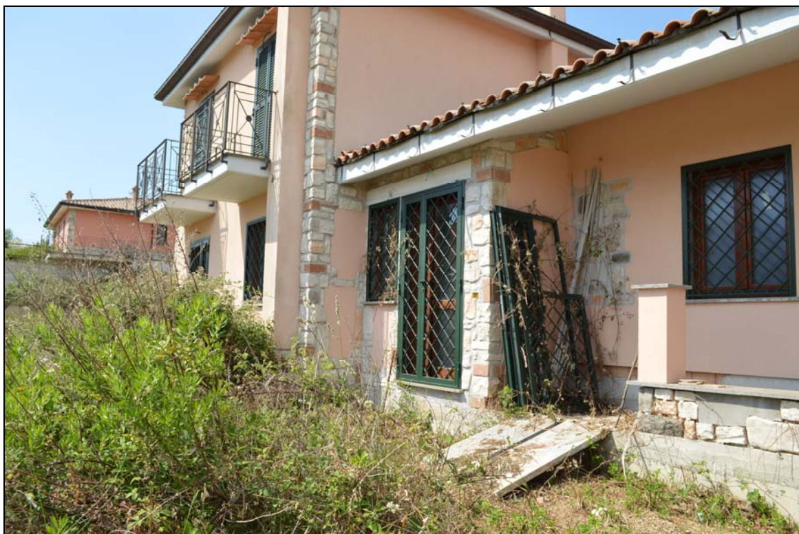
Foto n. 89 - 90 - Prospetto ingresso (vialetto interno particella 1131)
