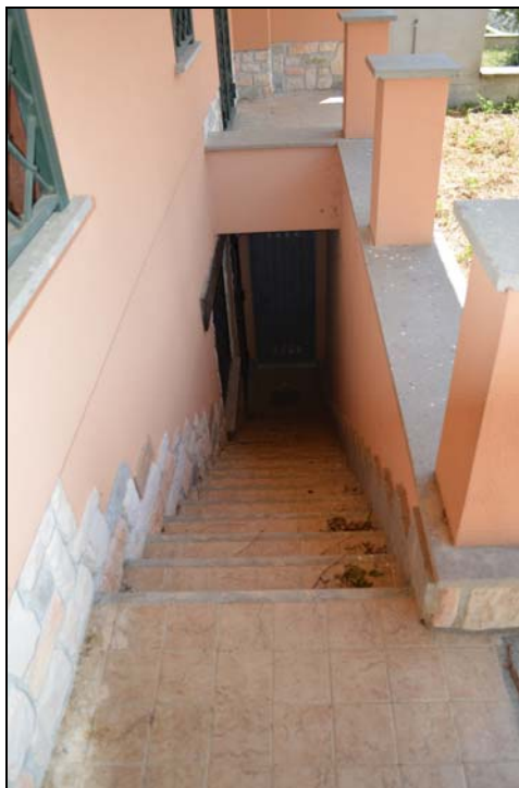
Foto n. 95 - Scala esterna accesso piano interrato
