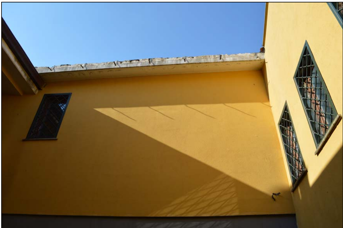
Foto n. 71 – Prospetto interno (strada interna garage)
