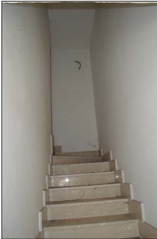
Foto n. 35 – Scala P.T. – P.1
