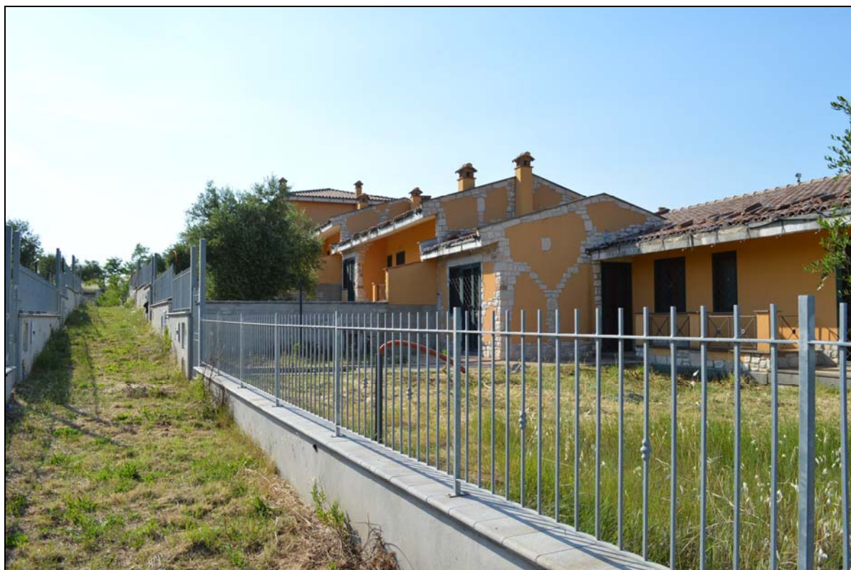
Foto n. 4 - Fronte lato sinistro (vialetto interno particella 1014)
