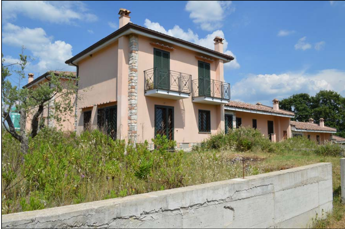
Foto n. 72 - Prospetto lato ingresso (vialetto interno particella 1131)
