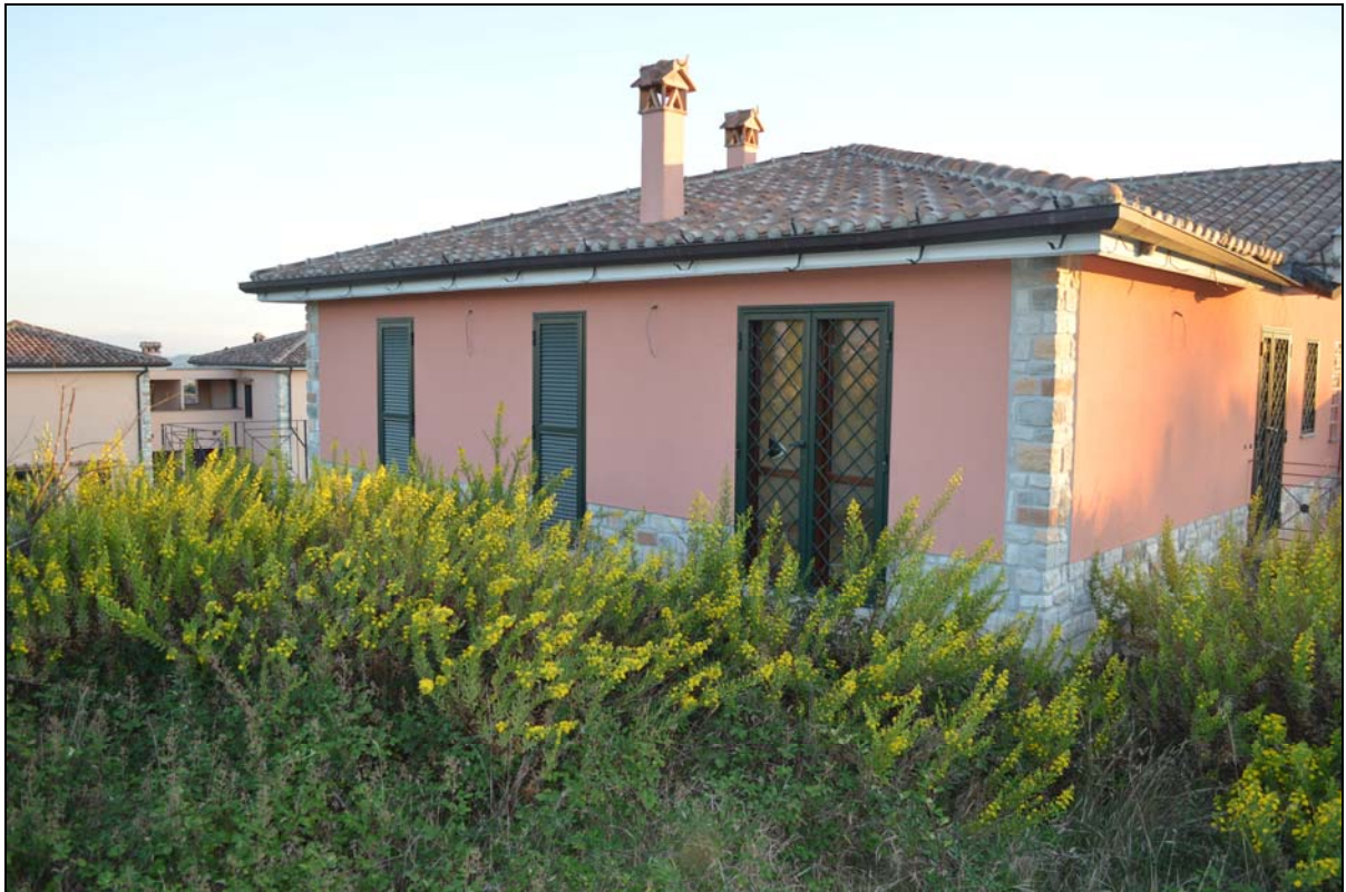
Foto n.3 - Fronte lato destro
