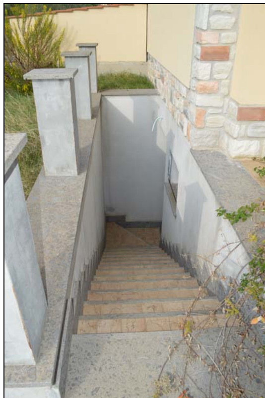
Foto n. 10 - Scala esterna accesso piano interrato
