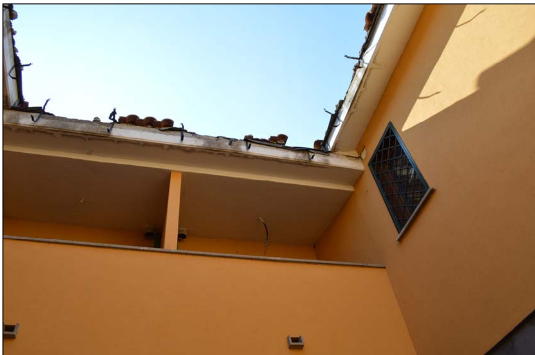
Foto n. 52 – Prospetto interno (strada interna garage)
