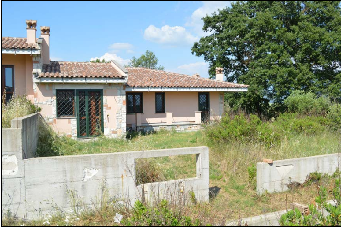
Foto n. 120 - Prospetto ingresso (vialetto interno particella 1131)
