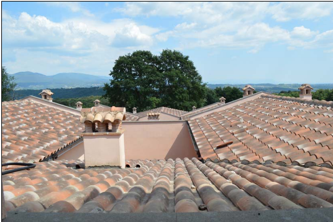
Foto n. 84 – Vista posteriore da loggia 2 (P.1)
