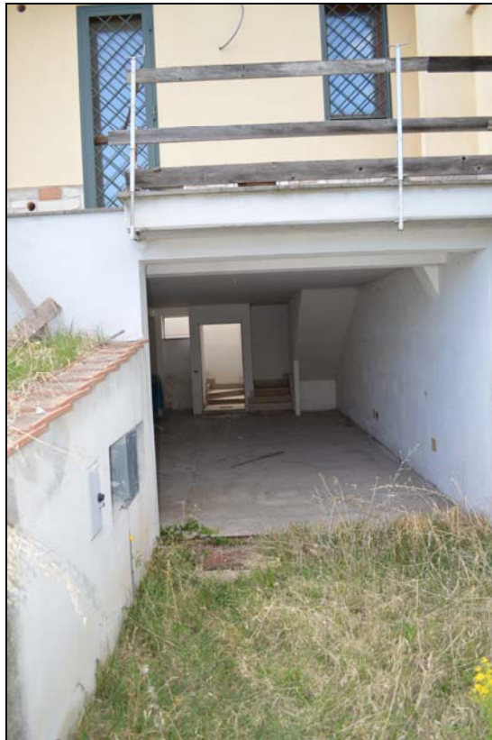
Foto n. 23 – Ingresso Garage (Sub. 2)
