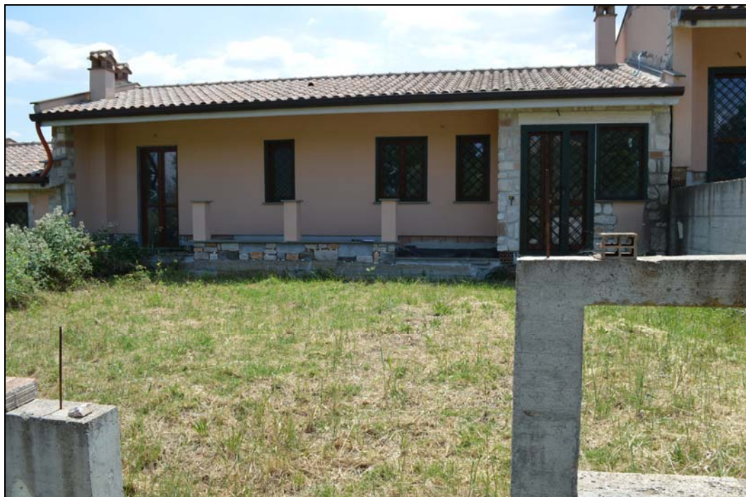
Foto n. 45 - Prospetto ingresso (vialetto interno particella 1137)
