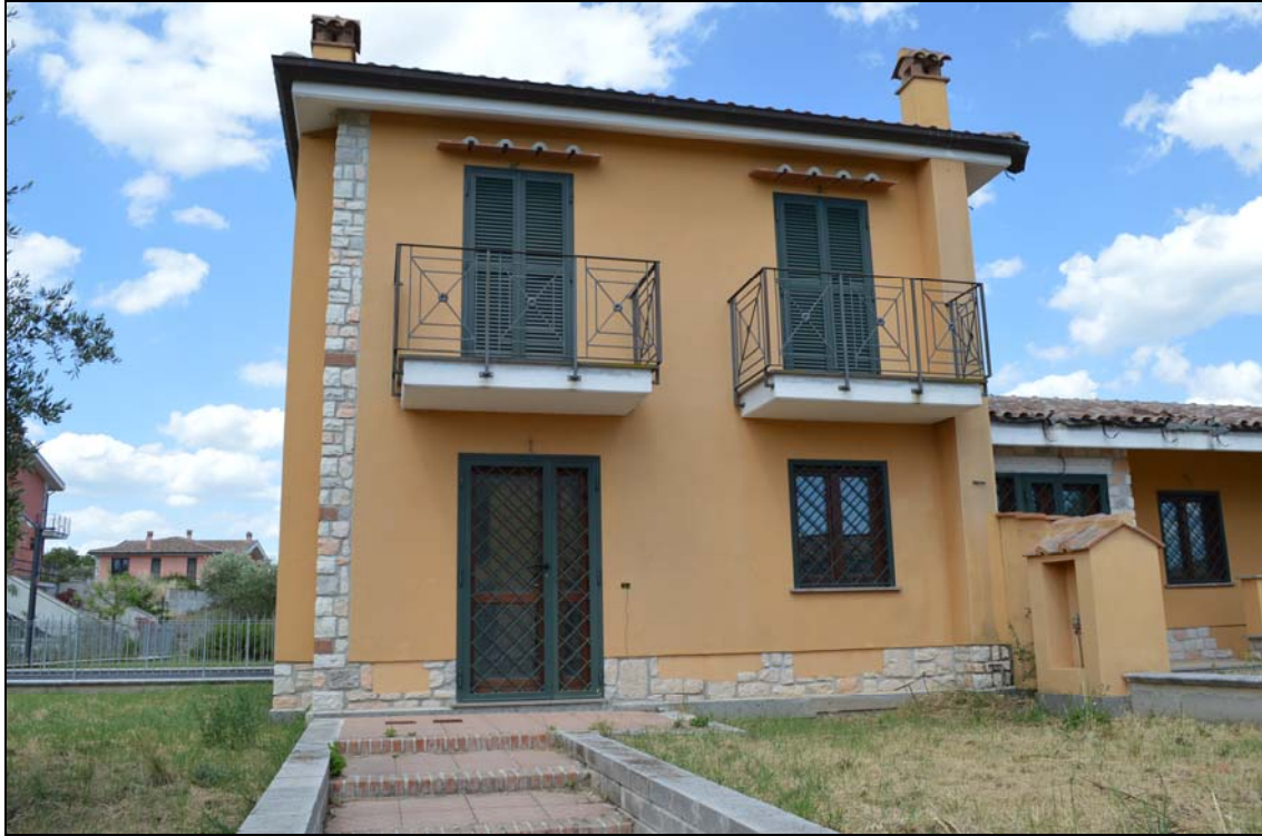
Foto n. 57 - Prospetto lato ingresso (vialetto interno particella 1014)
