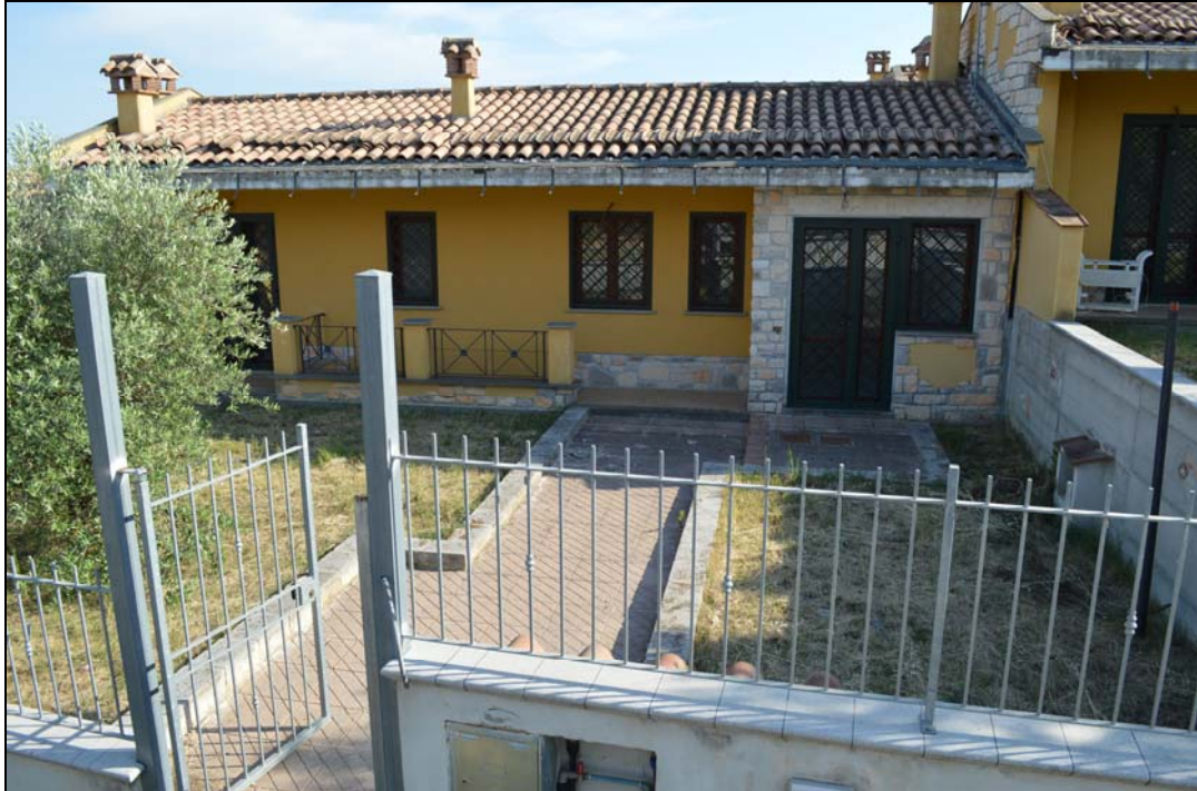
Foto n. 44 - Prospetto ingresso (vialetto interno particella 1014)
