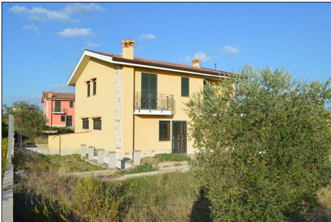
Foto n. 7 – Fronte lato sinistro – lato posteriore
