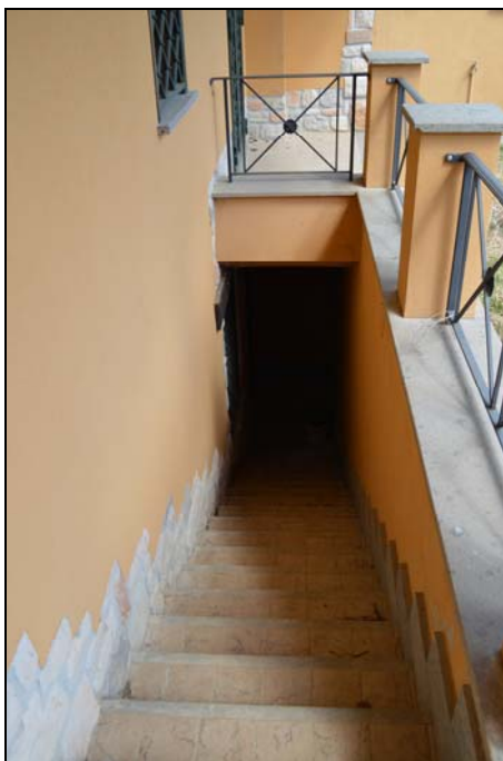
Foto n. 94 - Scala esterna accesso piano interrato
