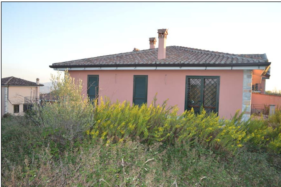
Foto n. 20 - Fronte lato destro
