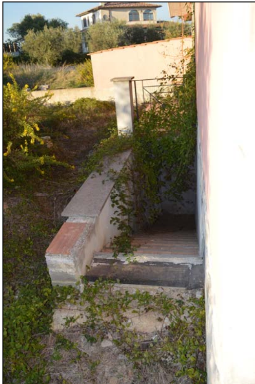
Foto n. 8 - Scala esterna accesso piano interrato
