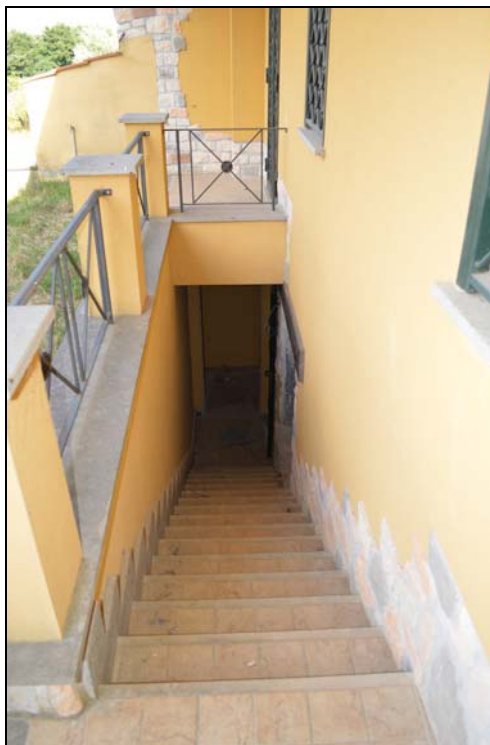
Foto n. 45 - Scala esterna accesso piano interrato
