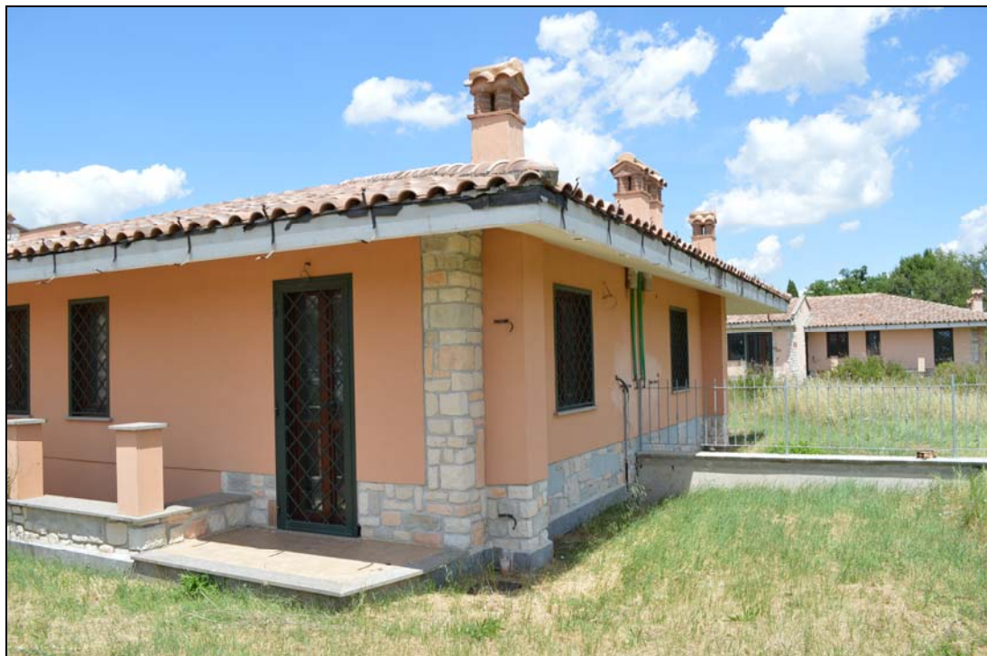
Foto n. 124 - Prospetto laterale (vialetto interno particella 1120)
