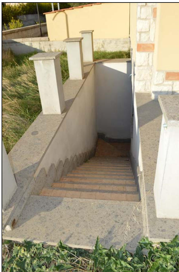
Foto n. 8 - Scala esterna accesso piano interrato
