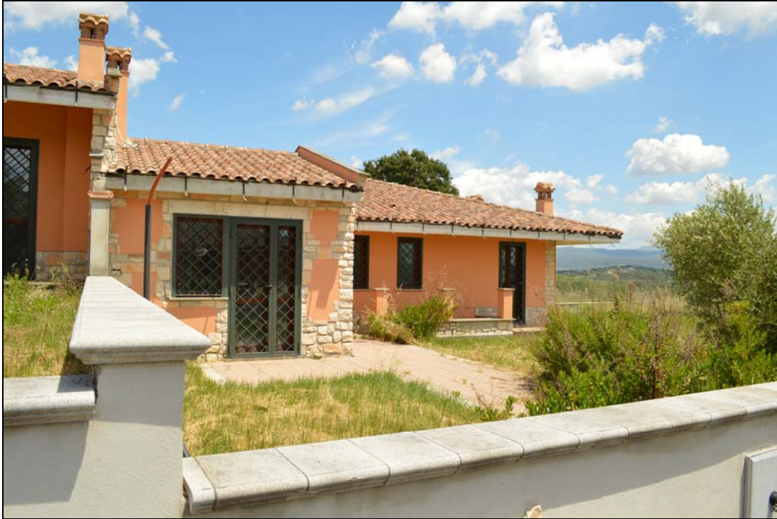
Foto n. 123 - Prospetto ingresso (vialetto interno particella 1128)
