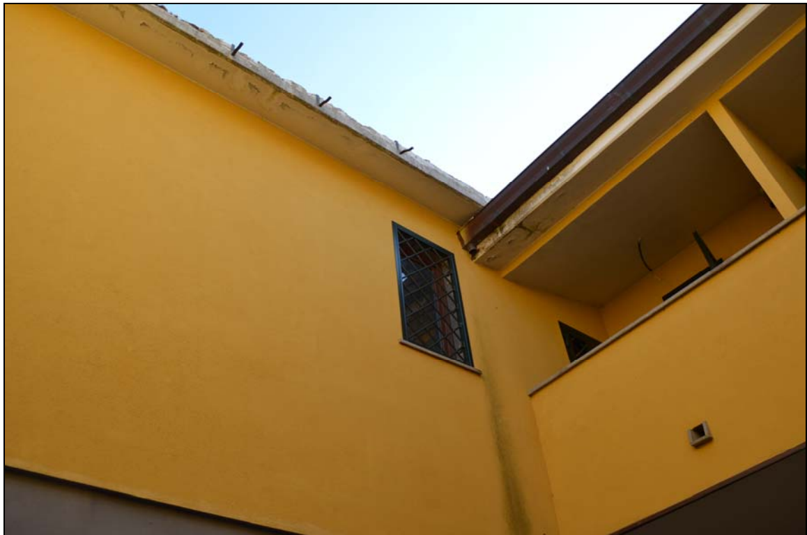
Foto n. 121 – Prospetto interno (strada interna garage)
