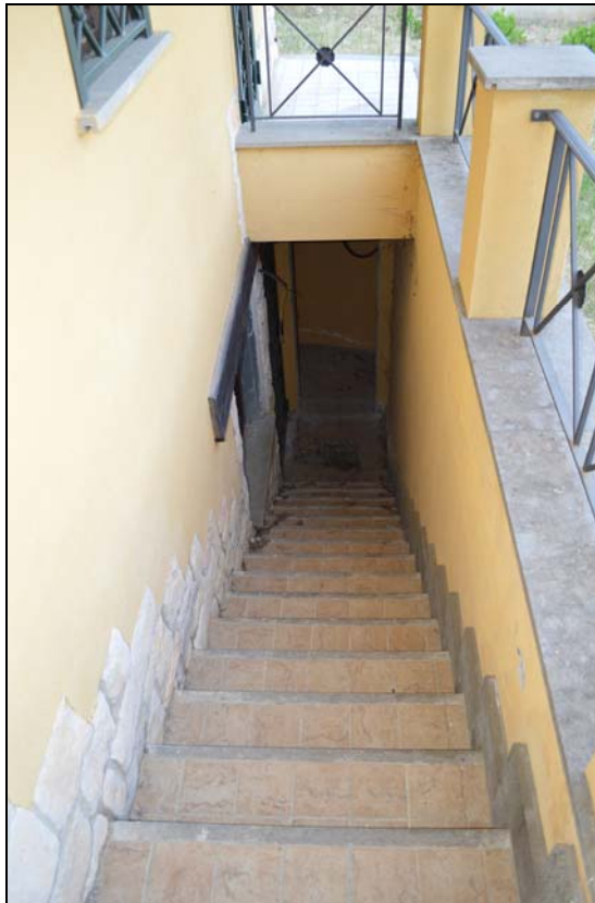
Foto n. 128 - Scala esterna accesso piano interrato
