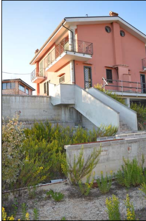
Foto n. 5 - Fronte lato strada di lottizzazione – lato sinistro
