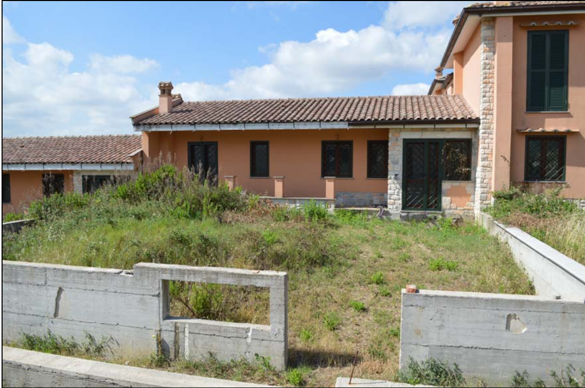
Foto n. 28 - Prospetto ingresso (vialetto interno particella 1131)
