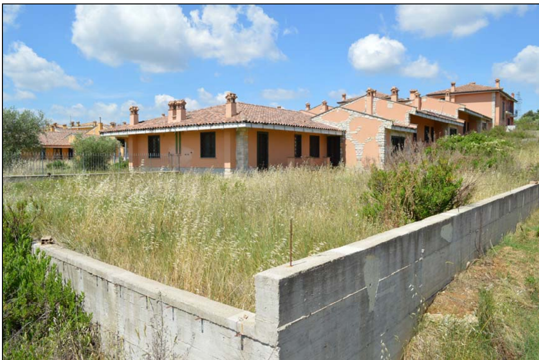
Foto n. 62 - Prospetto laterale (vialetto interno particella 1120)
