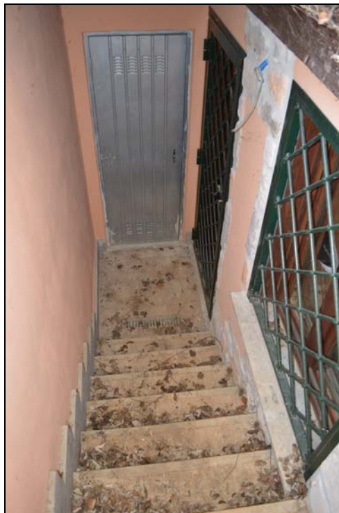
Foto n. 45 - Scala esterna accesso piano interrato
