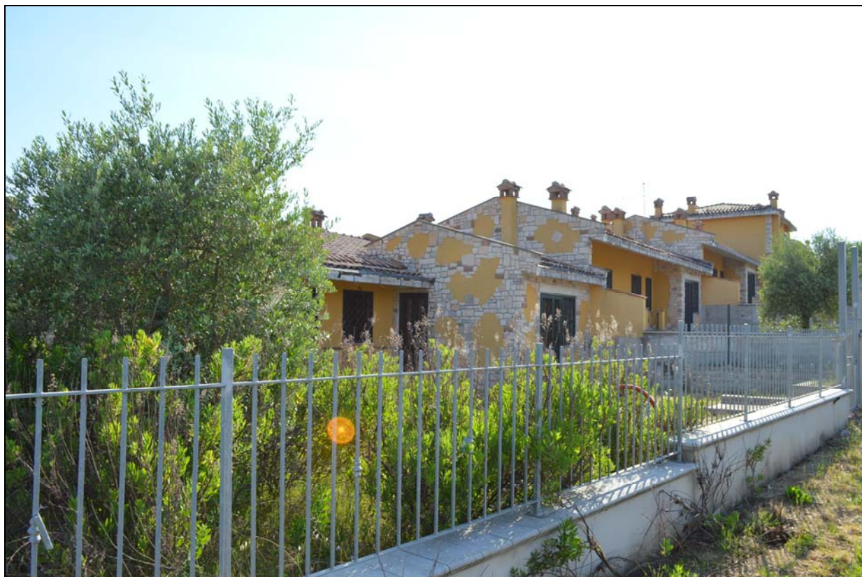
Foto n. 3 - 4 - Fronte lato destro (vialetto interno particella 1014)
