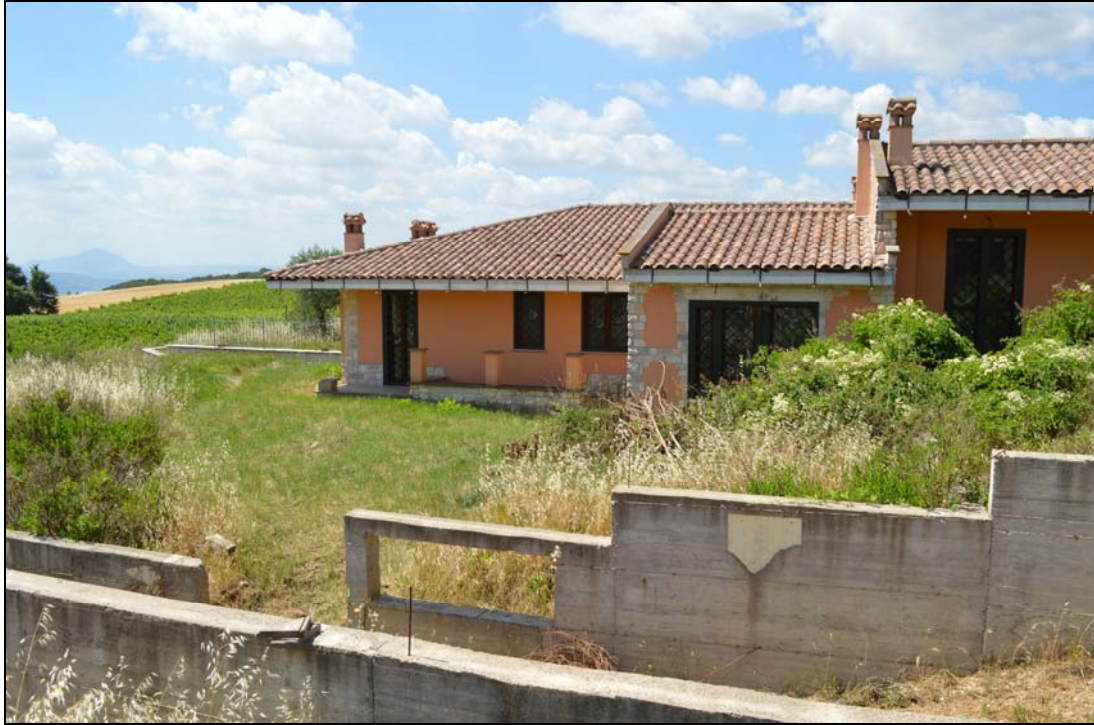
Foto n. 61 - Prospetto ingresso (vialetto interno particella 1131)
