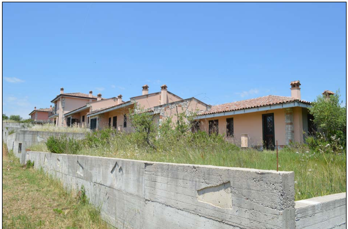
Foto n. 5 - 6 - Fronte lato sinistro (vialetto interno particella 1131)
