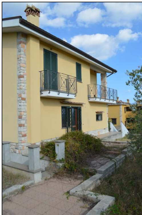
Foto n. 8 - Fronte lato sinistro
