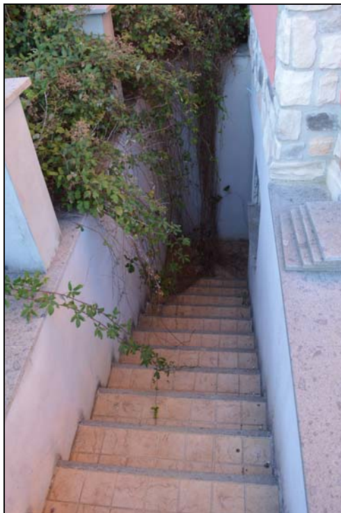
Foto n. 6 - Scala esterna accesso piano interrato
