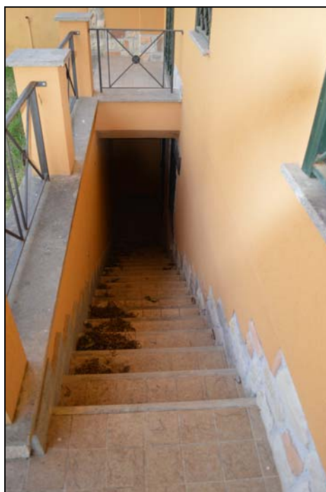
Foto n. 42 - Scala esterna accesso piano interrato
