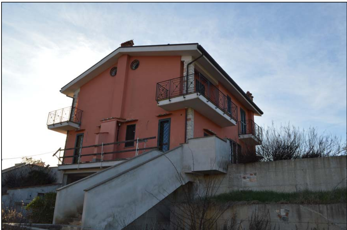
Foto n. 2 - Fronte lato strada di lottizzazione – lato destro
