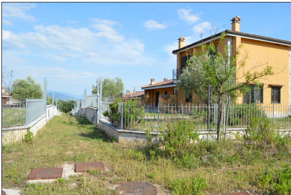
Foto n. 3 - Fronte lato destro (vialetto interno particella 1128)
