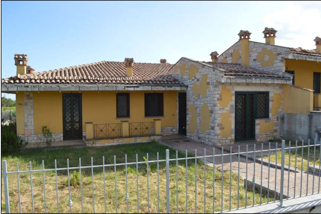
Foto n. 60 - Prospetto ingresso (vialetto interno particella 1014)
