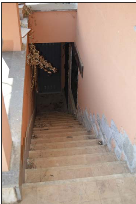
Foto n. 29 - Scala esterna accesso piano interrato
