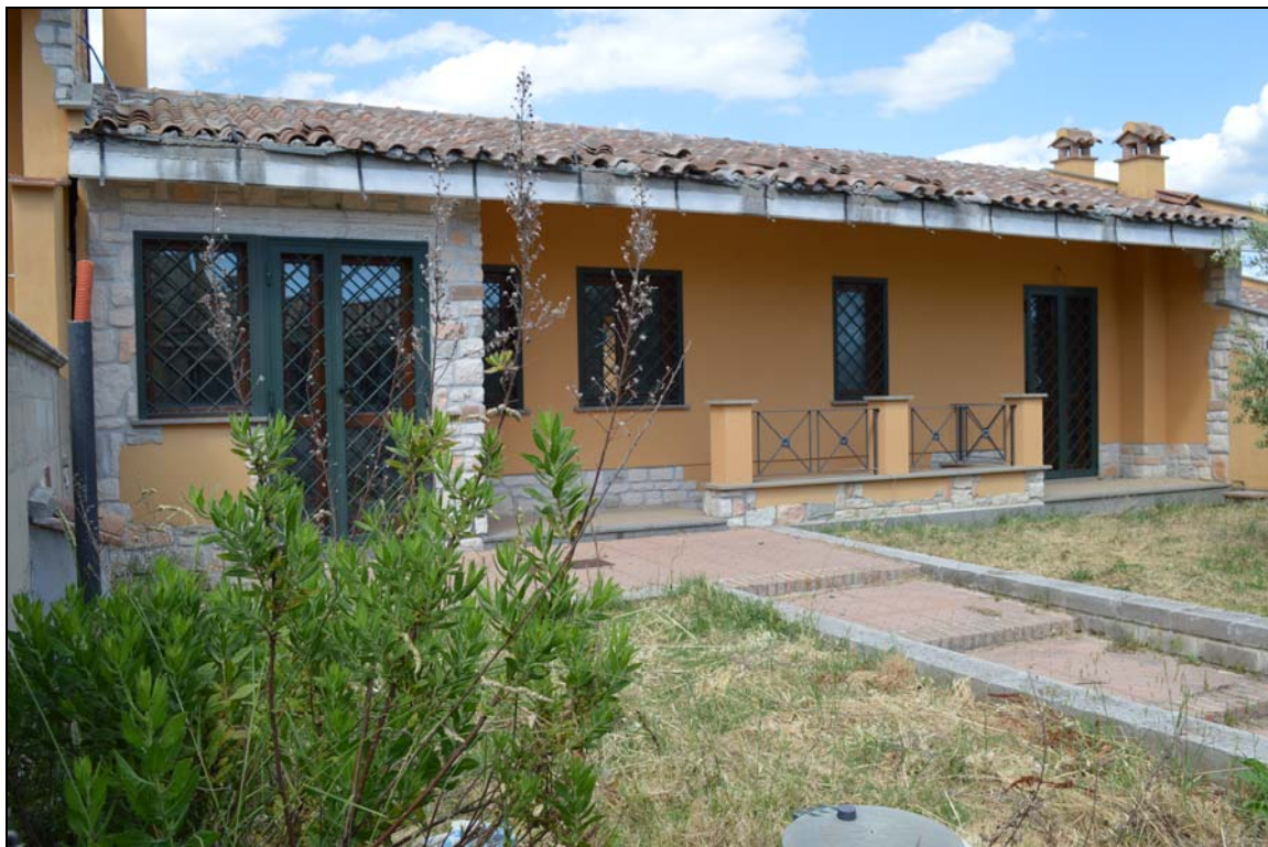
Foto n. 93 - Prospetto ingresso (vialetto interno particella 1014)
