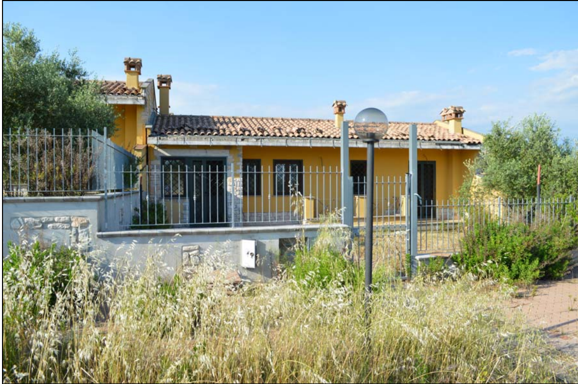
Foto n. 110 - Prospetto ingresso (vialetto interno particella 1117)
