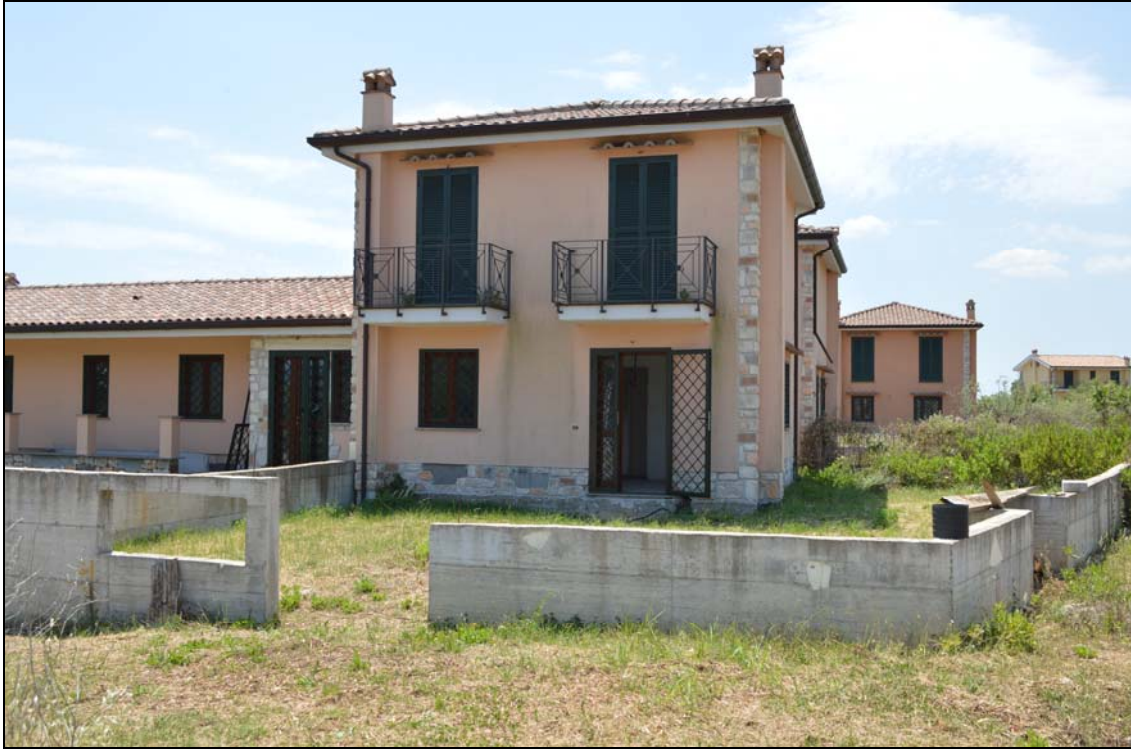
Foto n. 11 - Prospetto lato ingresso (vialetto interno particella 1137)
