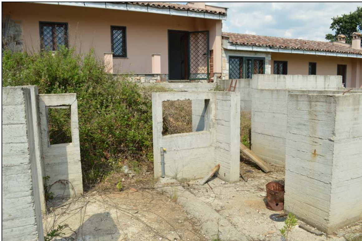
Foto n. 95 - 96 - Prospetto ingresso (vialetto interno particella 1131)
