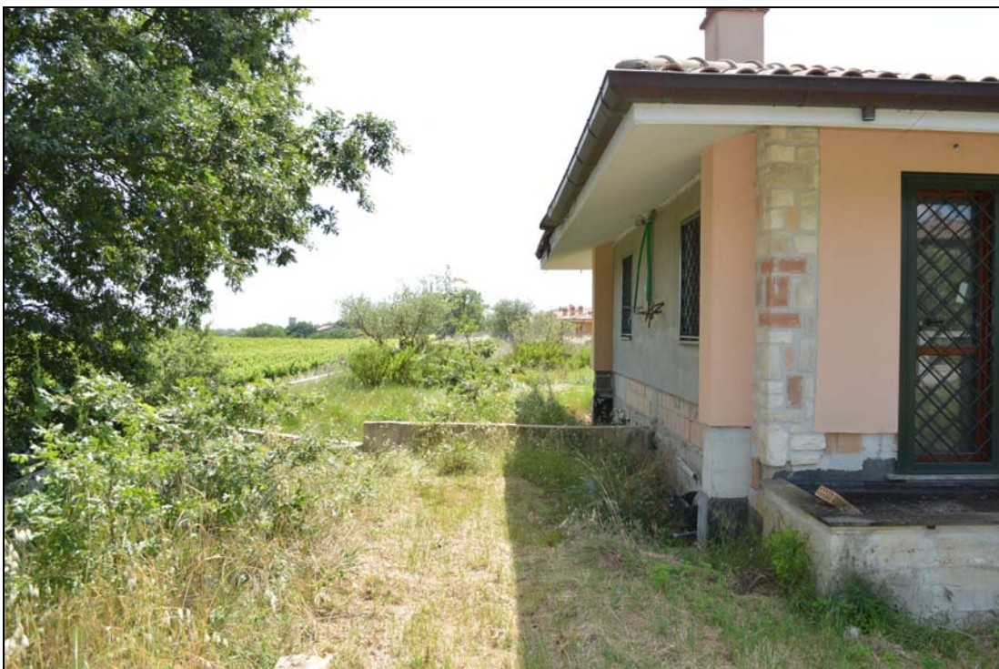
Foto n. 60 - Prospetto laterale (vialetto interno particella 1120)
