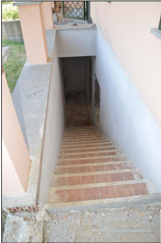
Foto n. 36 – Scala esterna accesso piano interrato
