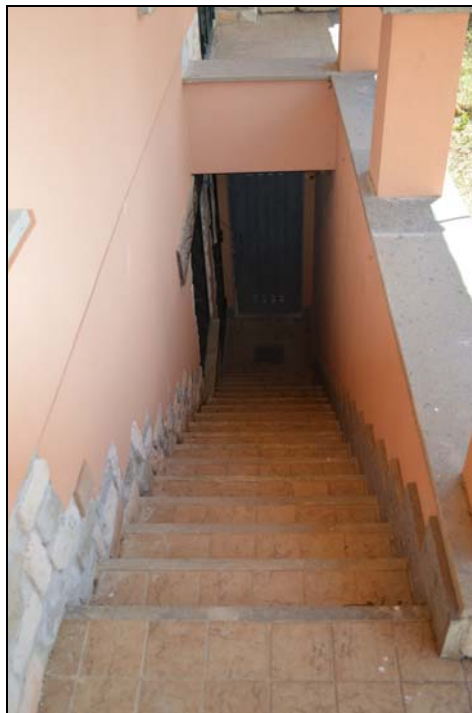
Foto n. 110 - Scala esterna accesso piano interrato
