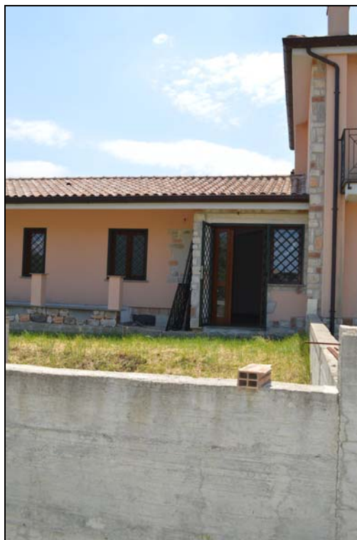
Foto n. 28 - 29 - Prospetto ingresso (vialetto interno particella 1137)
