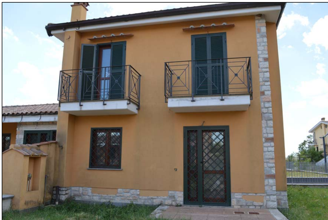
Foto n. 8 - Prospetto lato ingresso (vialetto interno particella 1128)
