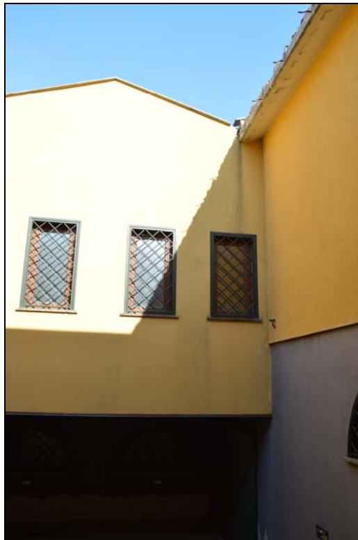
Foto n. 137 – Prospetto interno (strada interna garage)
