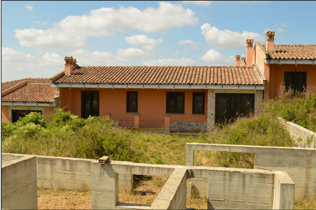
Foto n. 44 - Prospetto ingresso (vialetto interno particella 1131)
