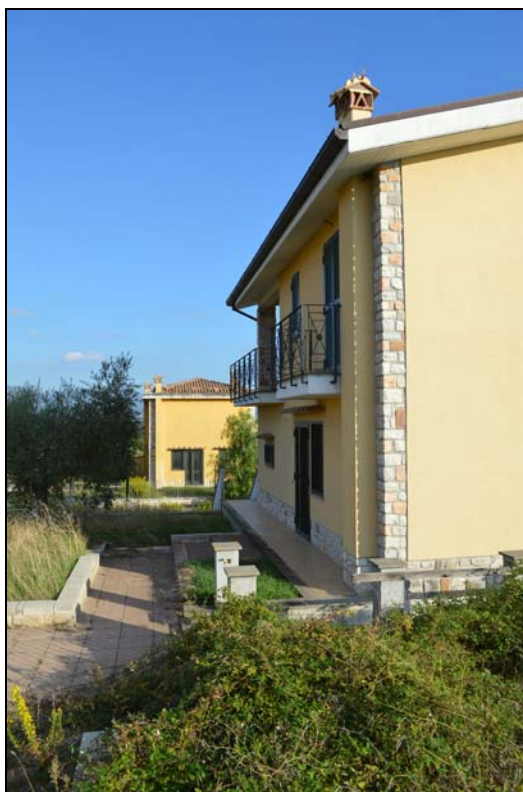
Foto n. 28 - Fronte lato destro
