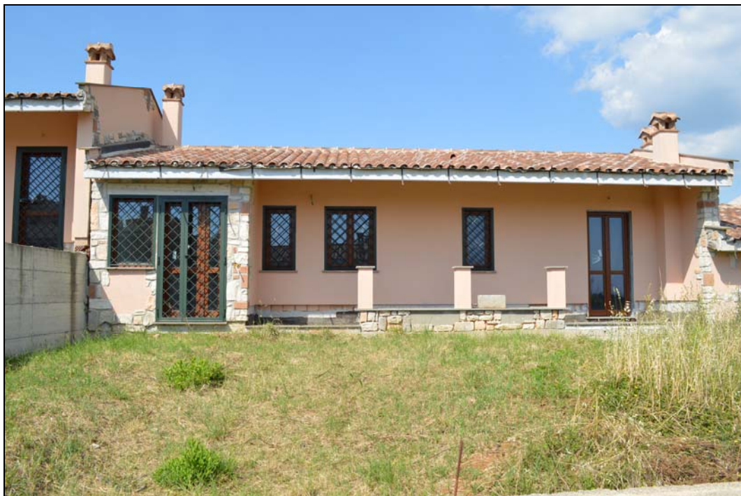
Foto n. 106 - Prospetto ingresso (vialetto interno particella 1131)
