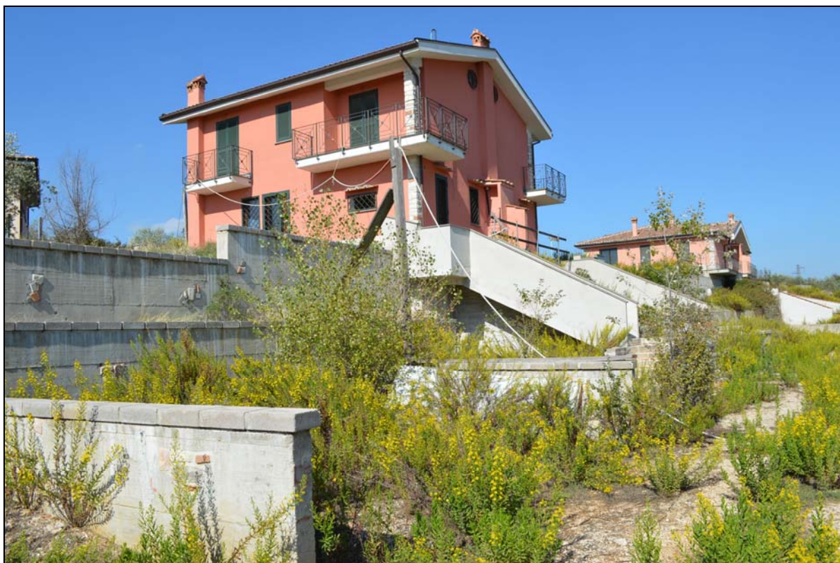
Foto n. 3 - Fronte lato strada di lottizzazione – lato sinistro
