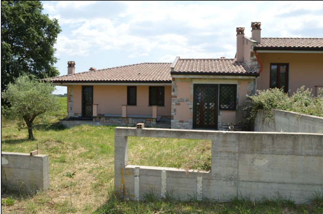
Foto n. 59 - Prospetto ingresso (vialetto interno particella 1137)
