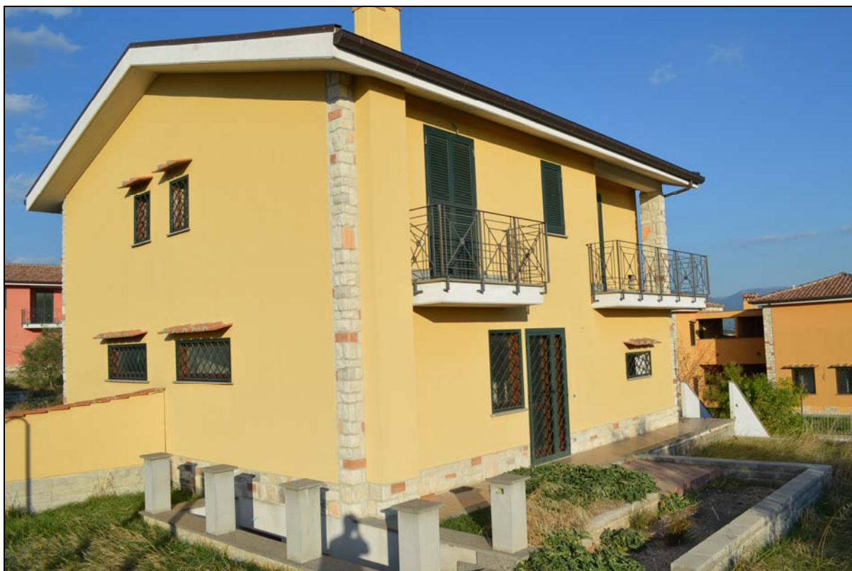
Foto n. 3 - Fronte lato sinistro – lato posteriore
