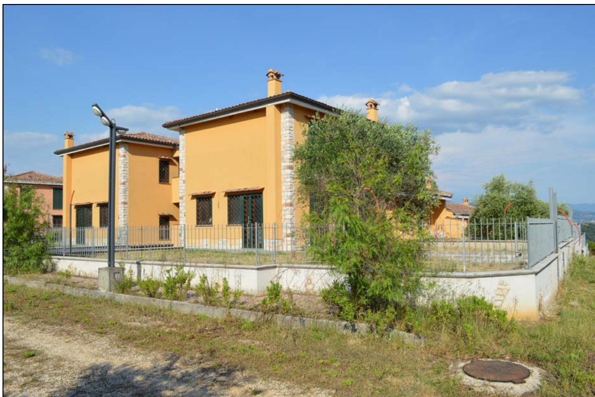
Foto n. 1 - 2 - Fronte di testa lato strada di lottizzazione
