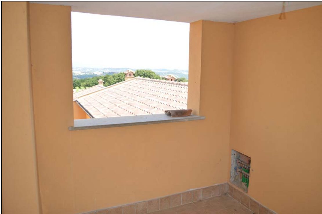
Foto n. 69 – Vista posteriore da loggia 2 (P.1)
