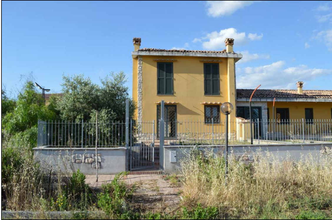
Foto n. 76 - Prospetto lato ingresso (vialetto interno particella 1117)
