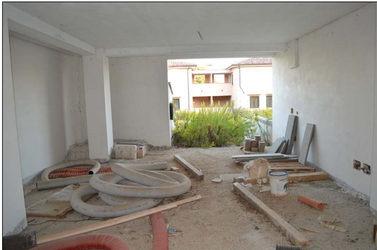
Foto n. 33 - 34 – Rampa garage (Sub. 2)
