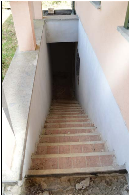
Foto n. 61 - Scala esterna accesso piano interrato
