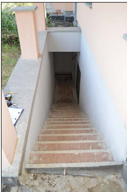
Foto n. 46 - Scala esterna accesso piano interrato
