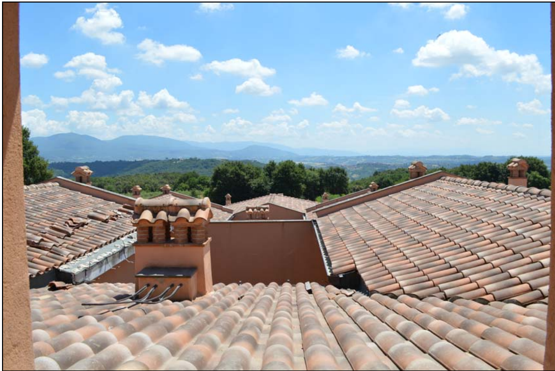
Foto n. 89 – Vista posteriore da loggia 2 (P.1)
