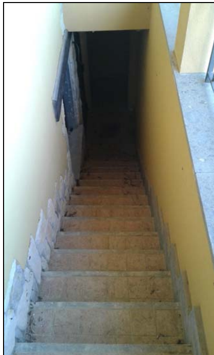
Foto n. 111 - Scala esterna accesso piano interrato
