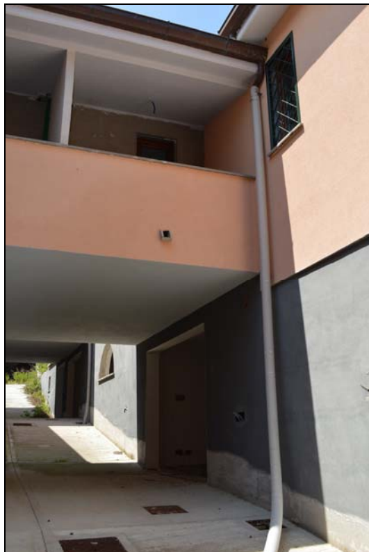
Foto n. 54 – Prospetto interno (strada interna garage)
