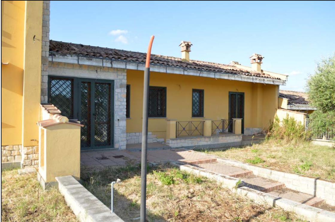
Foto n. 94 - Prospetto ingresso (vialetto interno particella 1117)
