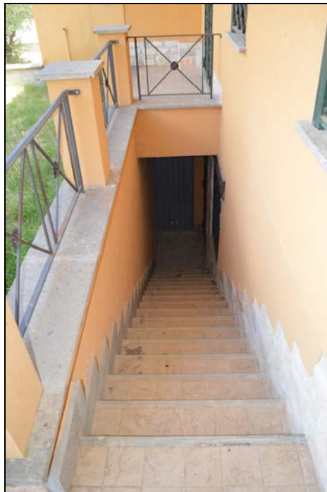
Foto n. 26 - Scala esterna accesso piano interrato
