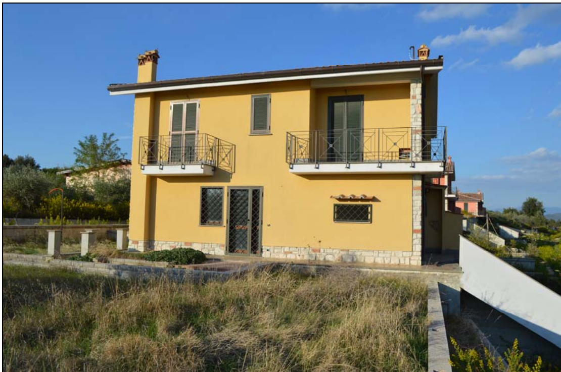
Foto n. 6 - Fronte lato sinistro
