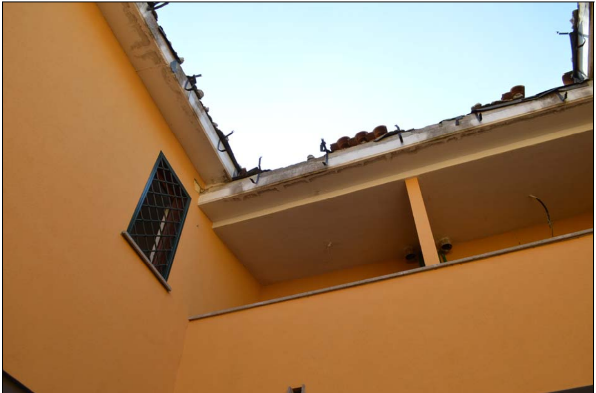
Foto n. 104 – Prospetto interno (strada interna garage)
