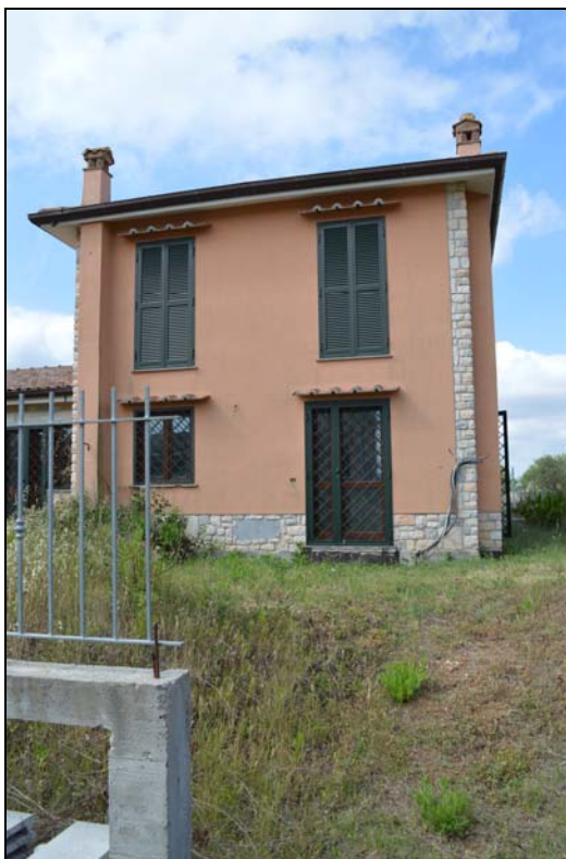
Foto n. 11 - Prospetto lato ingresso (vialetto interno particella 1131)
