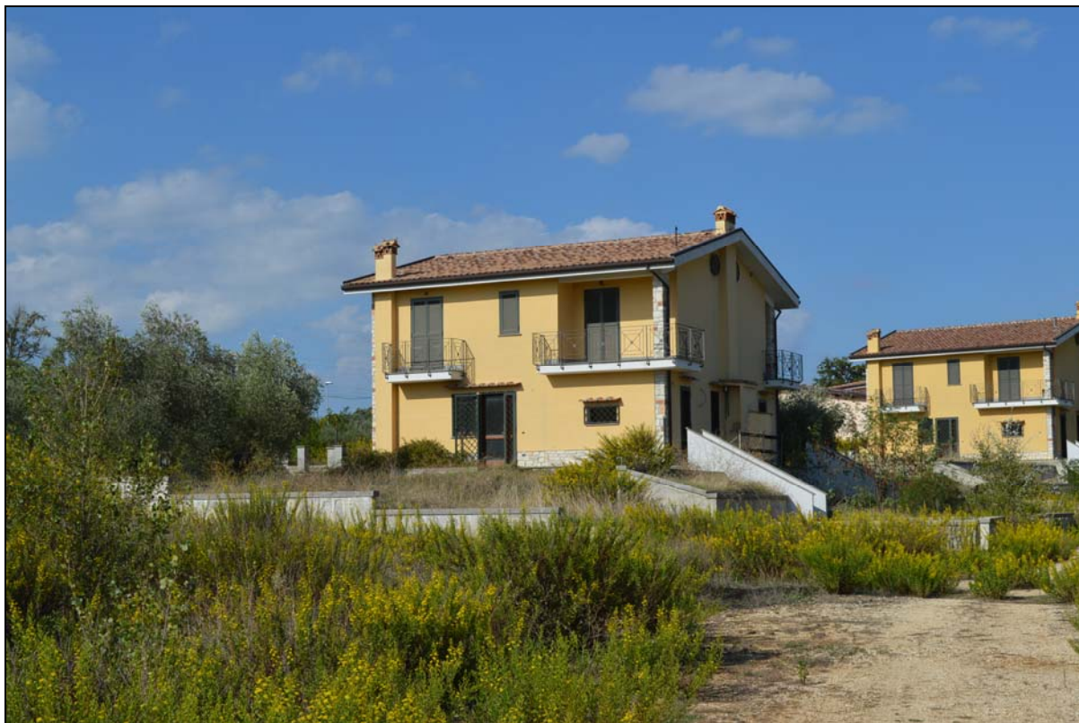
Foto n. 3 - Fronte lato sinistro
