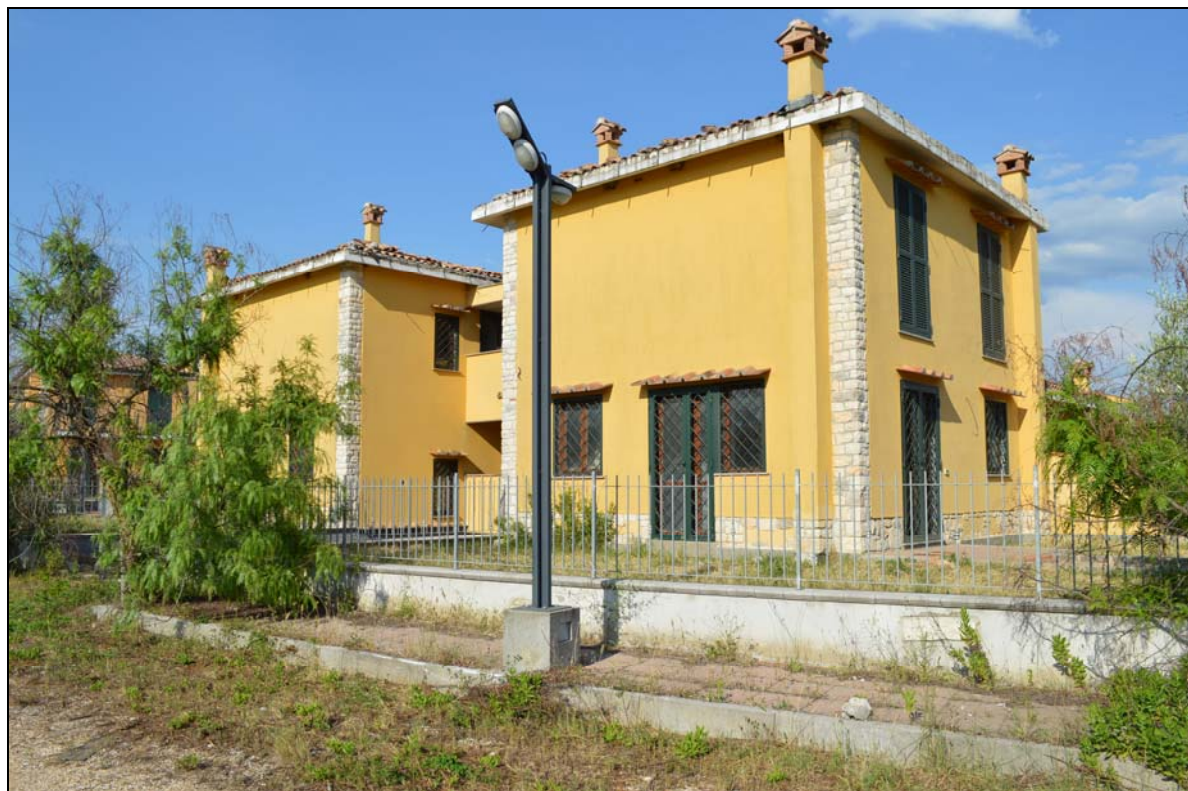
Foto n. 1 - 2 - Fronte di testa lato strada di lottizzazione
