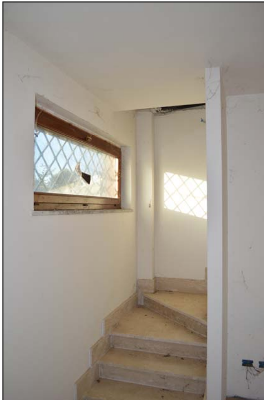
Foto n. 11 – Scala P.T. – P.1
