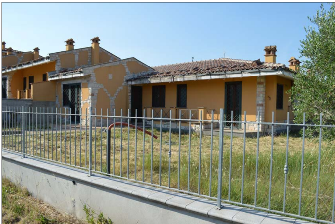
Foto n. 109 - Prospetto ingresso (vialetto interno particella 1014)
