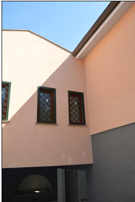
Foto n. 129 – Prospetto interno (strada interna garage)
