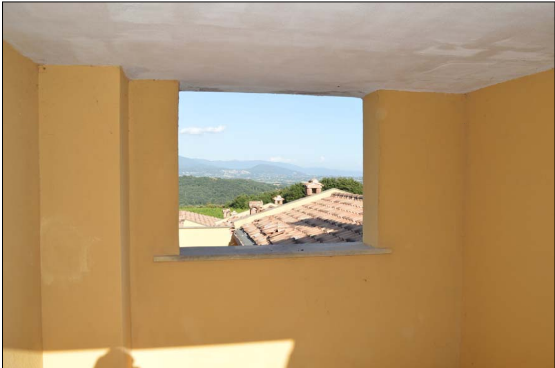
Foto n. 88 – Vista posteriore da loggia 2 (P.1)
