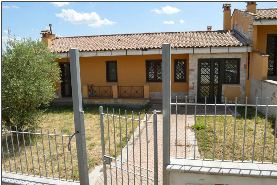
Foto n. 41 - Prospetto ingresso (vialetto interno particella 1128)
