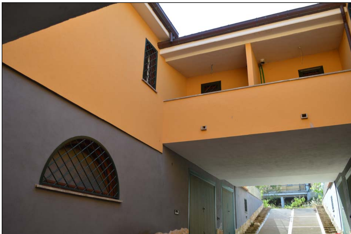
Foto n. 88 – Prospetto interno (strada interna garage)
