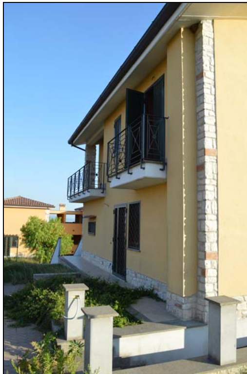
Foto n. 25 - Fronte lato destro
