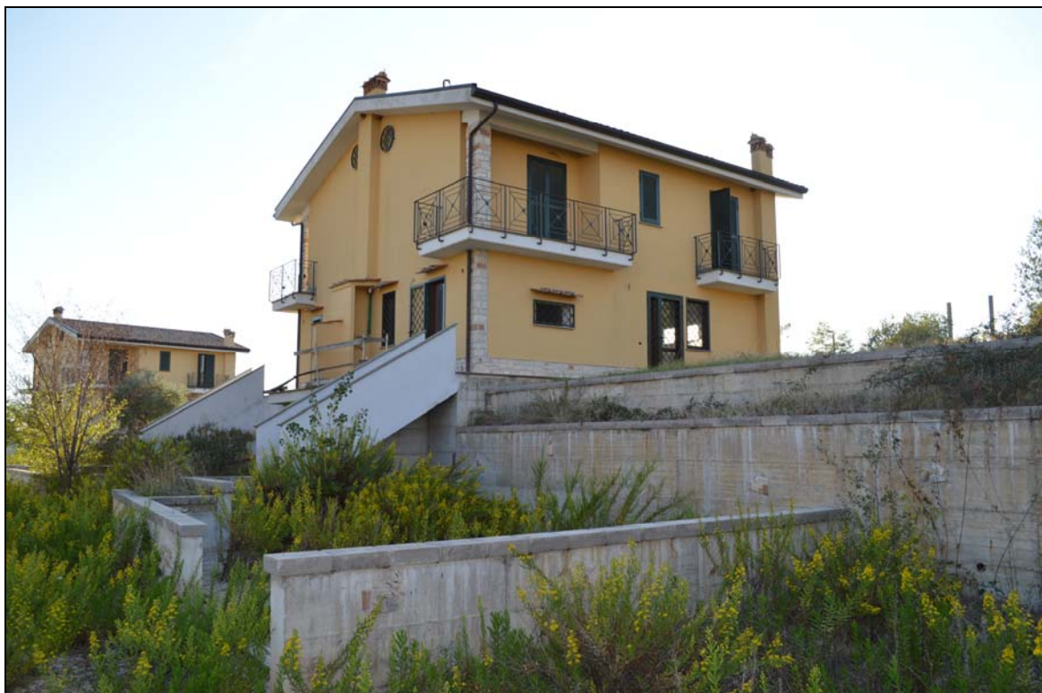
Foto n. 2 - Fronte lato strada di lottizzazione – lato destro
