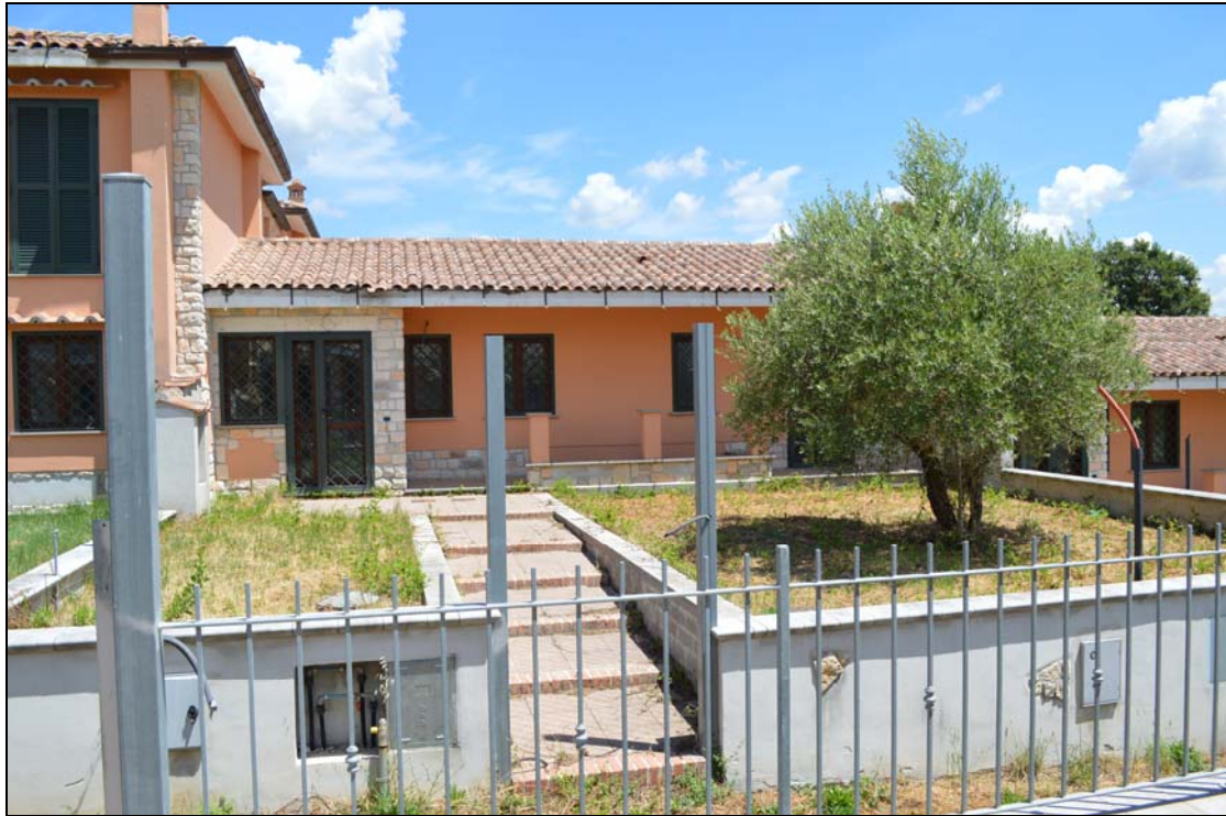
Foto n. 94 - Prospetto ingresso (vialetto interno particella 1128)
