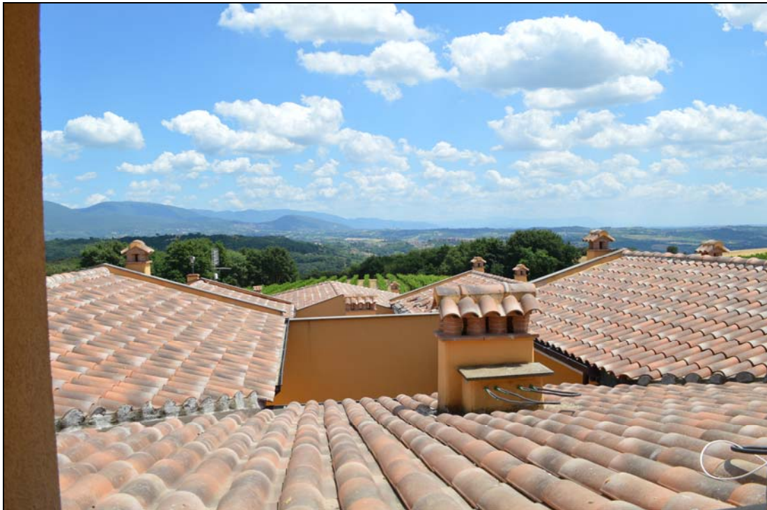
Foto n. 20 – Vista posteriore da loggia 2 (P.1)
