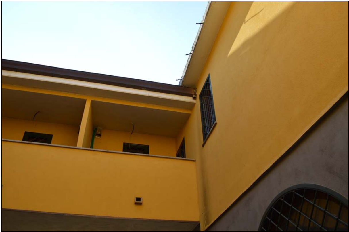
Foto n. 38 – Prospetto interno (strada interna garage)
