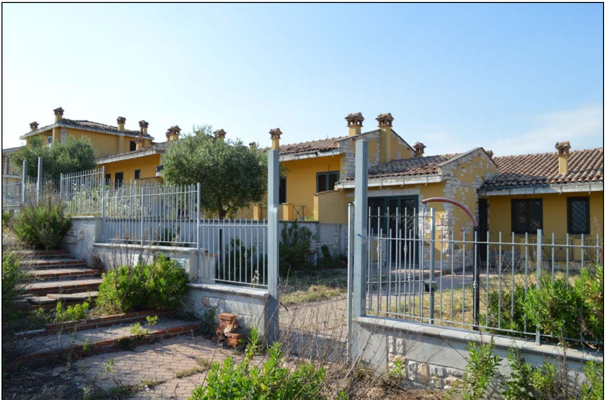
Foto n. 5 - 6 - Fronte lato sinistro (vialetto interno particella 1117)
