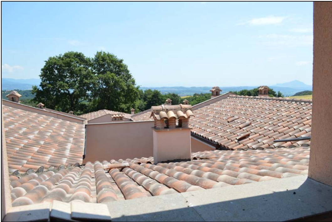
Foto n. 23 – Vista posteriore da loggia 2 (P.1)
