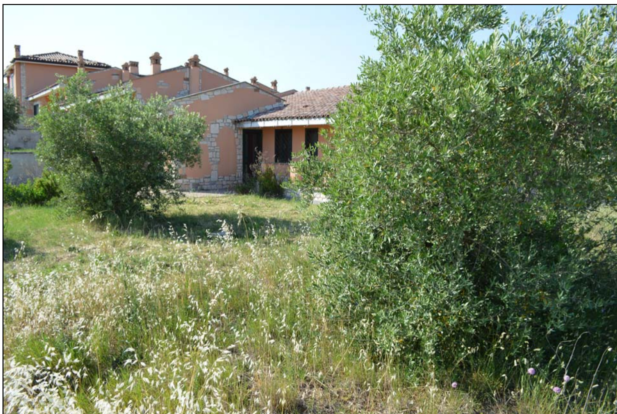
Foto n. 5 - 6 - Fronte lato sinistro (vialetto interno particella 1128)
