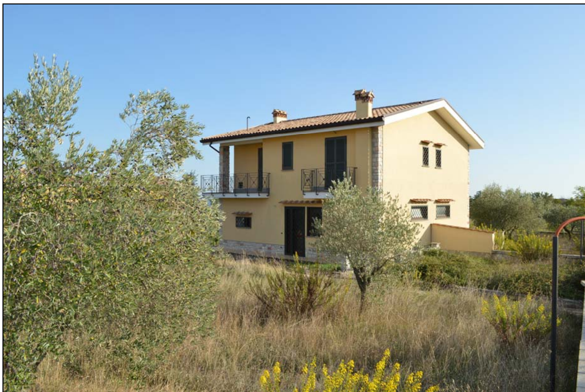
Foto n. 4 - Fronte lato destro
