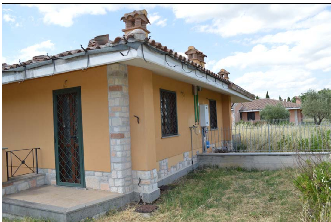
Foto n. 110 - Prospetto laterale (vialetto interno particella 1120)
