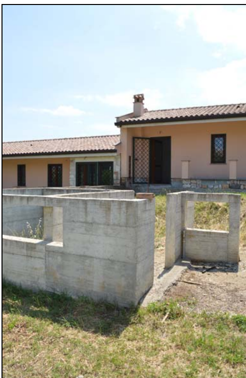
Foto n. 34 - 35 - Prospetto ingresso (vialetto interno particella 1137)
