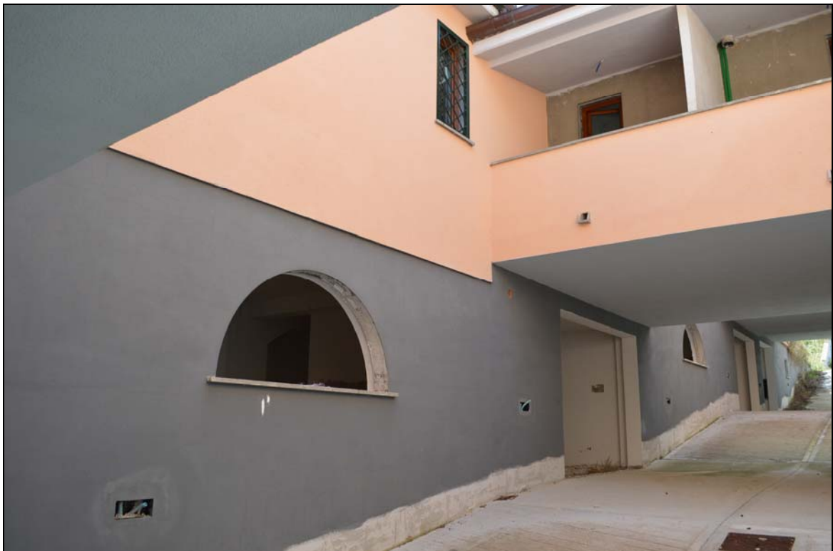
Foto n. 115 – Prospetto interno (strada interna garage)
