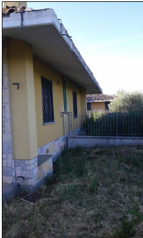
Foto n. 127 - Prospetto laterale (vialetto interno particella 1120)
