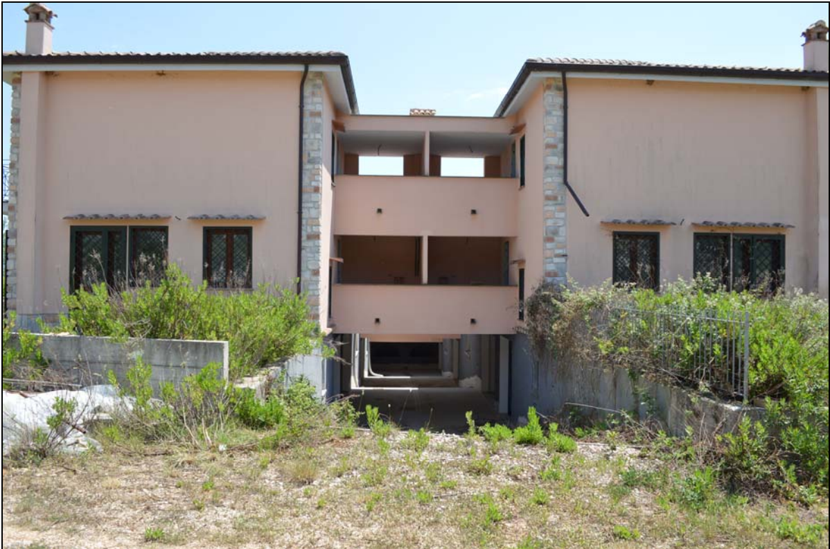
Foto n. 1 - 2 - Fronte di testa lato strada di lottizzazione
