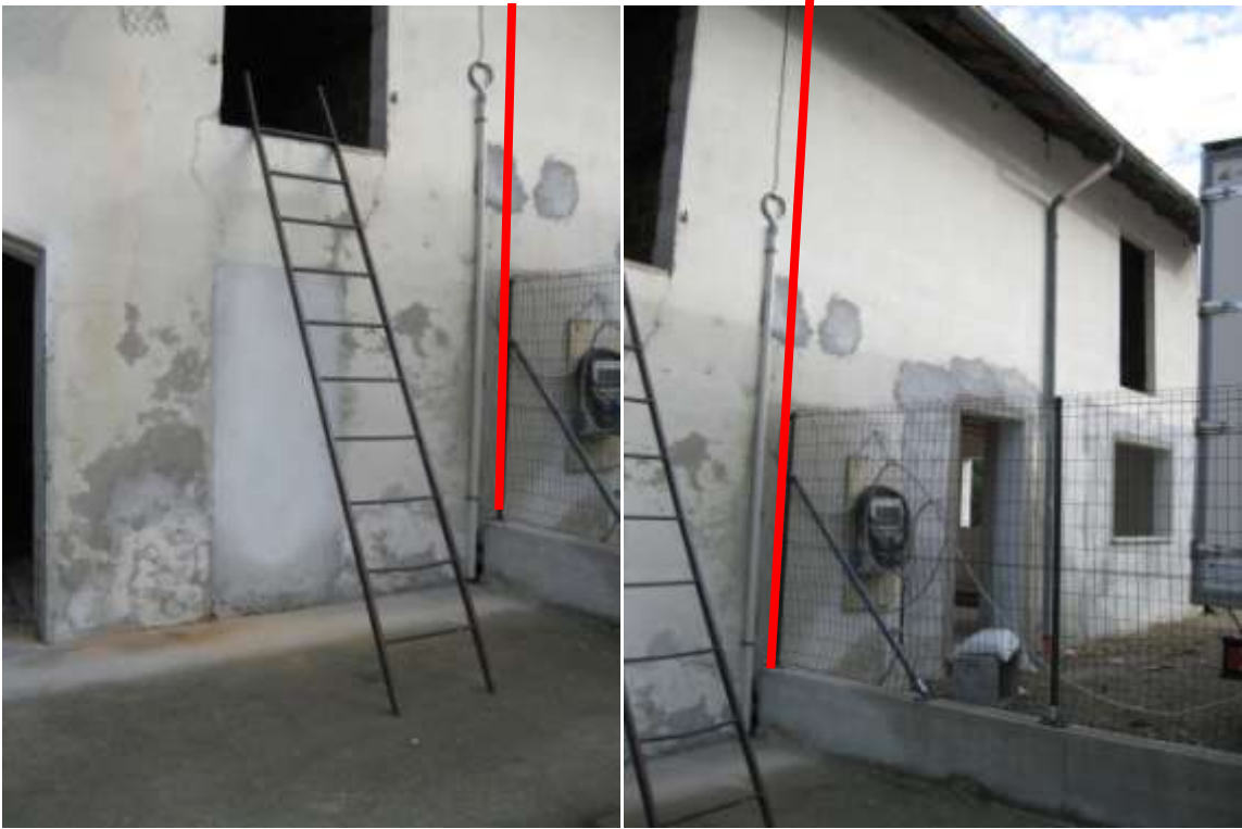
Foto 5 e 6 Confine con altra proprietà in fase di ristrutturazione
