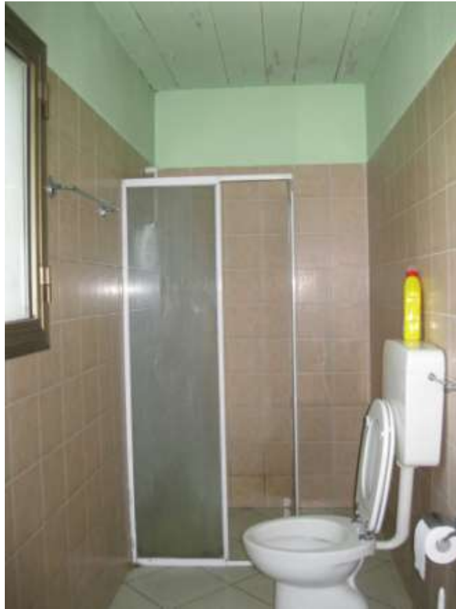
Foto 12 Bagno ricavato dalla "cantina"
