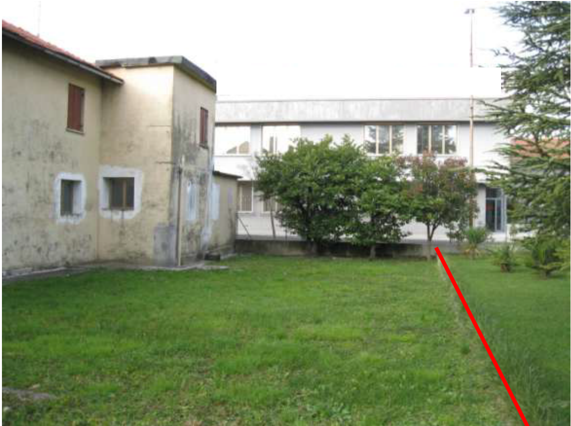
Foto 3 Particolare pertinenza esterna sul retro. Con indicata in rosso la delimitazione della proprietà
