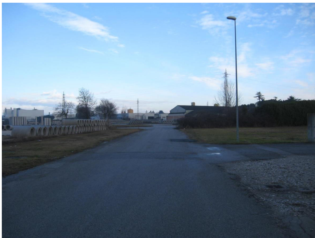
STRADA D'ACCESSO – VIA BUIA – FONDO CIECO A NORD-EST
