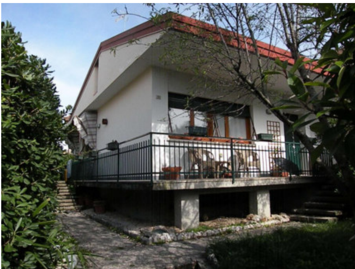
2 - Lato Sud ed Ovest
