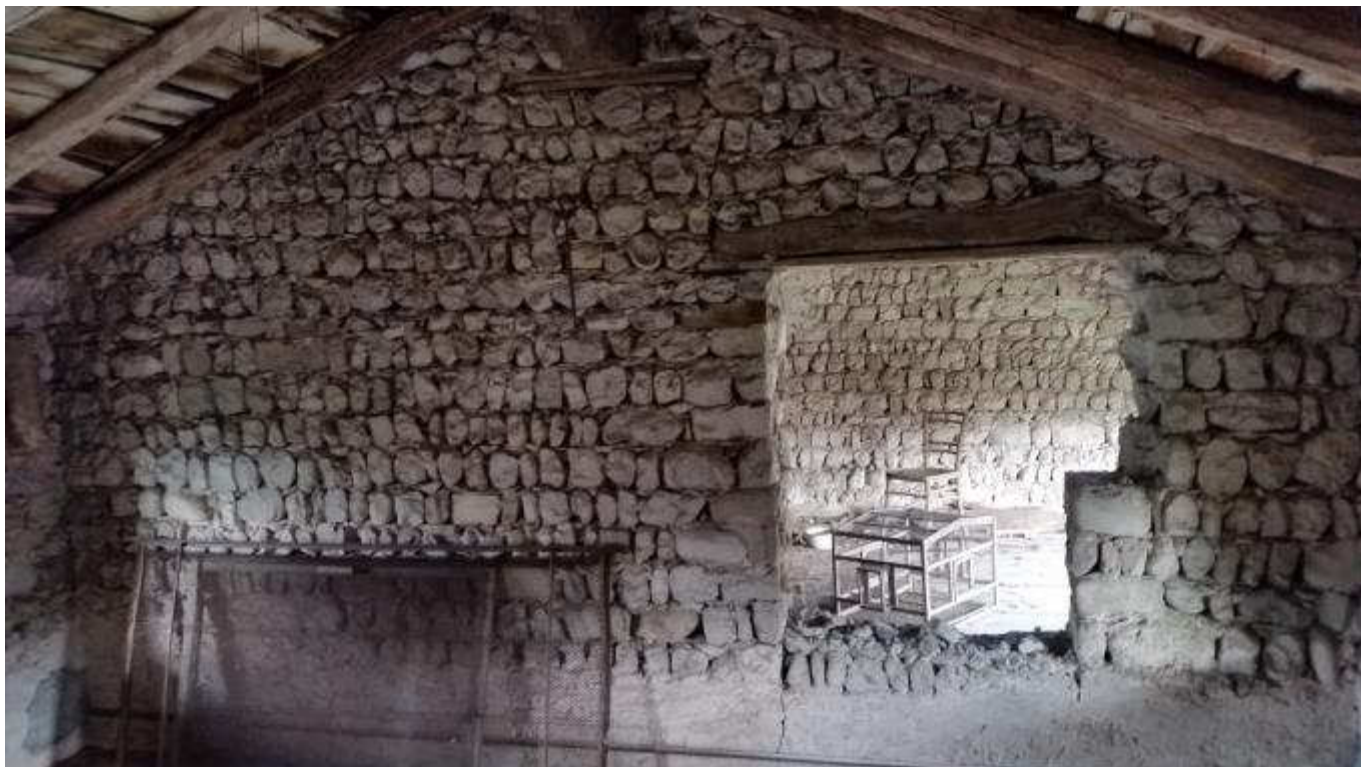
Foto 21: Soffitta al 2°P. (Mapp.714).
