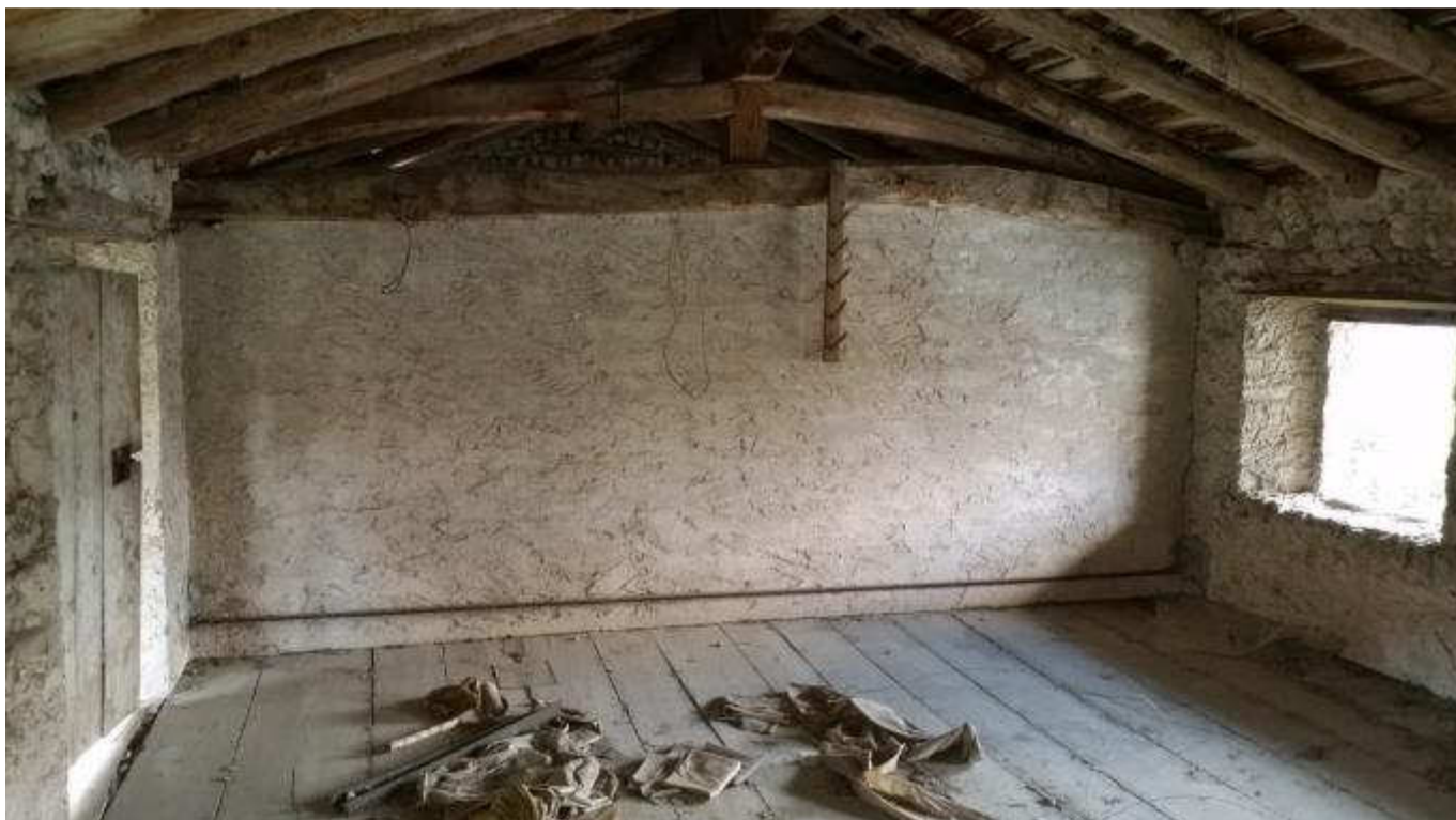
Foto 19: Soffitta al 2°P. (Mapp.714).
