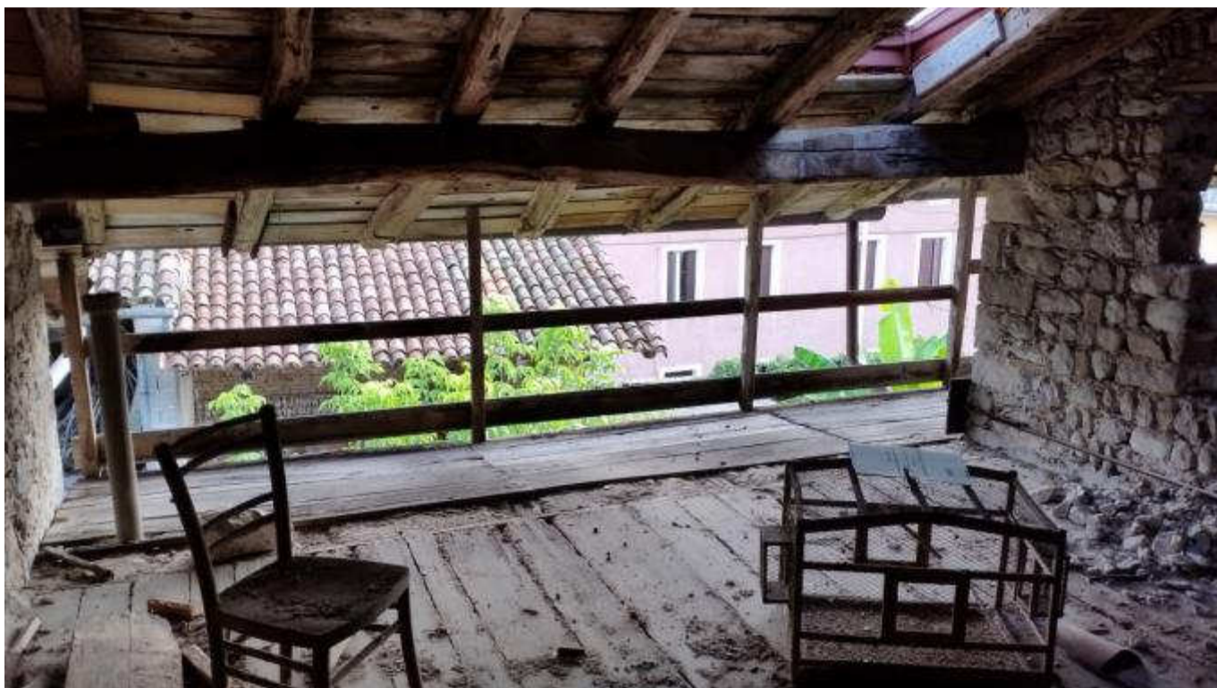
Foto 20: Soffitta al 2°P. verso terrazza (Mapp.714).
