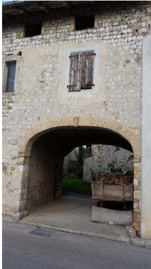
Foto 23: Androne d'ingresso (civ.49/51 di via Umberto I°) di altra proprietà che consente di accedere al piccolo appezzamento di terreno oggetto di E.I. (Mapp. 706) dalla via pubblica.
