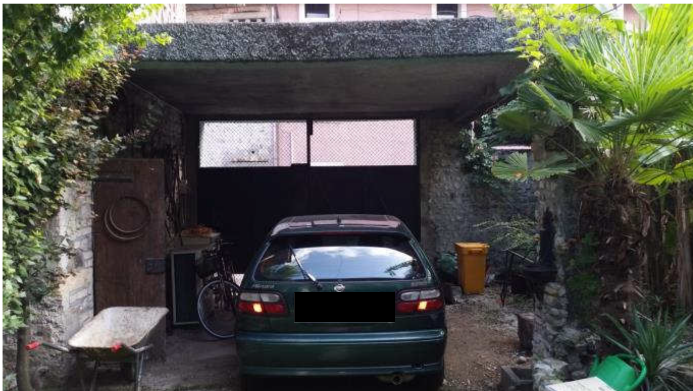
Foto 3: Portico d'ingresso oggetto di esecuzione immobiliare ( ex Mapp.1273 ), utilizzato anche come posto auto.
