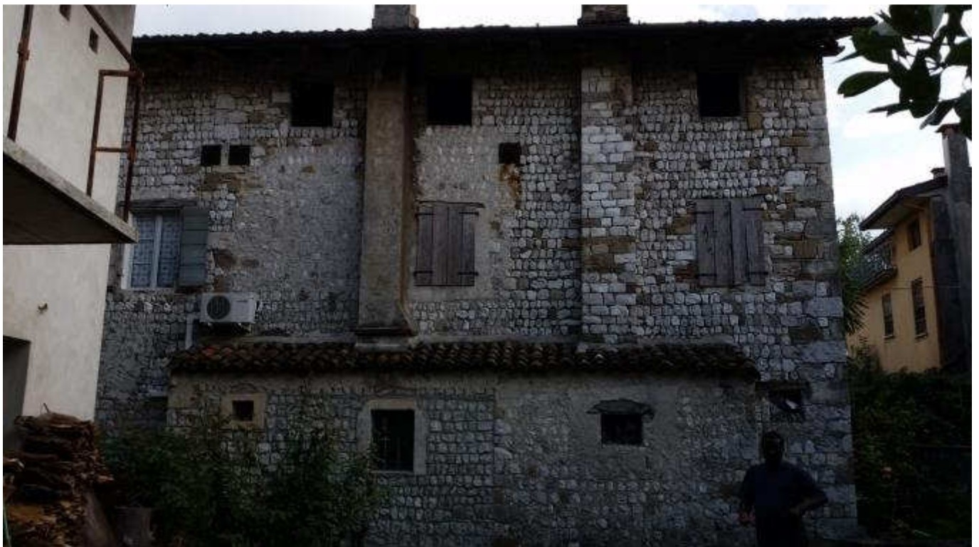
Foto 24: Prospetto Nord del fabbricato oggetto di esecuzione immobiliare (Mapp. 714) in prossimità del piccolo terreno identificato con il Mapp.706.
