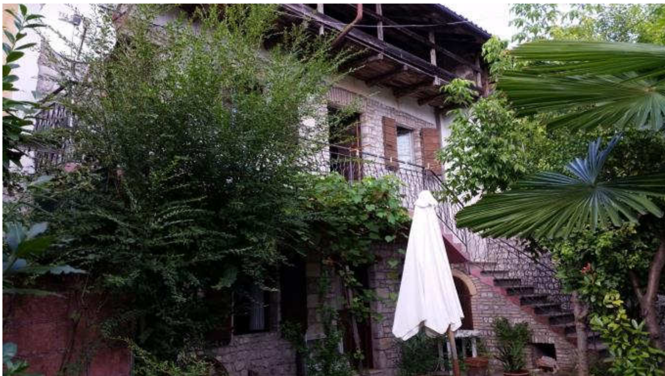
Foto 9: Prospetto Sud del fabbricato d'abitazione oggetto di esecuzione immobiliare (Mapp.714).
