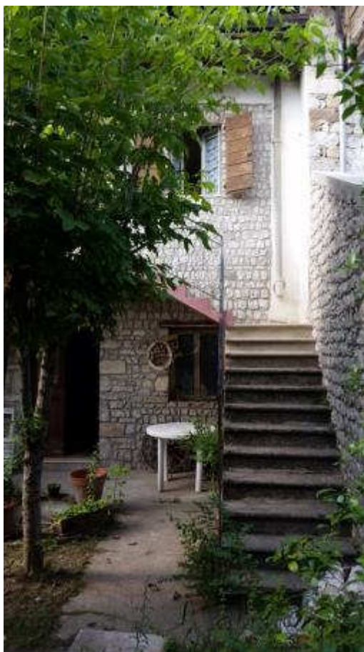
Foto 7: Prospetto Sud dell'abitazione oggetto di E.I., in corrispondenza della scala esterna per l'accesso al 1°P. (Mapp.714).
