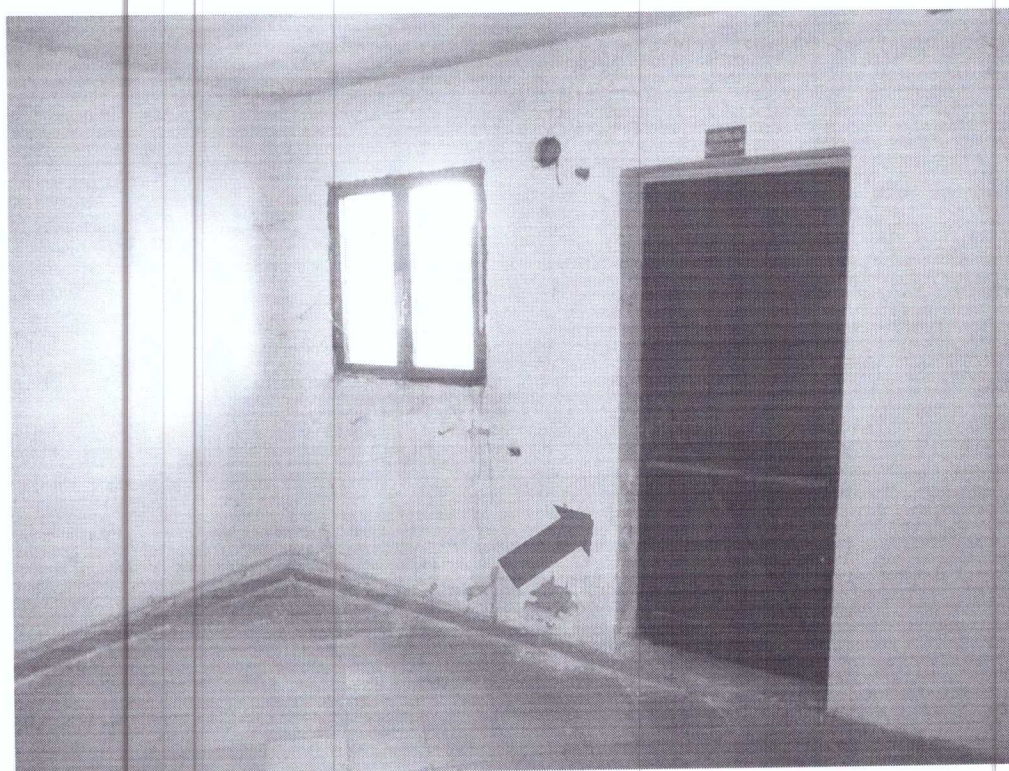
- FOTO 12 - SALA 3 - IN EVIDENZA L'USCITA DI SICUREZZA -
