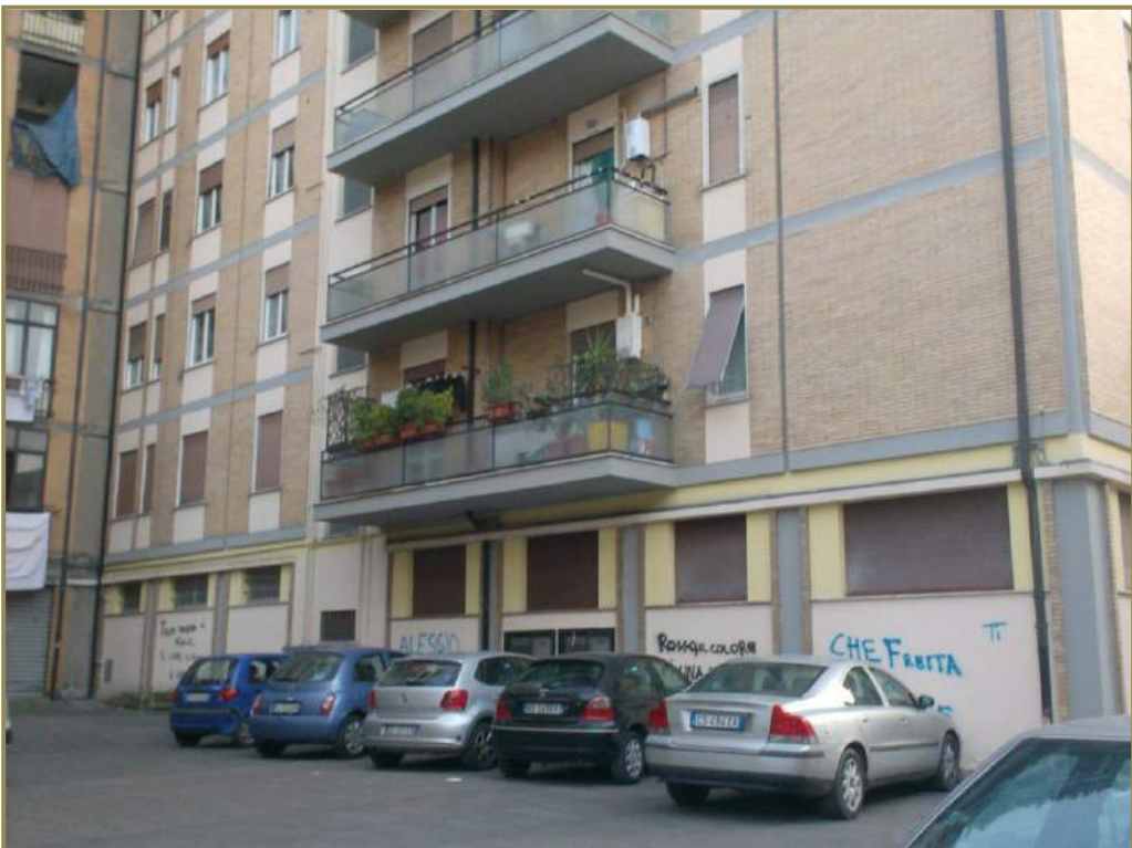
4-vista retro dell'edificio
