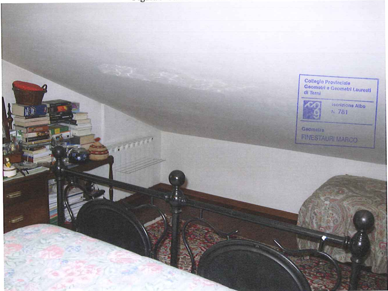
Figura 10 Camera 2 Piano Primo
