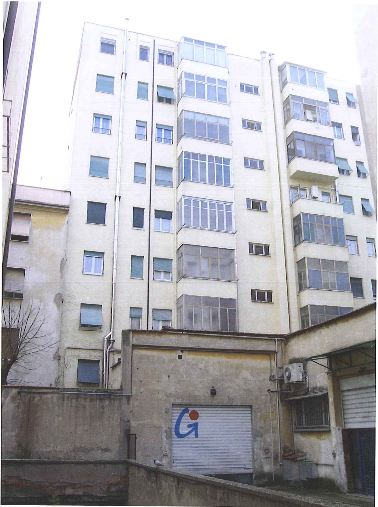
Figura 26 Facciata Prospetto Nord
