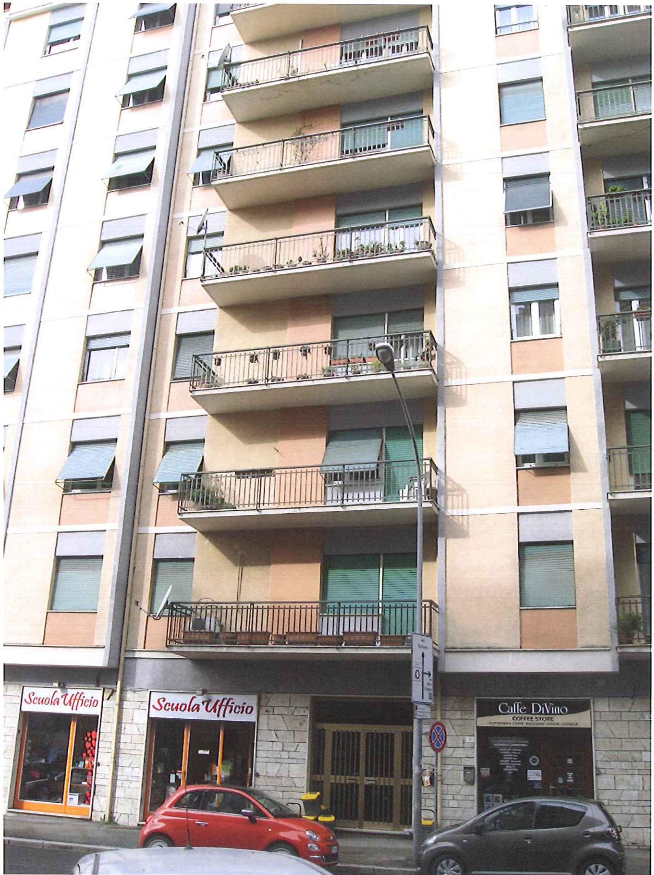
Figura 23 Facciata Prospetto Sud
