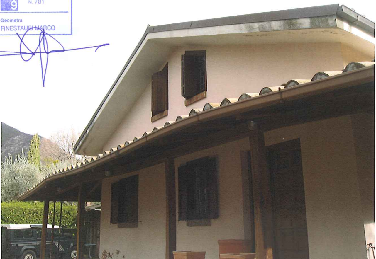
Figura 33 Particolare Fabbricato Lato Ovest
