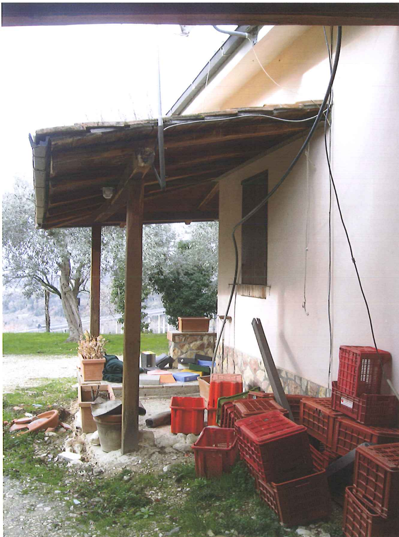
Figura 35 Particolare Fabbricato Lato Sud
