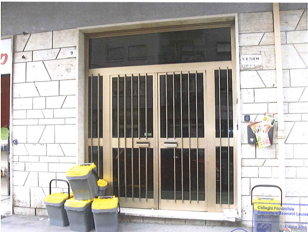
Figura 22 Portone di Ingresso
