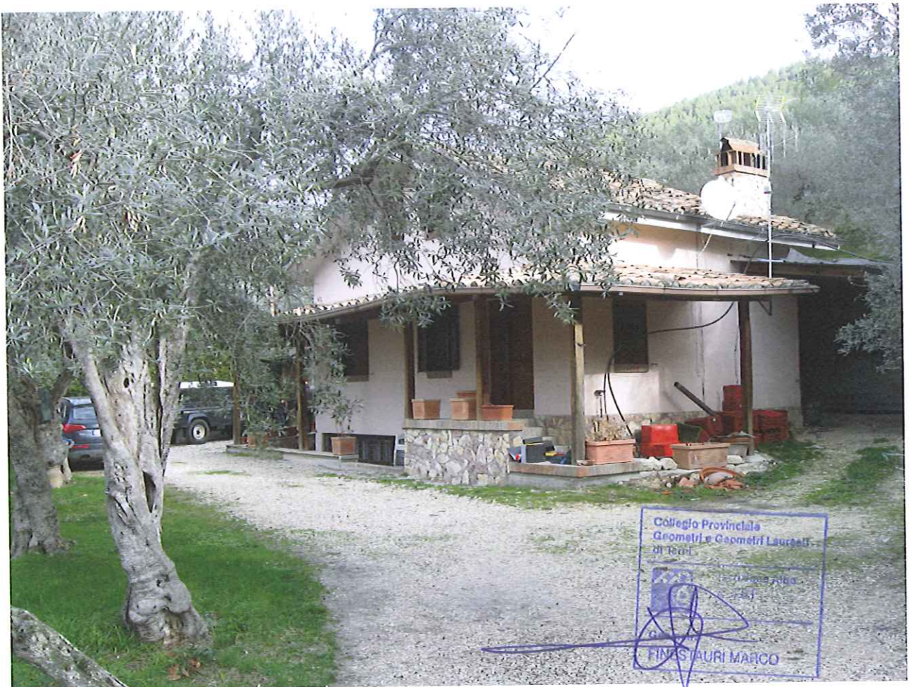
Figura 39 Foto Fabbricato Lato Sud-Ovest
