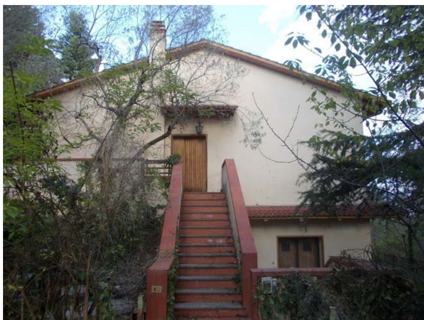
Foto 09 Prospetto ovest ed accesso piano primo
