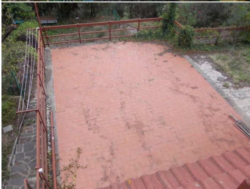
Foto 17 Lastrico copertura garage
