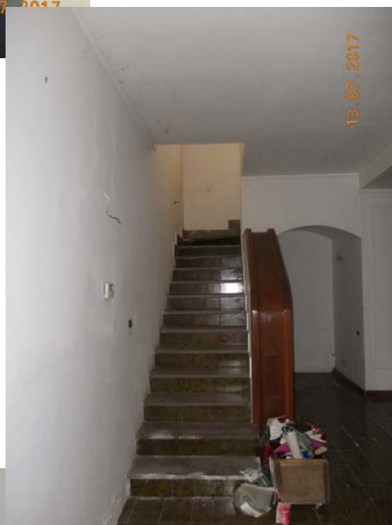
Foto 23 Piano terra Scala interna
