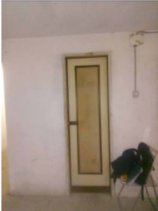
Ingresso locale cantina
