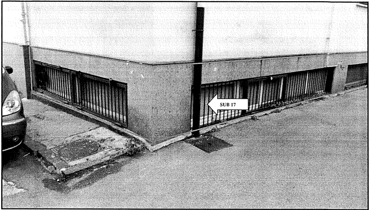
Figura 13 – Immobili piano seminterrato – Sub 17 – Affaccio angolo Via Colasanto
