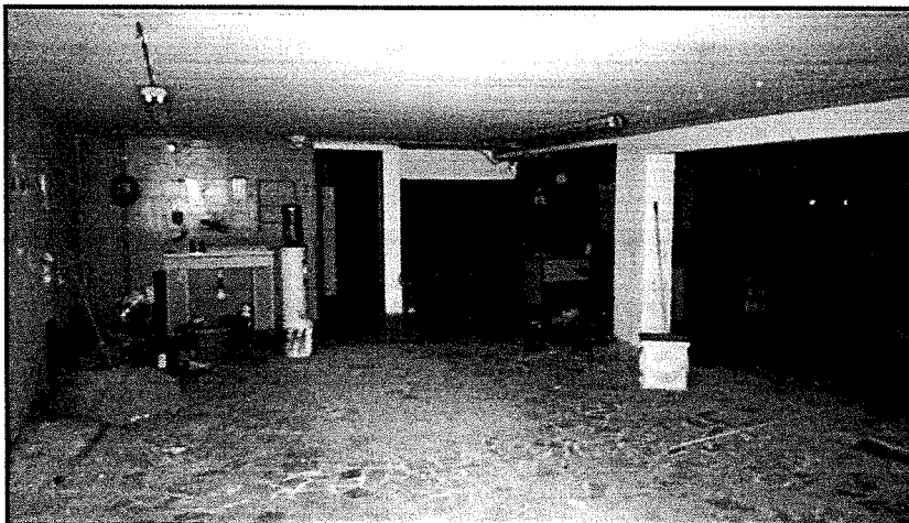
Figura 16 - Locale parte bassa con vista verso l'ingresso - Sullo sfondo il bagno
