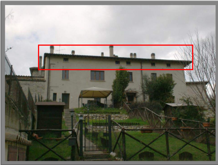
Prospetto Sud dell'edificio con vista degli affacci del Sub. 9 e del Sub. 11
