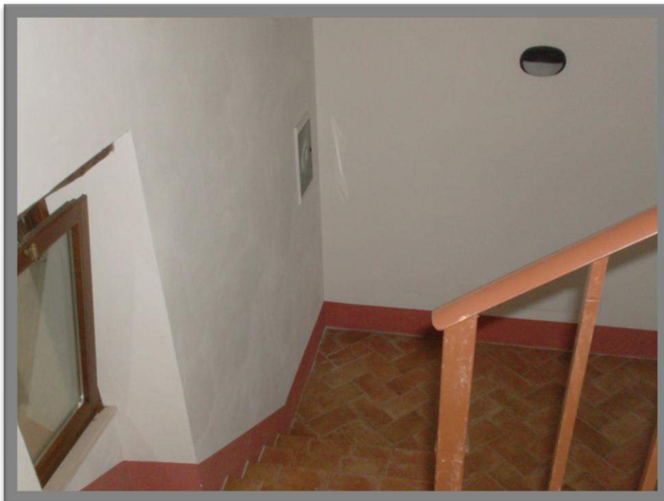
Vano scala comune ai Sub. 9 e Sub. 11
