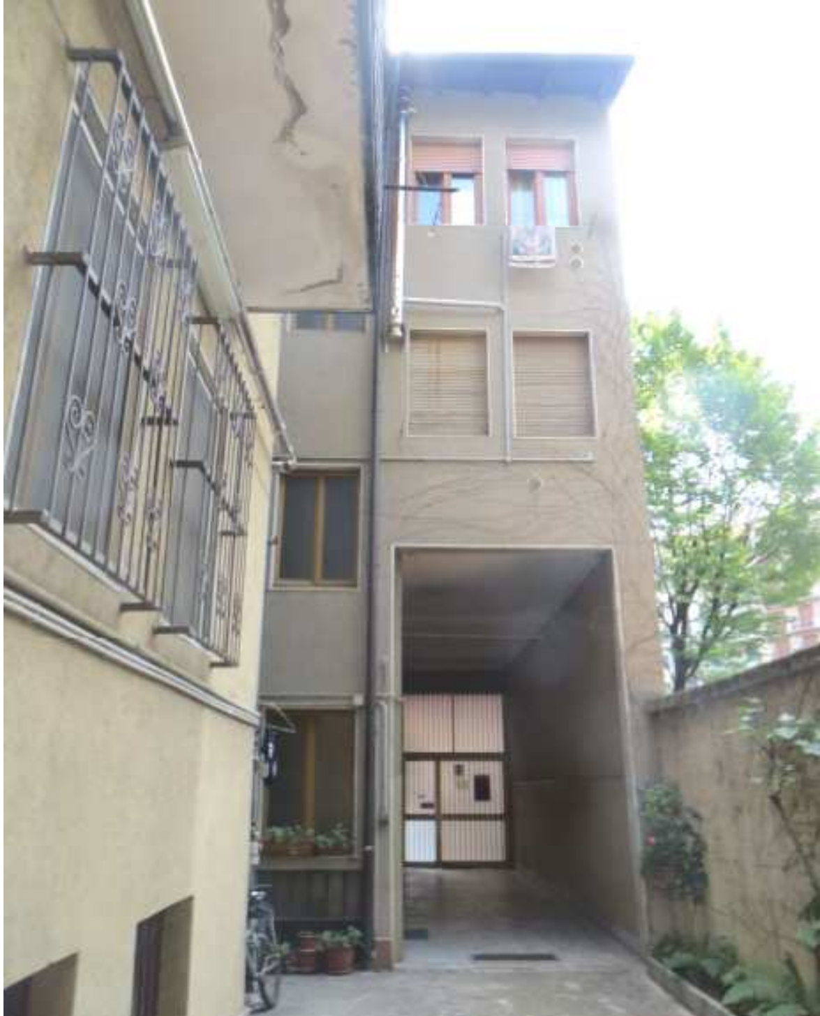
Vista del fabbricato dal cortile interno
