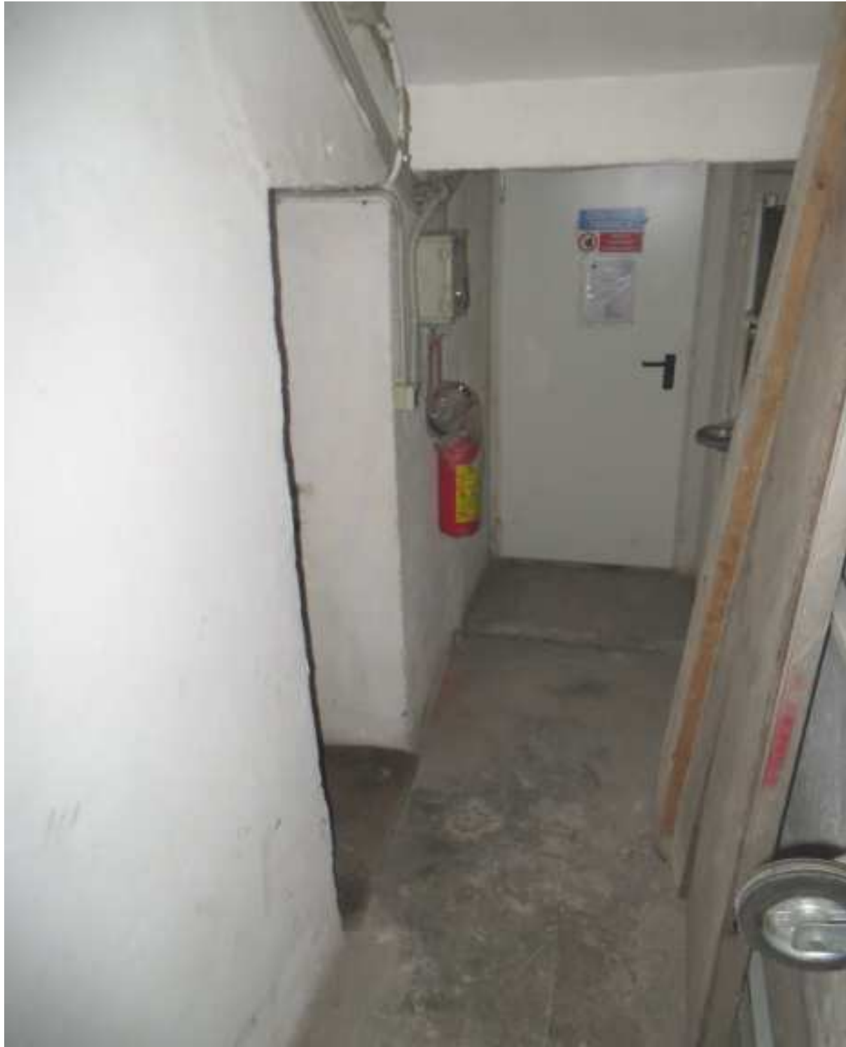
Vista del passaggio comune di accesso per accesso alla cantina
