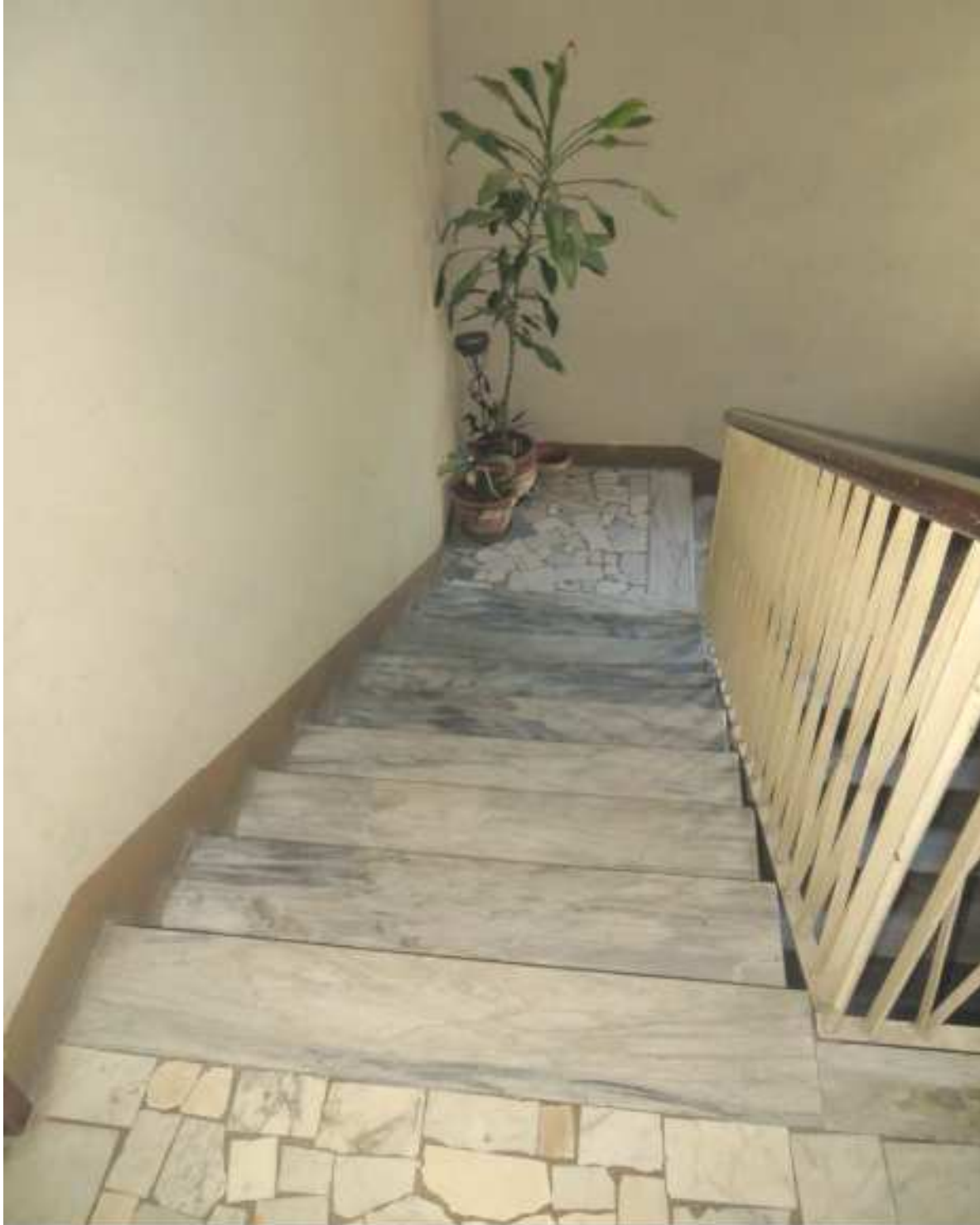
Vista del vano scala comune
