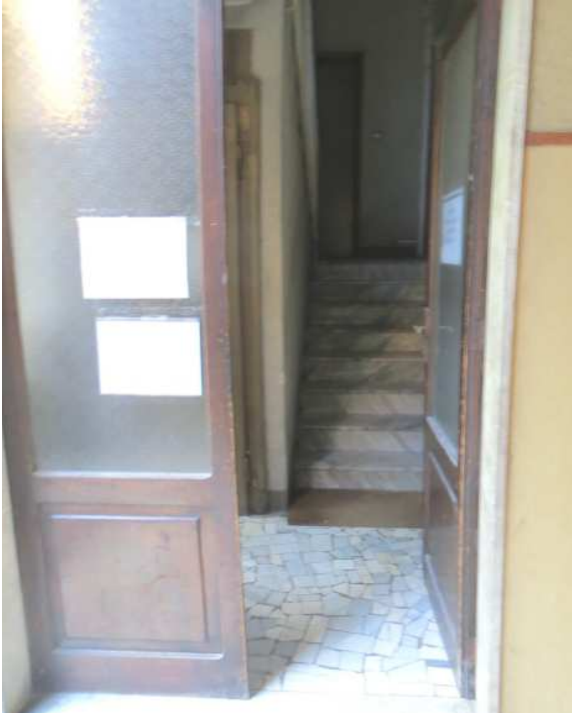
Vista ingresso al fabbricato dall'androne comune
