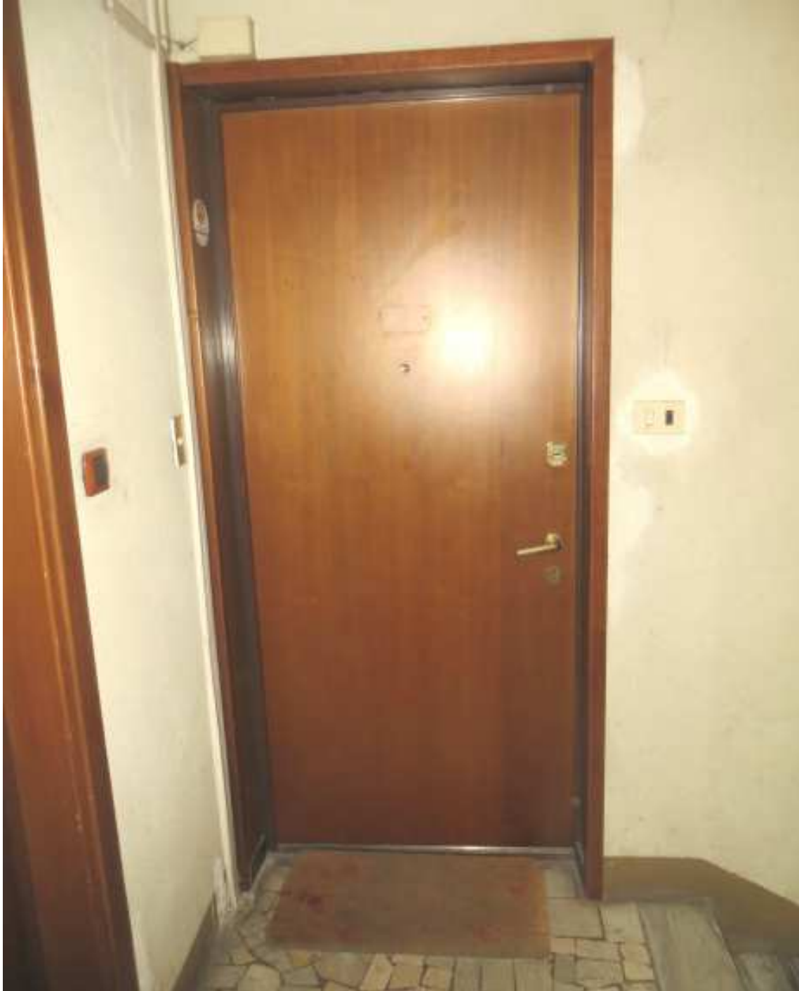
Vista portoncino di ingresso all'appartamento
