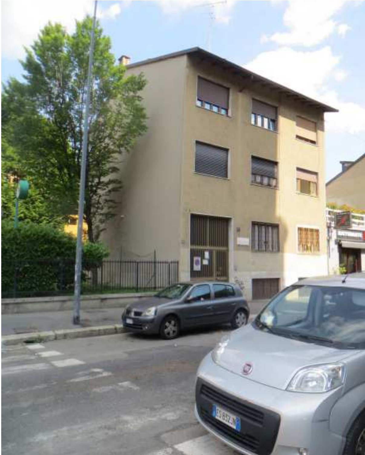
Vista del fabbricato da via Curio Dentato
