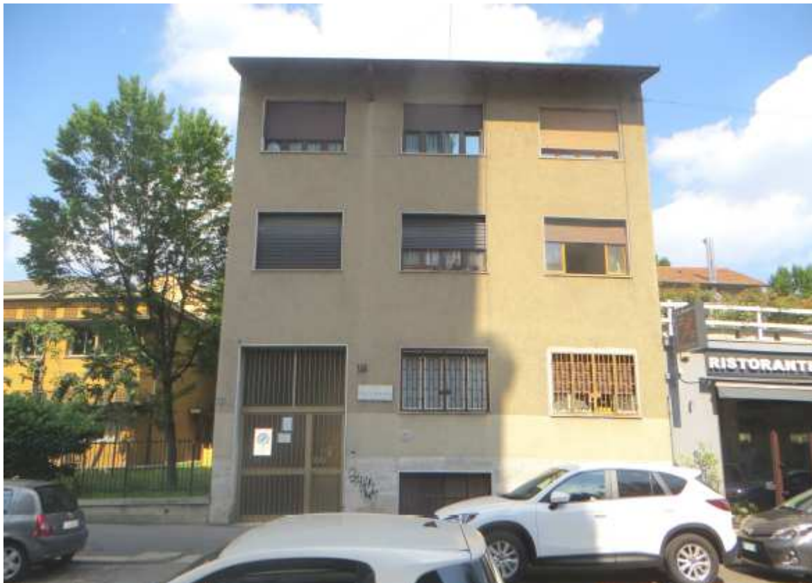
Vista del fabbricato da via Curio Dentato
