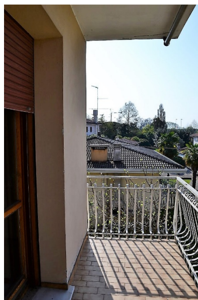
foto n. 16 – terrazzino fronte ovest
