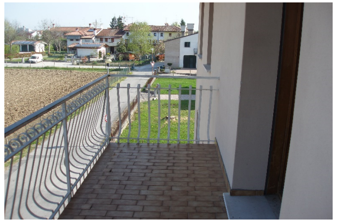
foto n. 14 – terrazzino fronte nord
