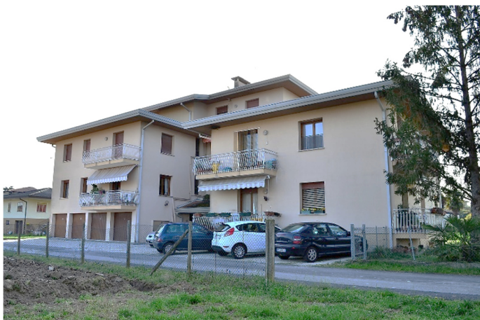
foto n. 1 – condominio - prospetto nord
