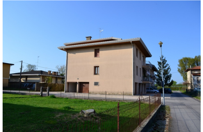
foto n. 2 – condominio - prospetto est
