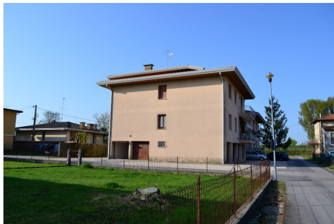
foto n. 2 – condominio - prospetto est
