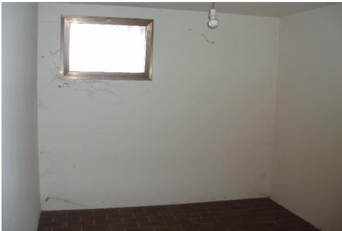
foto n. 15 – ripostiglio/cantina al piano terra
