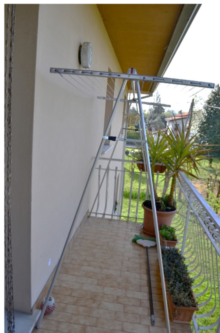
foto n. 14 – terrazzino fronte ovest
