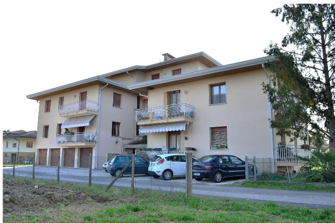
foto n. 1 – condominio - prospetto nord
