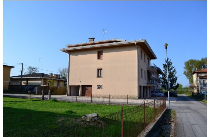
foto n. 2 – condominio - prospetto est
