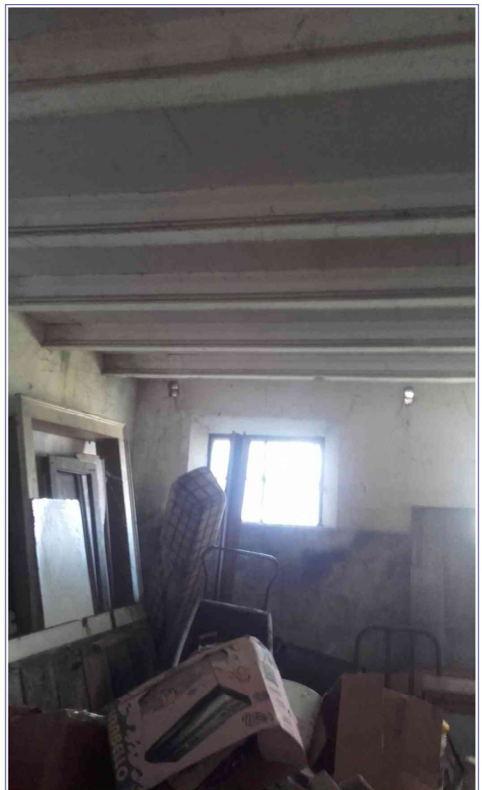
26 – CORPO C – INTERNO - Piano Terra
