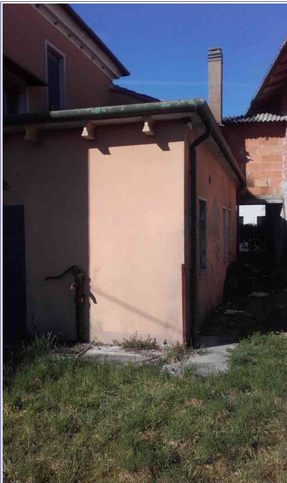
04 – Esterno Nord – CORPO A
