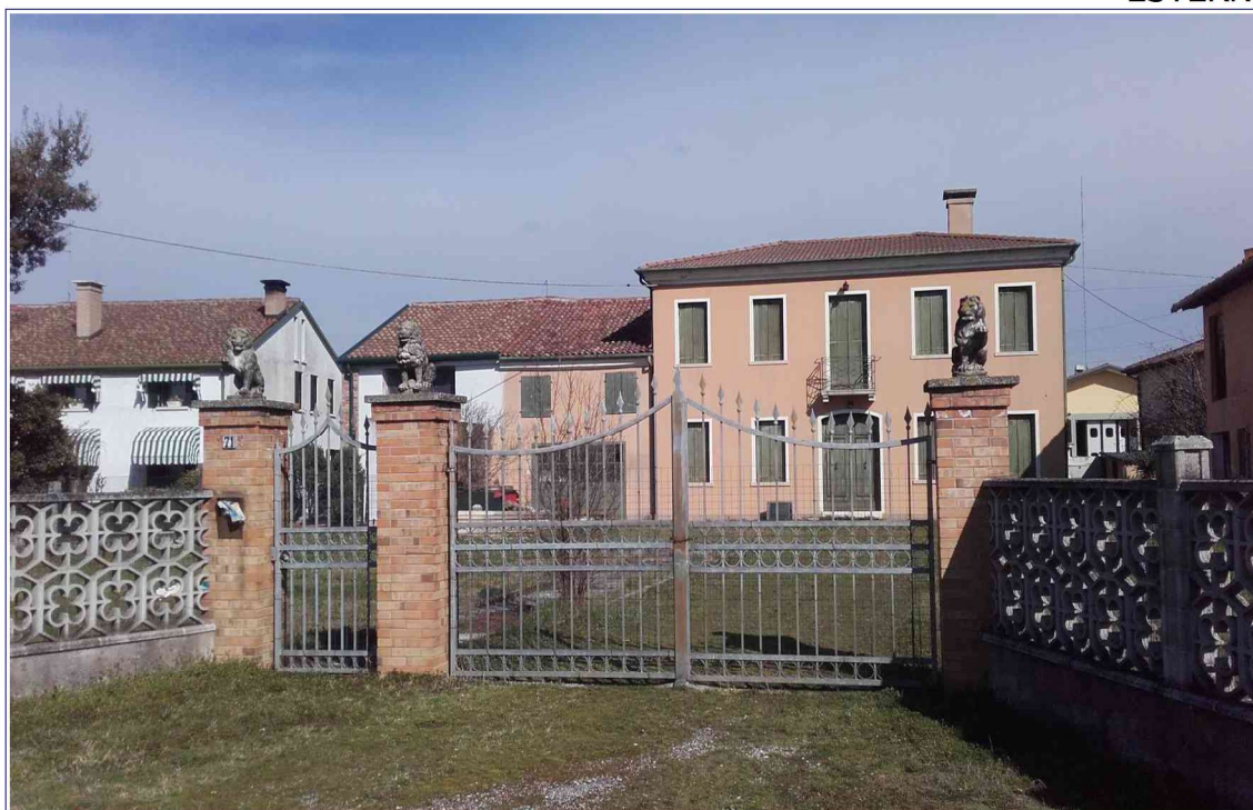
01 - Esterno sud - INGRESSO
