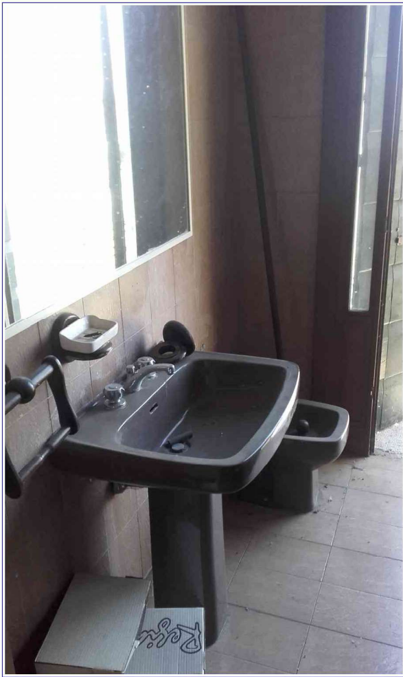
19 – CORPO A – Bagno Piano Primo
