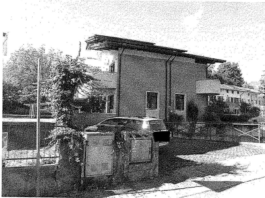
Prospetto sud-est del compendio.
