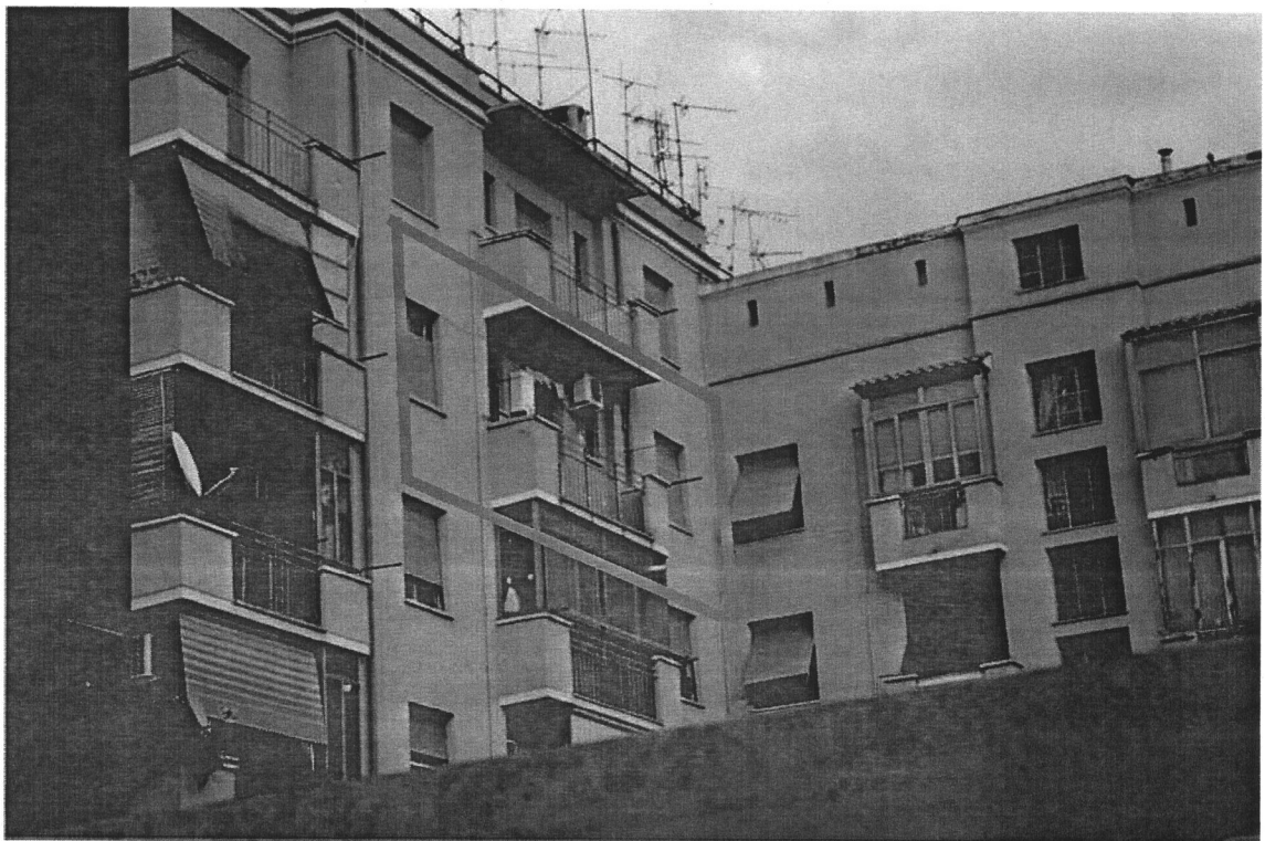
04-Localizzazione dell'unità da una vista sud dell'edificio
