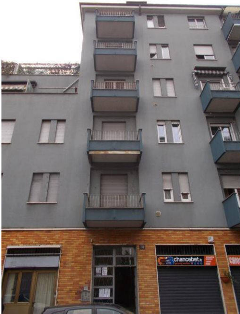
1. Facciata esterna dalla via Iglesias
