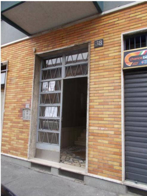
3. Ingresso dal fronte strada
