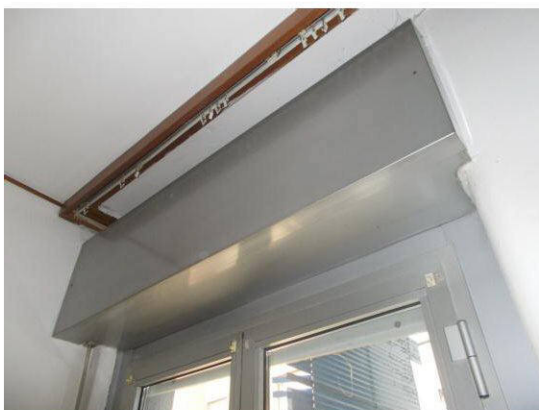
25. Dettaglio di serramento e coprirullo
