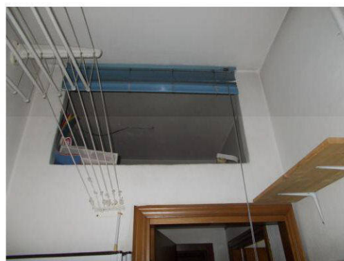
12. Particolare del soppalco del bagno (ingresso ribassato)
