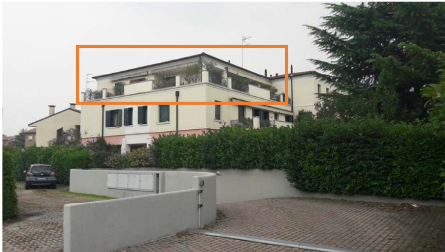
“IMMOBILE A” Prospetto ovest e sud – Via Vecchia Trevigiana
