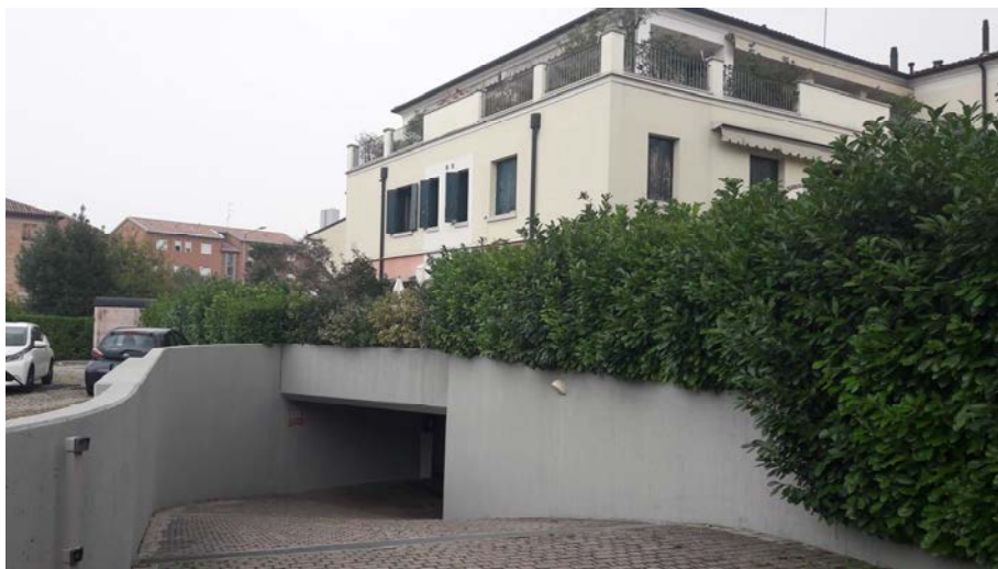
Ingresso garage da Via Vecchia Trevigiana
