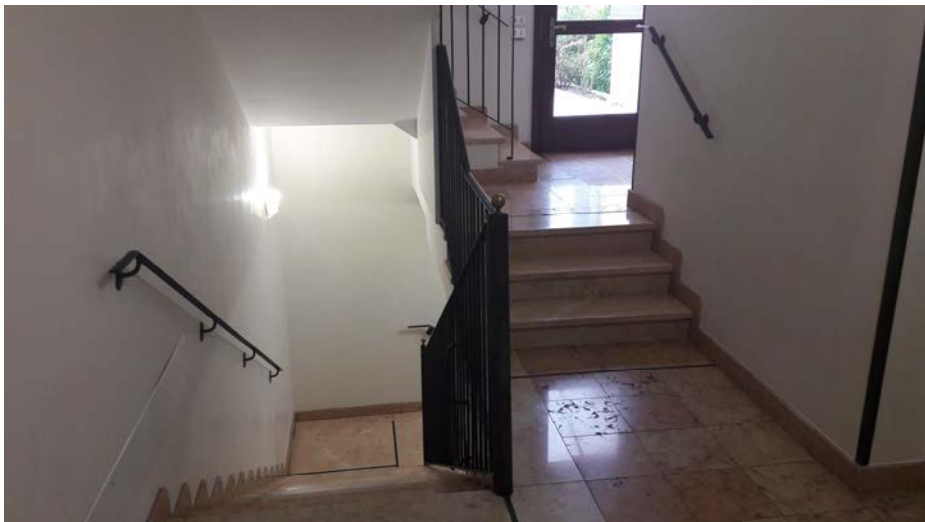
Ingresso vano scale condominiale immobili A e B
