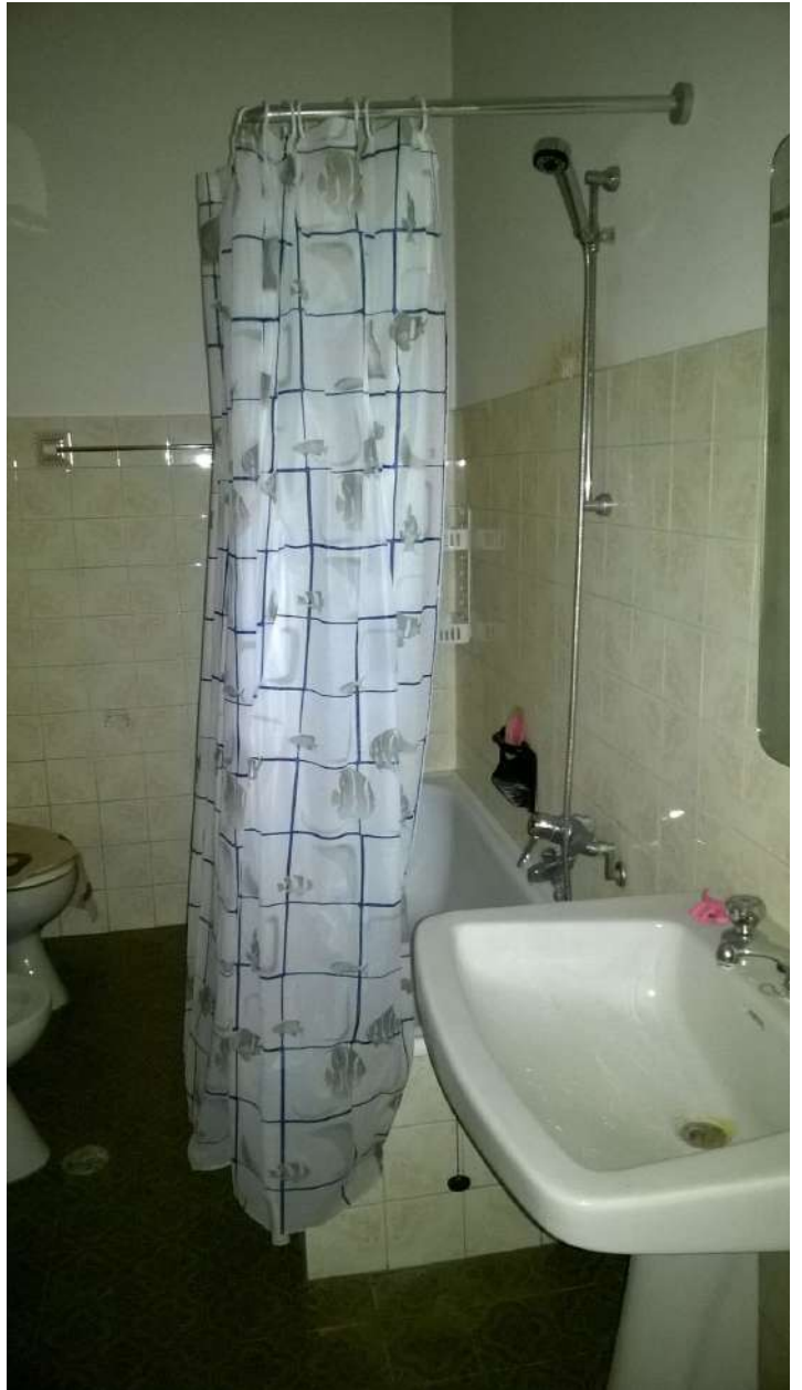
bagno cieco piano primo
