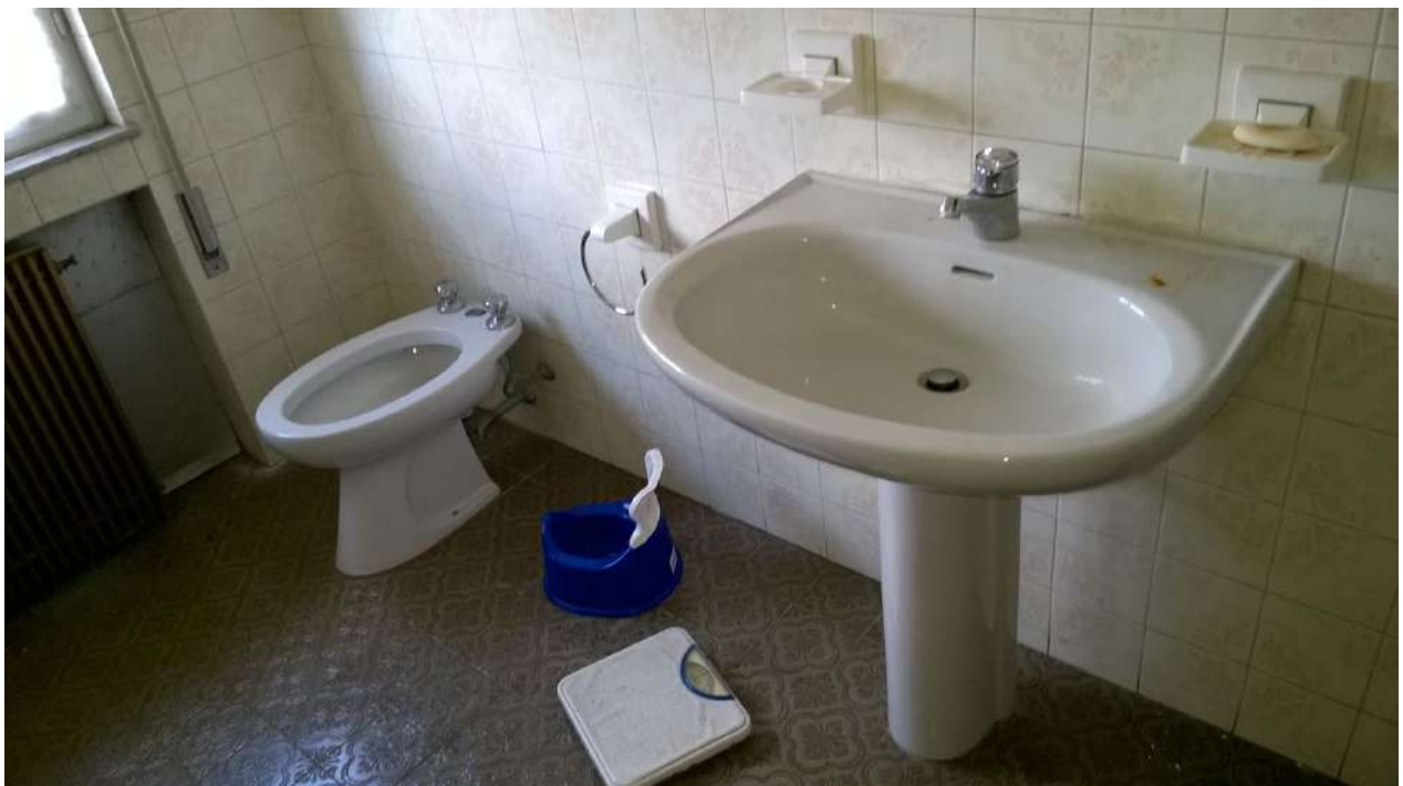
bagno piano primo
