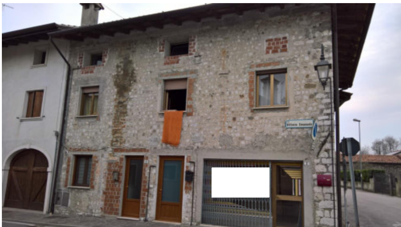
Foto n. 2 – Comune di Vivaro (PN), Foglio 19, particella n°93 – Veduta esterna dell'immobile pignorato, sub 16, con porta di accesso al civico 2/A (posto a lato sx della serranda).
