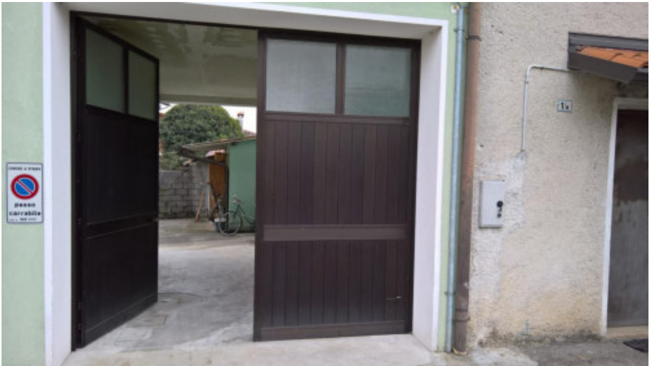
Foto n. 20 - Comune di Vivaro (PN), Foglio 19, particella n°93 sub 16 - Veduta esterna del portico facente parte del compendio pignorato.
