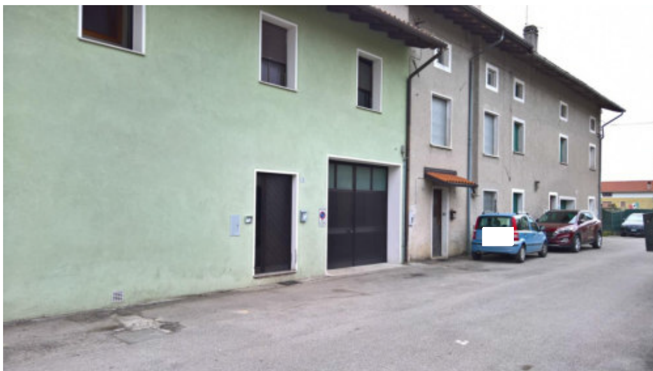
Foto n. 3 - Comune di Vivaro (PN), Foglio 19, particella n°93 sub 16 - Esterni - Accesso esterno al portico, posto a piano terra dell'unità, su cui grava servitù di passaggio con diritto di transito e non di sosta.
