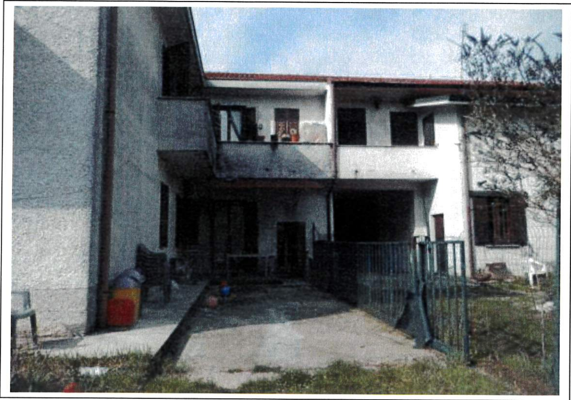
Fotografia n°7 – Vista della facciata interna del fabbricato sul fondo al centro si osserva il balcone “abusivo” al primo piano.
