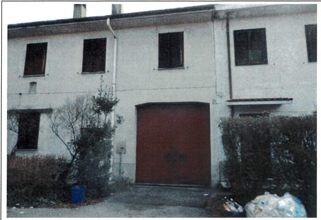
Fotografia n°3 – Vista del portone carroia comune con beni estranei alla procedura.
