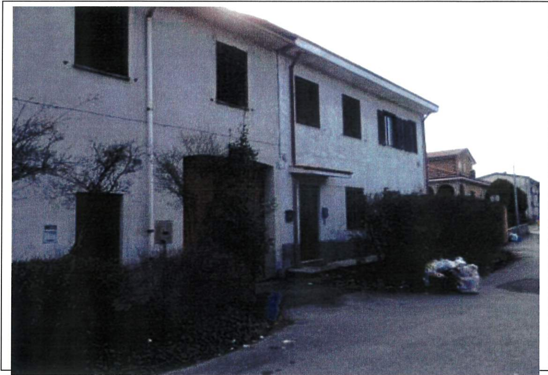
Fotografia n°1 – Vista della facciata fronte strada del fabbricato – si osserva l'area antistante comune e indivisa Particella 520 delimitata da siepi.
