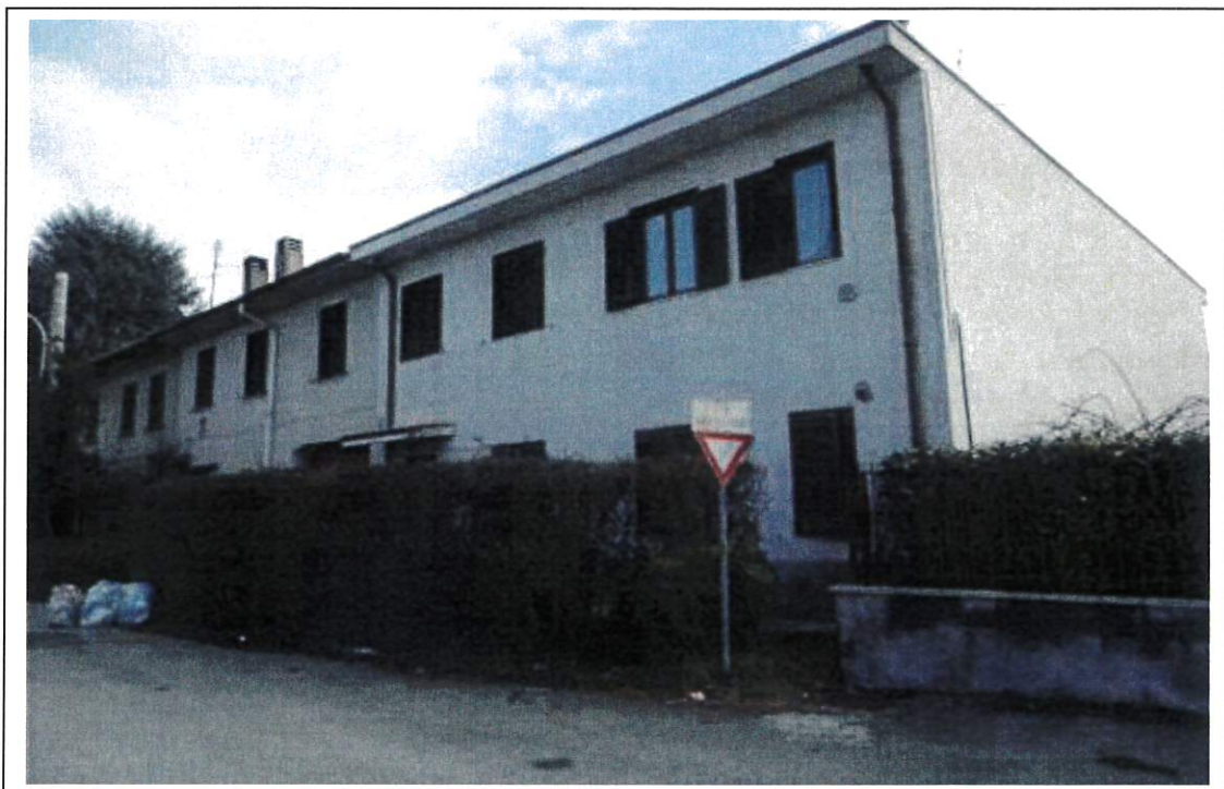
Fotografia n°2 – Vista della facciata fronte strada del fabbricato – si osserva l'area antistante comune e indivisa Particella 520 delimitata da siepi.
