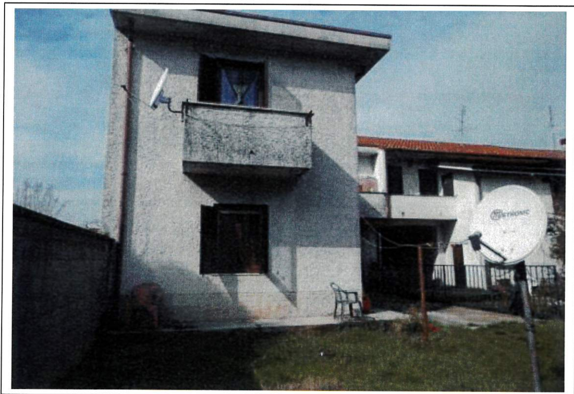
Fotografia n°8 – Vista della facciata interna del fabbricato.
